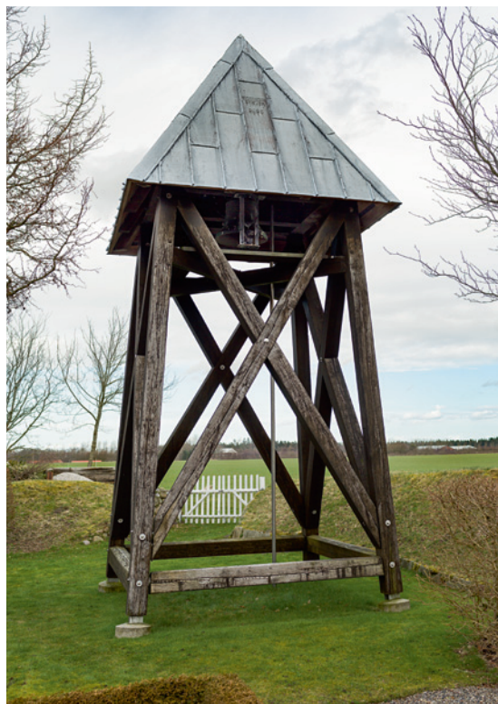
Fig. 58. Klokestabel, 2005, ved kirkegårdens nordøsthjørne. I stablen anes klokke nr. 2, udført 2004 (s. 2559, 2594). Foto Arnold Mikkelsen 2017. – Bell frame, 2005, at the northeastern corner of the churchyard. In the frame bell no. 2, made in 2004, can be made out.
