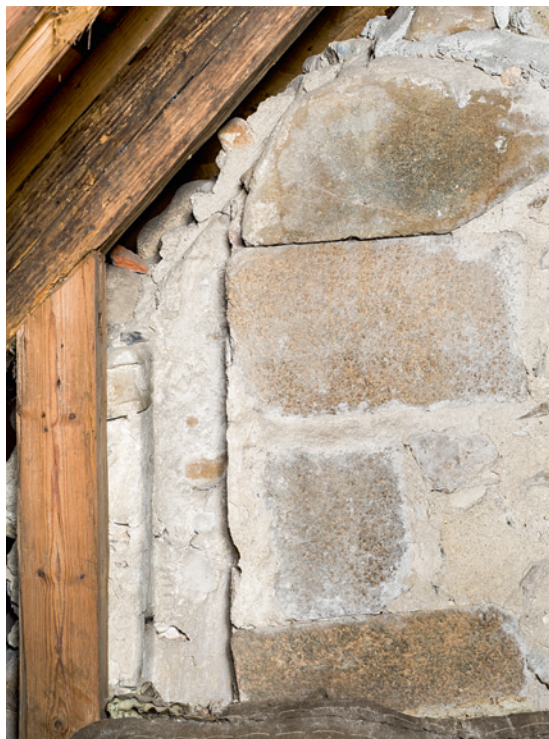
Fig. 59. Detalje af skibets vestgavl set mod vest med aftryk af oprindelig spærstiver (s. 2572). Foto Arnold Mikkelsen 2016. – Detail of west gable of nave looking west with impression of original rafters.
