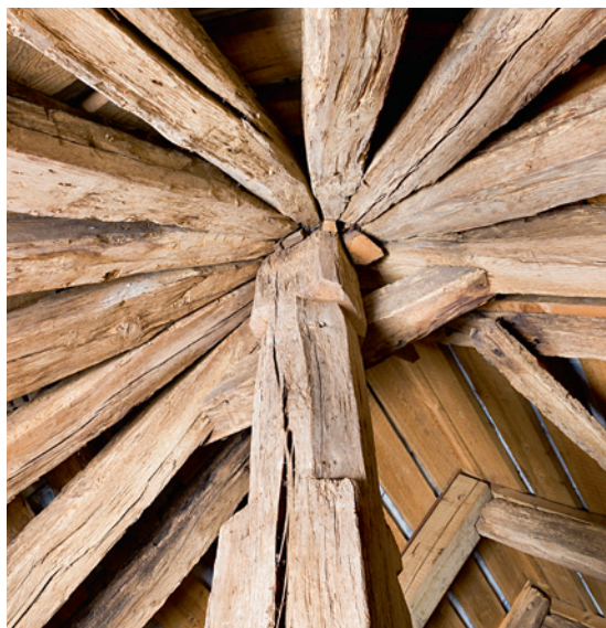
Fig. 24-25. Apsistagværk. 24. Detalje set mod sydvest (s. 2572). 25. (th.) Kongestolpe (o. 1445-50) i apsistagværket set mod nordøst (s. 2572). Foto Arnold Mikkelsen 2016. – Apsø roofing. 24. Detail, looking south west. 25. (right) Kingpost (c. 1445-50) in apse roofing looking north east.
