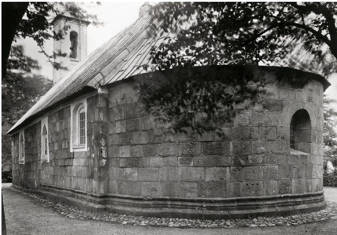
Fig. 27. Ydre set fra sydøst. Foto signeret V. H. (Victor Hermansen) 1937. – Exterior seen from the south east.
