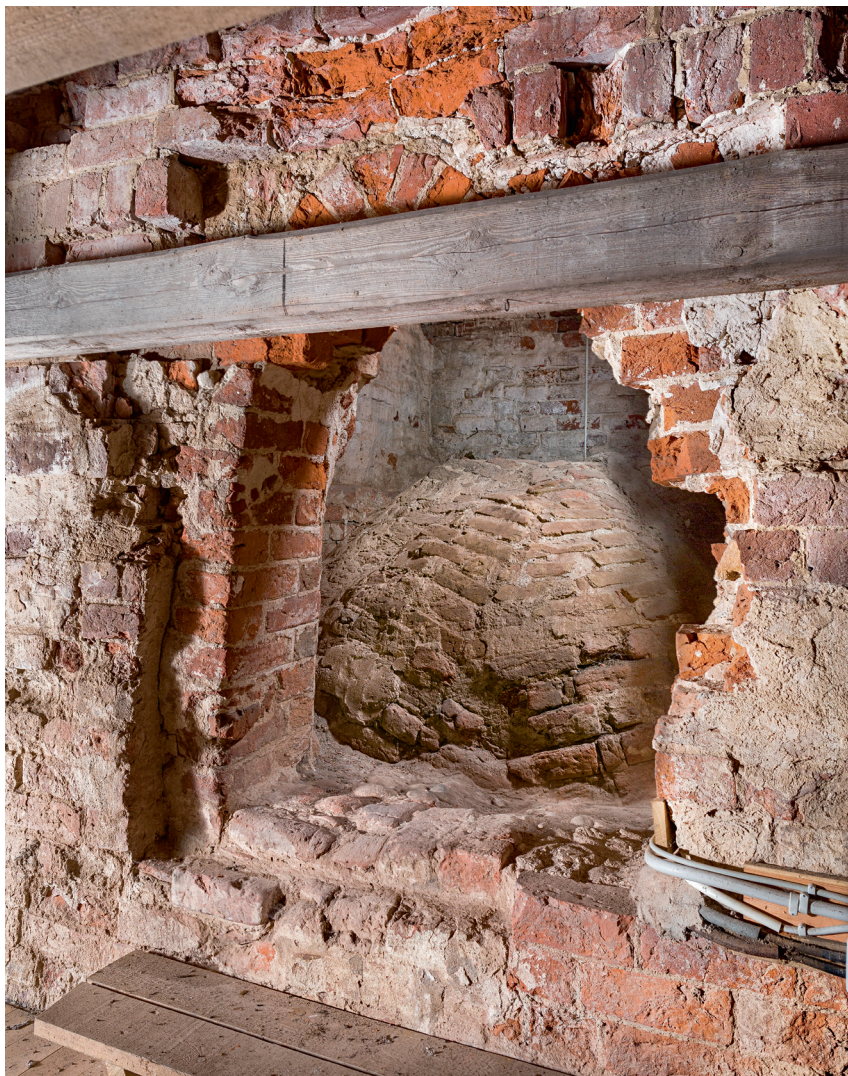
Fig. 14. Dør mellem skibets loft og tårnets mellemstokværk set mod sydvest (s. 2694). Foto Arnold Mikkelsen 2017. – Door between the nave loft and the middle storey of the tower, looking south west.
