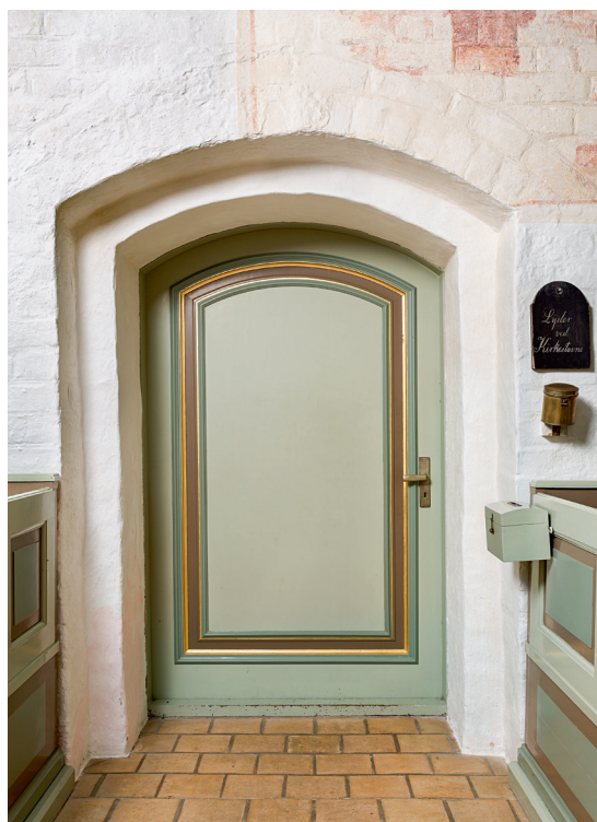
Fig. 11. Skibets norddør set indefra (s. 2690). Dørfloj, o. 1930 (s. 2727). Til højre er ophængt kirkestævnetavle, 1800-tallet (s. 2727), pengebøsse, o. 1862 (s. 2727) og pengeskabe, nyere (s. 2727). Foto Arnold Mikkelsen 2017. – North door of the nave seen from the inside. Door wing, c. 1930. Right: Parish meeting board, 1800s, poor box, c. 1862, and cash box, recent.
