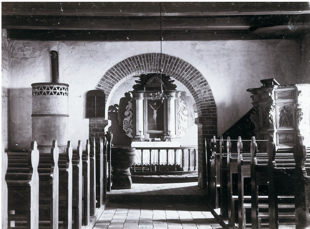
Fig. 28. Indre set mod øst. Ældre foto før 1917 i NM. – Interior looking east.
