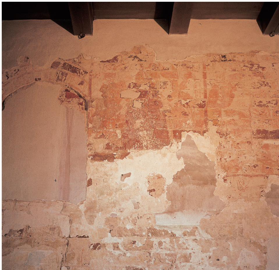
Fig. 26. Kalkmalede \dagger udsmykninger o. 1512 på korets nordvæg (s. 2707). Foto Olaf Hellvik 1974. – Wall-painted \dagger decorations c. 1512 on the north wall of the chancel.
