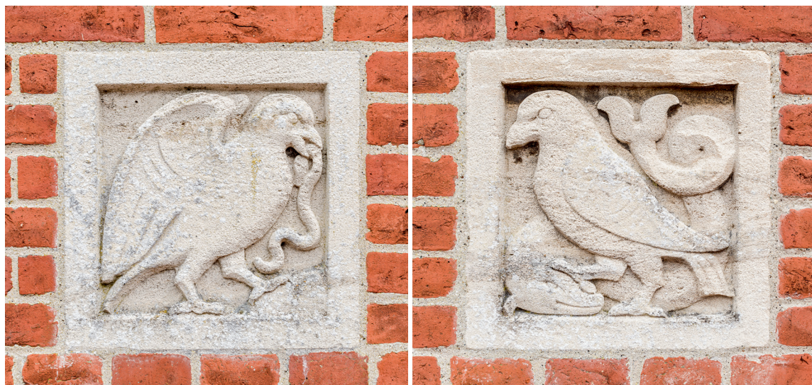
Fig. 6-7. Sandstensornamenter med fuglemotiver på tårnets vestfacade (s. 2917). Foto Arnold Mikkelsen 2018. – Sandstone ornaments with bird motifs on west facade of tower.
