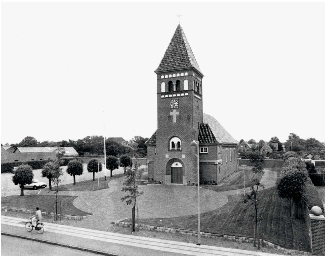
Fig. 8. Ydre set fra sydvest. Foto o. 1985 i Vinderup Egnshistoriske Arkiv. – Exterior seen from the south west.
