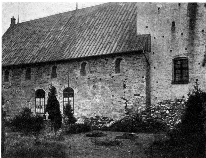
Fig. 14—15. Starup. Midtskibets nordmur. 14. Efter pudsaftankningen. 15. Efter restaureringens påbegyndelse; foto i Landesamt f. Denkmalpflege, Schlesw.-Holst.
