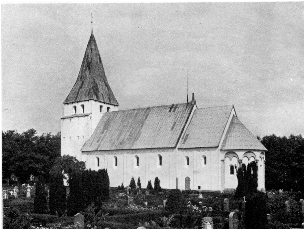
Fig. 1. Lintrup. Ydre, set fra sydøst.
