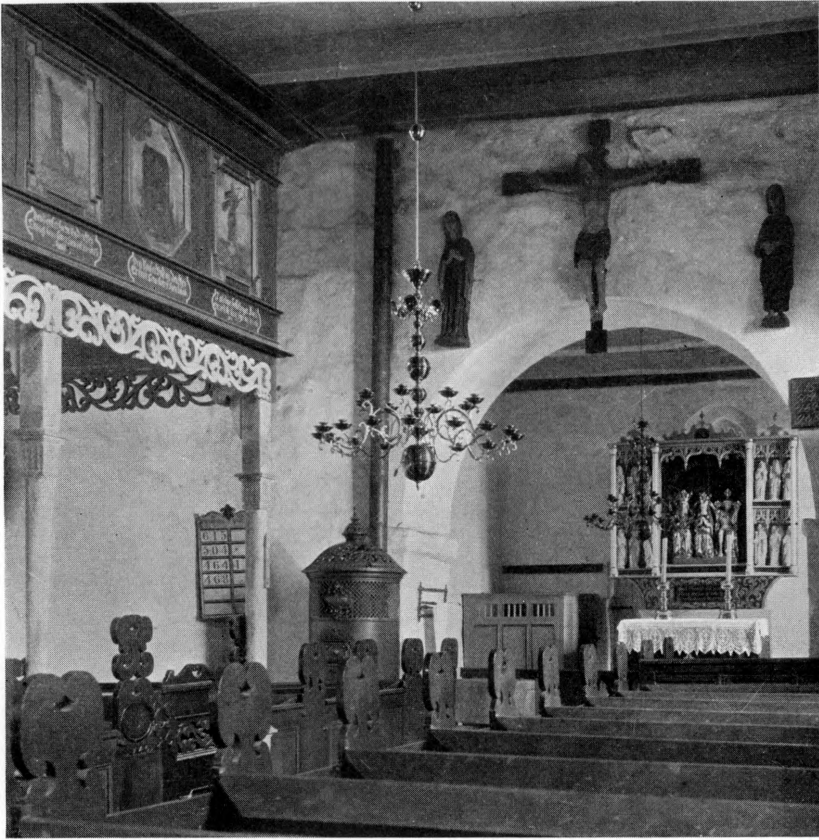
Fig. 3. Branderup. Indre, set mod øst, før restaureringen.
