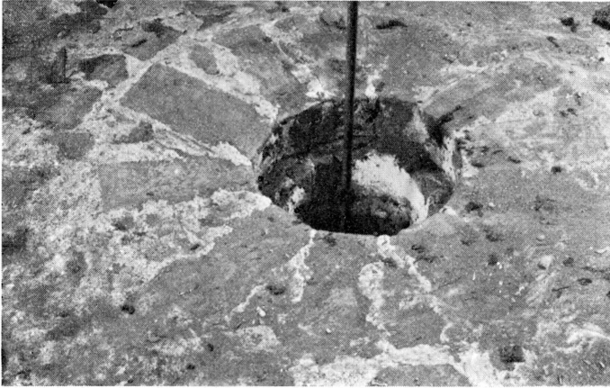
Fig. 6. Bevtøft. Korhælvets isse med det murede hul, set ovenfra (p. 891).
