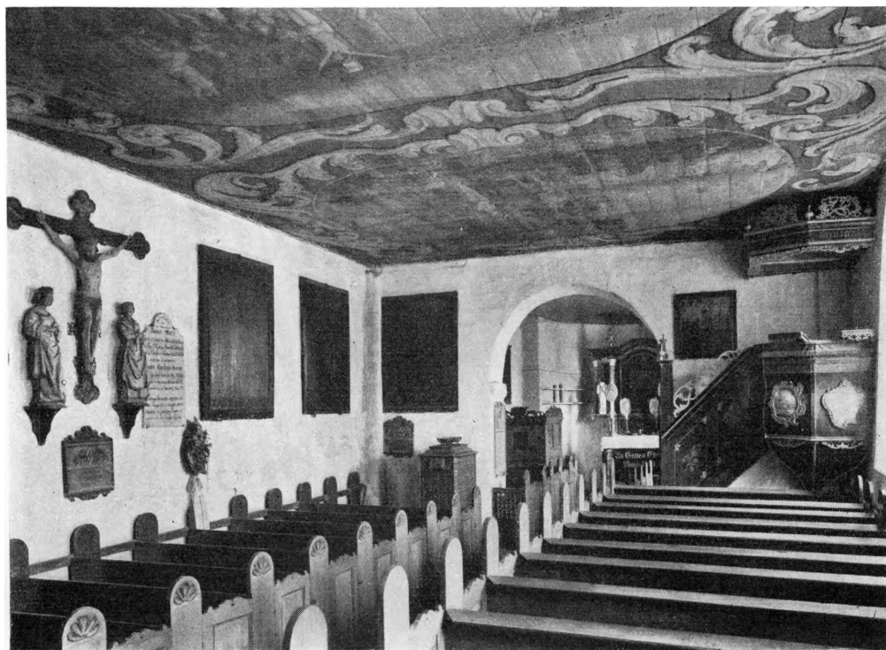
Fig. 5. Ubjærg. Indre, set mod øst, før restaureringen 1942.
