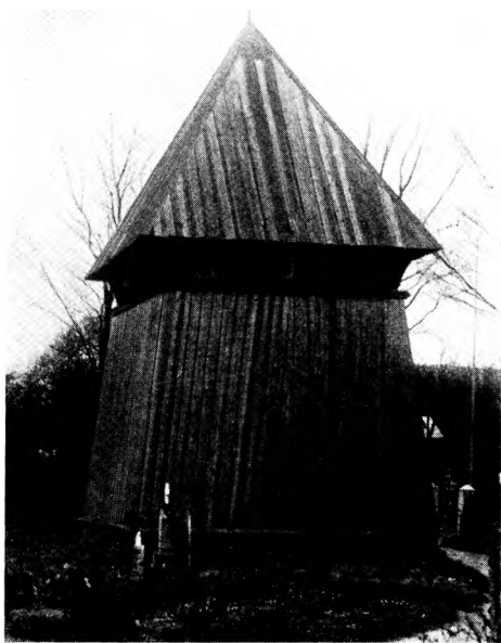
Fig. 3. Bov. †Klokkehus, nedrevet 1905. Fot.: Landesamt f. Denkmalpflege Schl.-Holst, (p. 2025).
