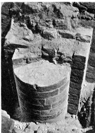
Fig. 21. Sorø. Vægpile paa Højkirkemuren over Nordre Sideskibs Hvælv (S. 35).
