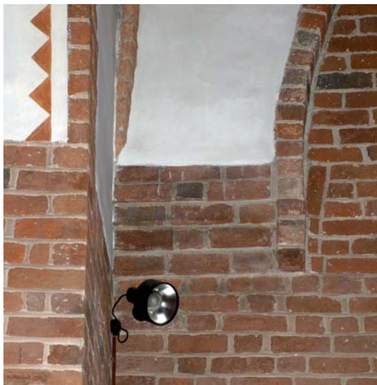
Fig. 142. Tiltretning af hvælv i korforlængelsens nordside (s. 143). Foto Marianne Goral Krogh Johansen 2010. – Adjustment of the vaulting in the chancel extension
