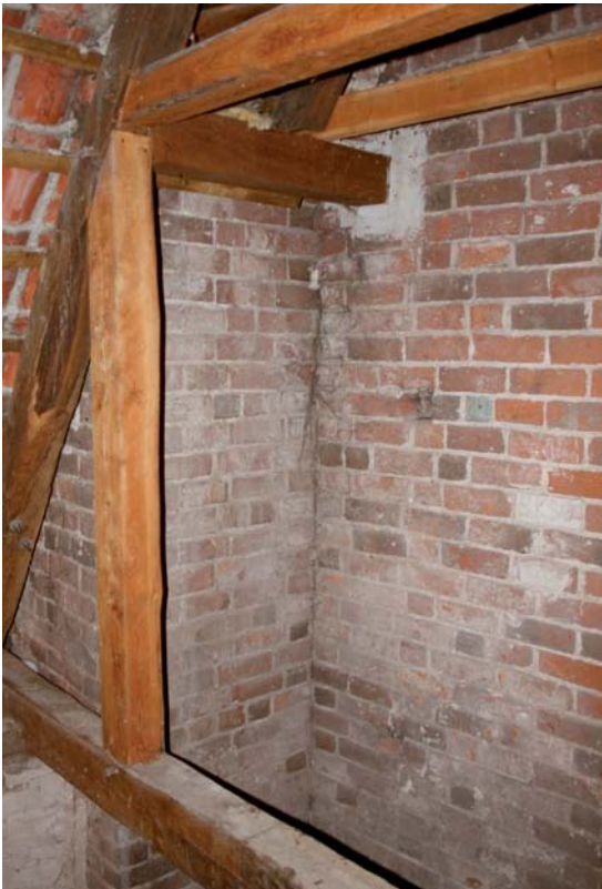
Fig. 140. Korforlængelsens østre stræbepille på nordsiden (s. 121), set fra sakristiets loftsrums. Foto Mogens Vedso 2011. – The eastern buttress on the north side of the chancel extension, seen from the loft of the vestry.
