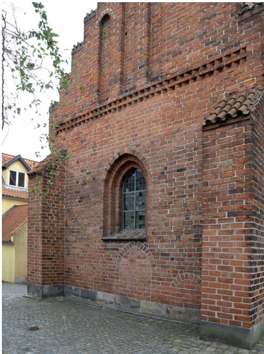
Fig. 67. Nordgavl af sakristi med tre tilmurede stik (s. 146). Foto Marianne Goral Krogh Johansen 2010. – North gable of the vestry with three walled-up relieving arches.
