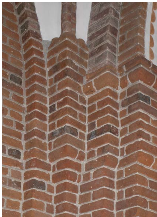
Fig. 52. Senromansk hvælpille med senere tilføjet ribbe i korets sydvestre hjørne (s. 131). Foto Marianne Goral Krogh Johansen 2010. – Late Romanesque vault-pillar, with rib added later, in the southwest corner of the chancel.
