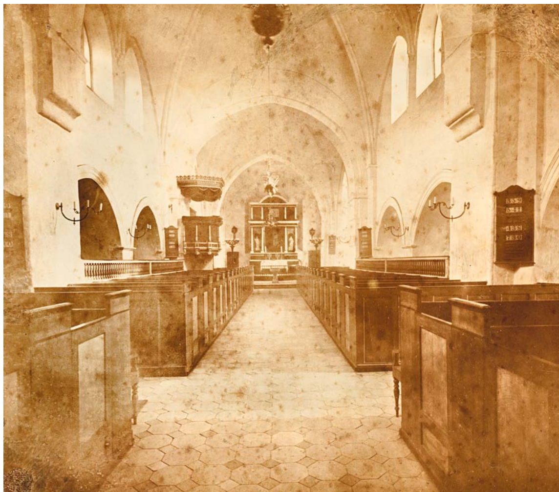
Fig. 106. Indre set mod øst før restaureringen. Foto i Svendborg Museum. – Interior looking east, before the restoration.
