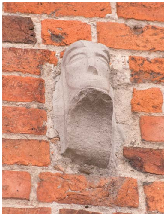
Fig. 70. Konsol af kalksten på tårnets nordside (s. 150). Foto Mogens Vedso 2011. – Limestone corbel of on the north side of the tower.
