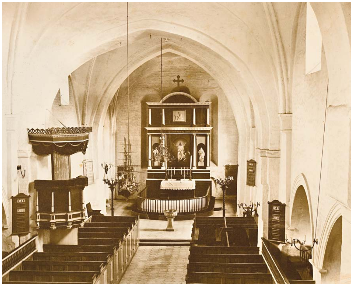
Fig. 84. Indre set mod øst før restaureringen. Foto i Svendborg Museum. – Interior looking east, before the restoration.
