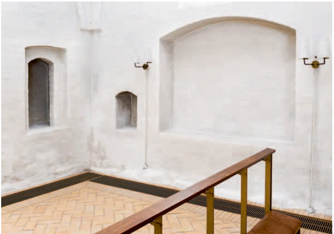
Fig. 22. Korets sydøstre hjørne med tre vægnicher, i øst en opbevaringsniche, i syd en siddeniche (s. 1378). Foto Arnold Mikkelsen 2015. – Southeastern corner of the chancel with three wall niches; in the east a storage niche, in the south a seat niche.
