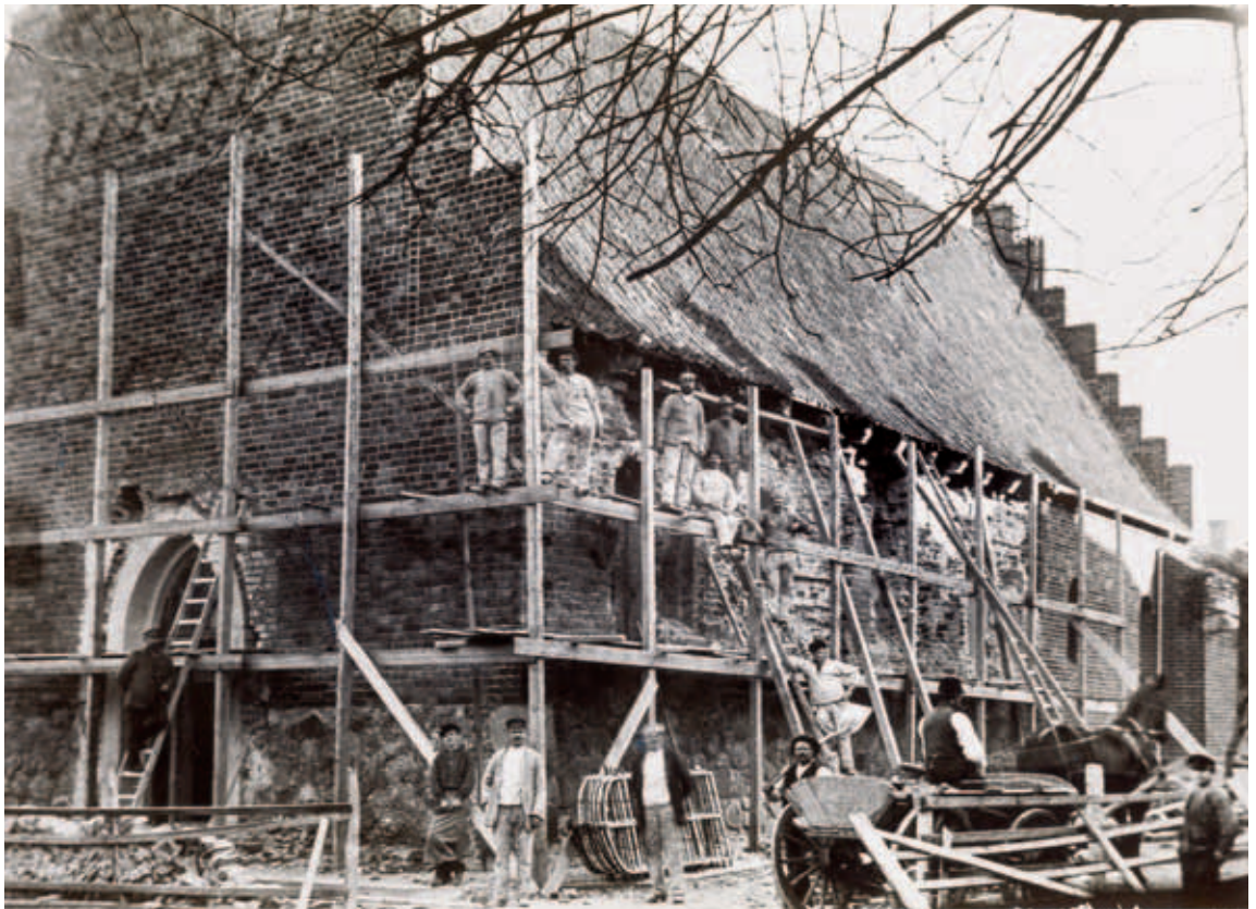
Fig. 41. Kirken, set fra sydvest, under restaureringen i sommeren 1896 (s. 1393). Koret er færdiggjort med en ny murskal og små romanske vinduer. I skibet har man genindsat granitten omkring det tidligere dørsted i syd; i vestgavlen er man ved at nedtage N. S. Nebelongs † portal fra 1837. De udtagne † vinduesrammer af støbejern, også fra 1837, er stillet op ad det tømrede byggestillads. Foto i Rudkøbing Byhistoriske Arkiv. – The church seen from the south west during the restoration in the summer of 1896. The chancel is finished, with a new wall shell and small Romanesque windows. In the nave the granite around the former doorway in the south has been re-installed; in the west gable N. S. Nebelong's †portal from 1837 is being taken down. The removed †window frames of cast iron, also from 1837, are propped up against the timber scaffolding.
