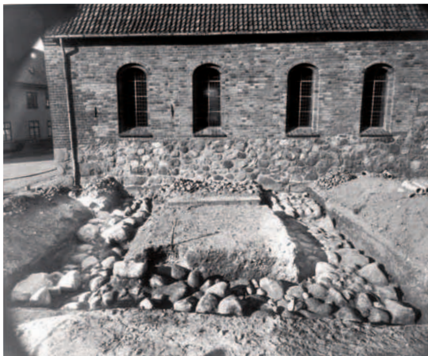
Fig. 31. Fundament til \dagger våbenhuset foran skibets sydside, udgravet 1940 (s. 1385). Foto Chr. Kiilsgaard. I NM. – Foundations of the \dagger porch in front of the south side of the nave, excavated in 1940.
