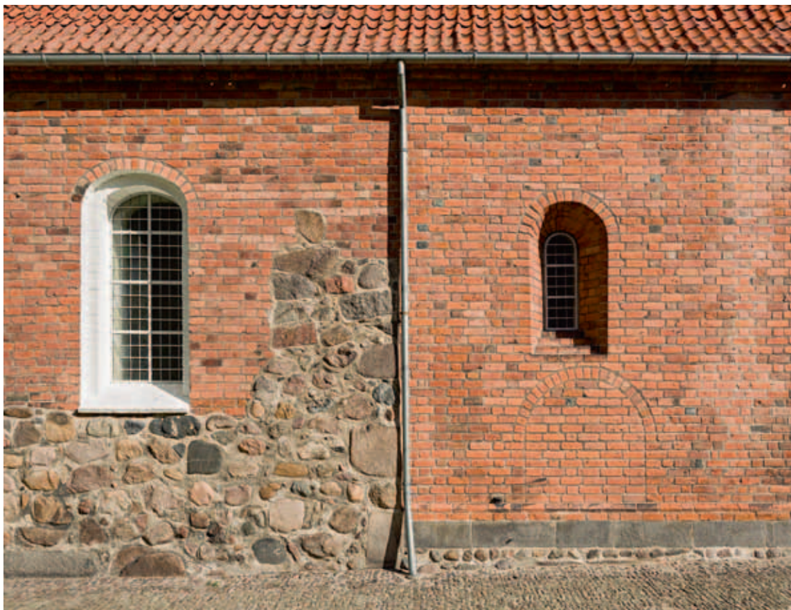
Fig. 17. Udsnit af kirkens sydside. Sammenstødet mellem skibet, hvoraf den nedre del stammer fra (†)kampestenskirken, og koret (s. 1372). I koret ses tilmuret (†)præstedør (s. 1374). Foto Arnold Mikkelsen 2015. – Detail of south side of church. Intersection of the nave, the lower part of which is from the (†)fieldstone church, with the chancel, a bricked-up (†)priest's door.
