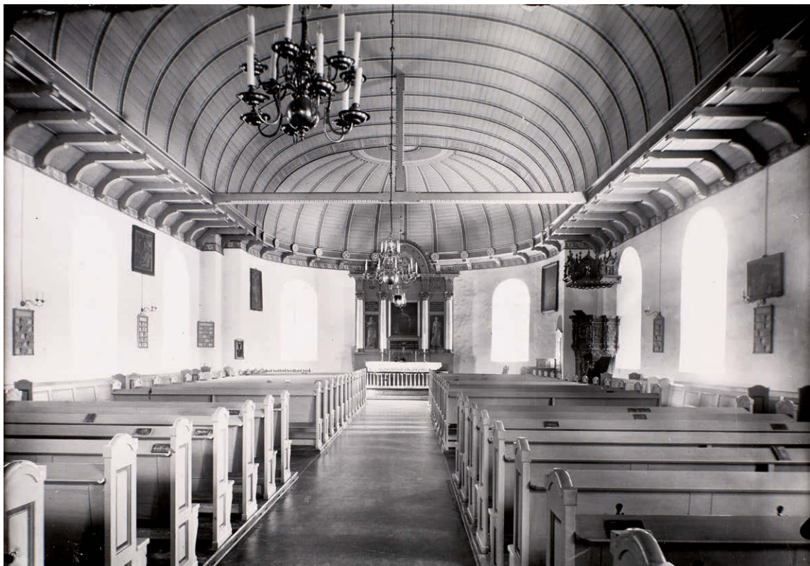
Fig. 23. Indre set mod øst, som det tog sig ud 1894–1950 efter opsætningen af en tømret \dagger tøndehvælvning, udført efter tegning af Niels Jacobsen (s. 1544). Foto 1919. I KB. – Interior looking east as it appeared in 1894–1950 after the installation of a carpentered \dagger barrel vault to a design by Niels Jacobsen.
