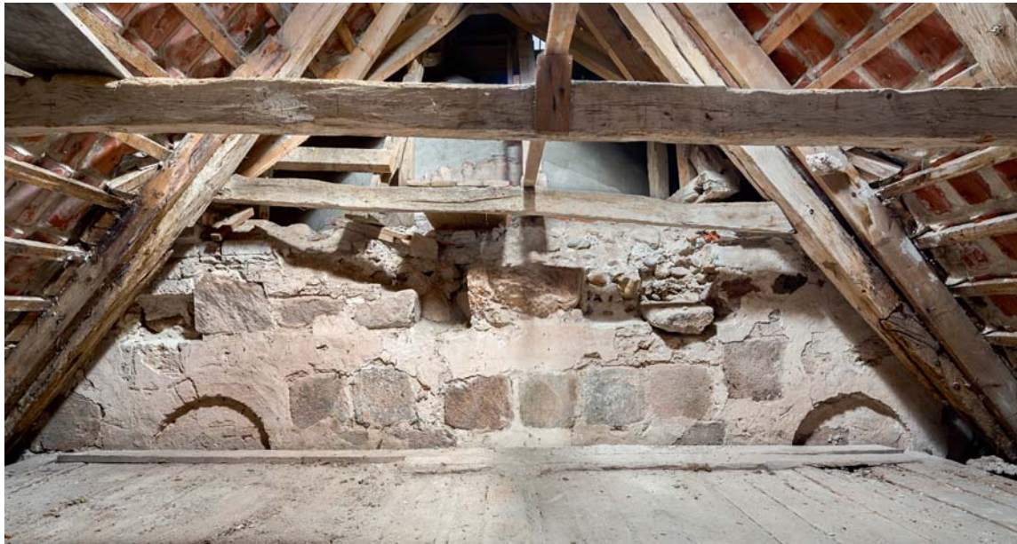
Fig. 13. Romansk murværk set fra våbenhusets loft. Foto Arnold Mikkelsen 2017. – Romanesque masonry seen from the loft of the porch.
