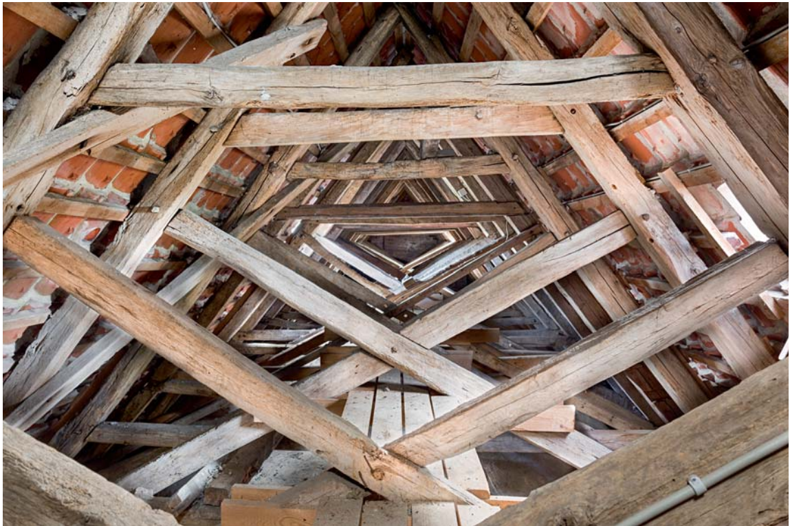
Fig. 31. Skibets tagværk set mod øst (s. 1768). Foto Arnold Mikkelsen 2017. – Roofing of nave looking east.
