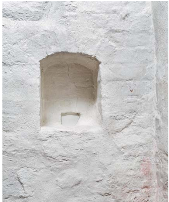
Fig. 20. ( \dagger )Piscina indvendig i korets østmur (s. 1758). Foto Arnold Mikkelsen 2017. – ( \dagger )Piscina in the east wall of the chancel.
