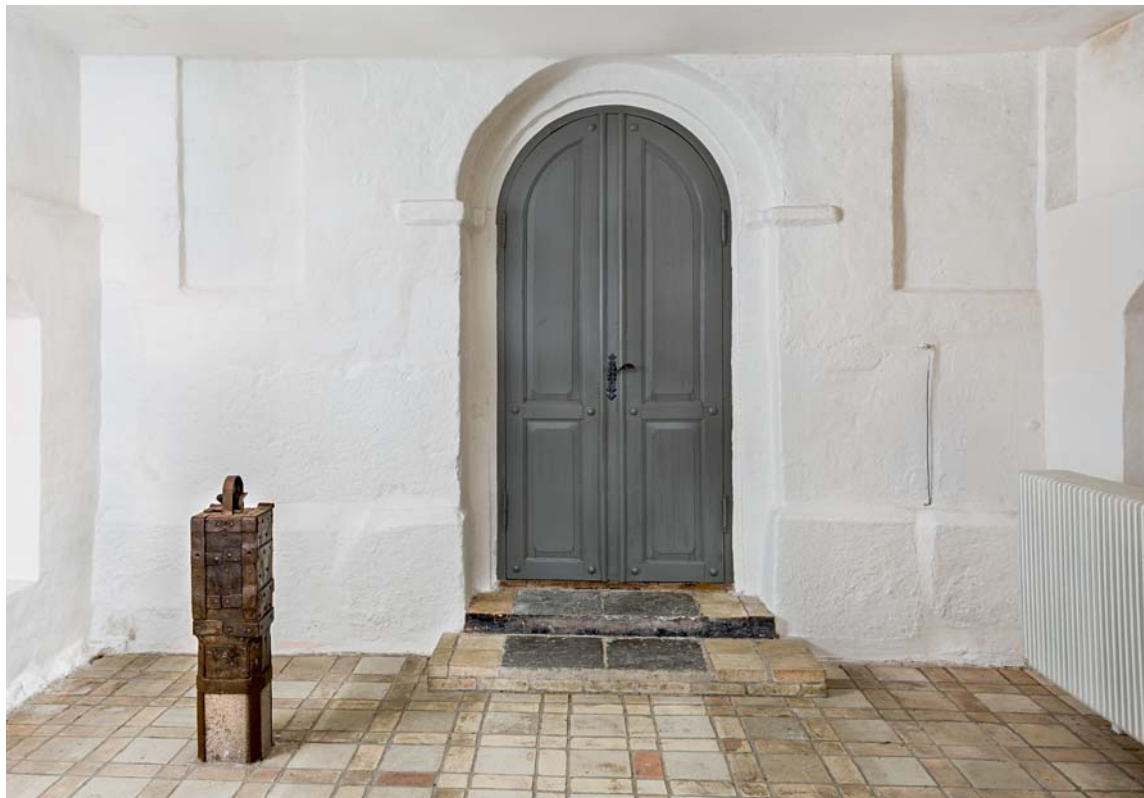
Fig. 14. Våbenhusets indre med romansk syddør set mod nord (s. 1751). Foto Arnold Mikkelsen 2017. – Interior of porch with Romanesque south door, looking north.
