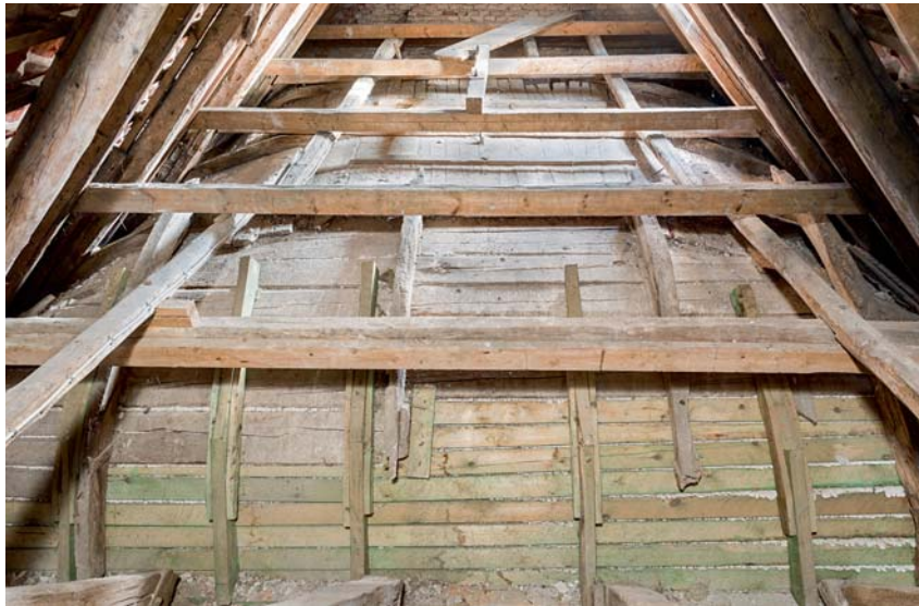
Fig. 28. Korsarmens træbyggede hvælv set mod nord (s. 1765). Foto Arnold Mikkelsen 2017. – Wood-built vault of transept, looking north.
