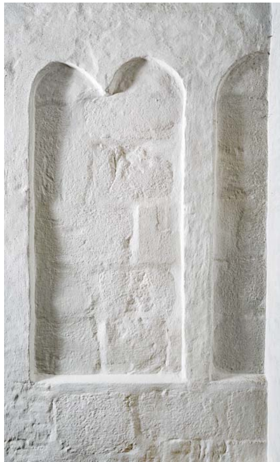
Fig. 18. Romanske blændinger på skibets nordfacade (s. 1750). Foto Arnold Mikkelsen 2017. – Romanesque recesses on the north facade of the nave.
