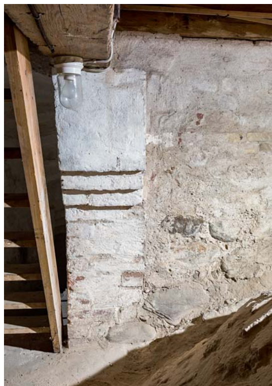
Fig. 65. Støttekonsol til klokkestokværkets gulv (s. 2017). Foto Arnold Mikkelsen 2018. – Support bracket for belfry floor.
