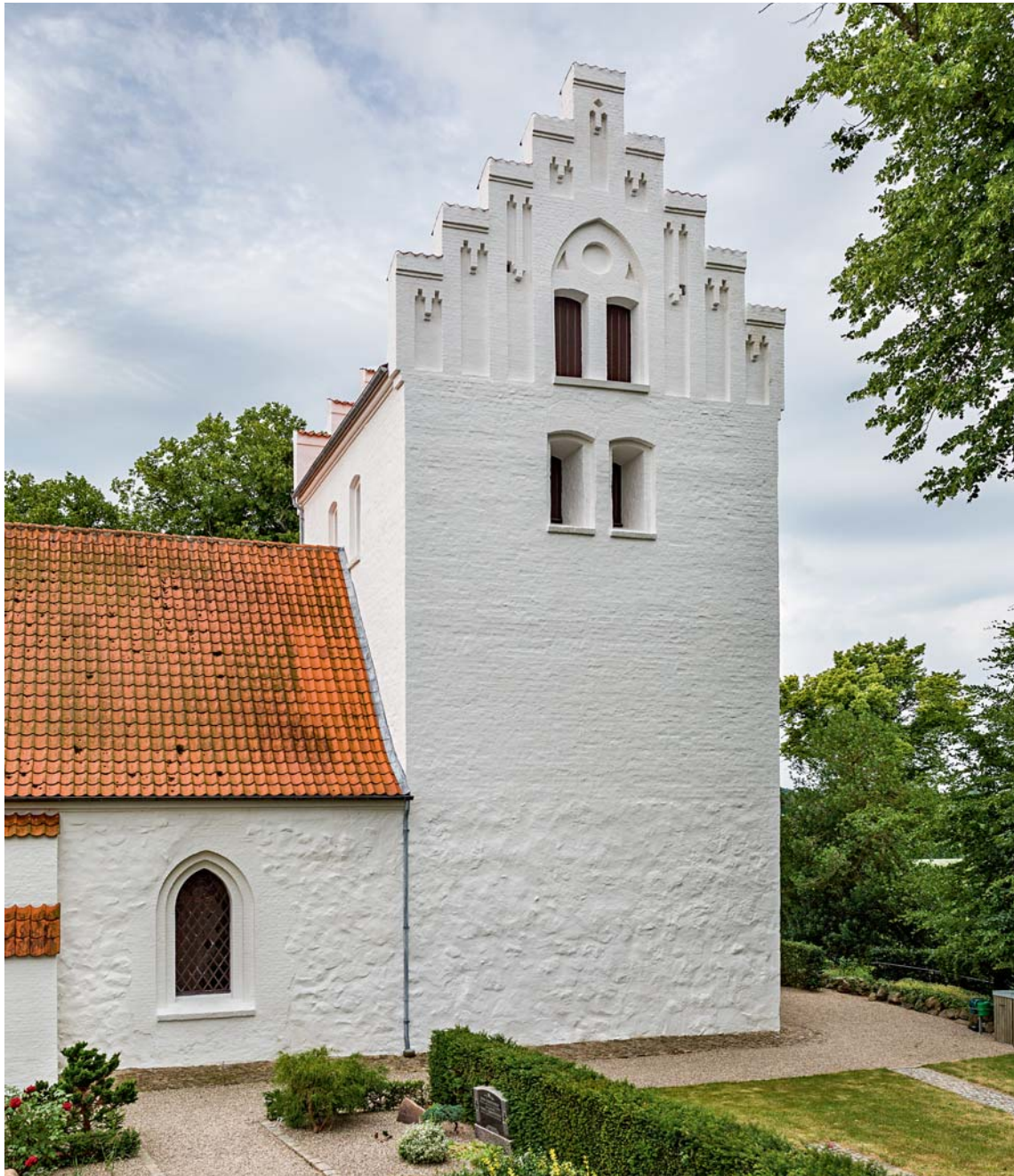
Fig. 11. Tårnet set fra nord (s. 2011). Foto Arnold Mikkelsen 2018. – Tower seen from the north.
