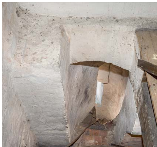
Fig. 12. Overdør til trappehus set fra tårnets klokkestokværk (s. 2012 og 2016). Foto Arnold Mikkelsen 2018. – Overdoor to stairwell seen from the belfry floor of the tower.
