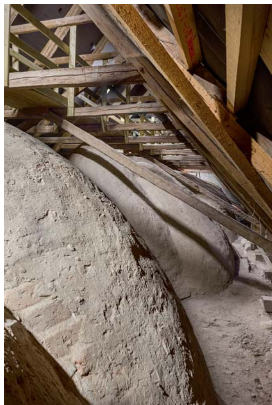
Fig. 13. Skibets tagværk og hvælv set mod øst (s. 2013, 2018). Foto Arnold Mikkelsen 2018. – Roofing and vaulting of the nave looking east.
