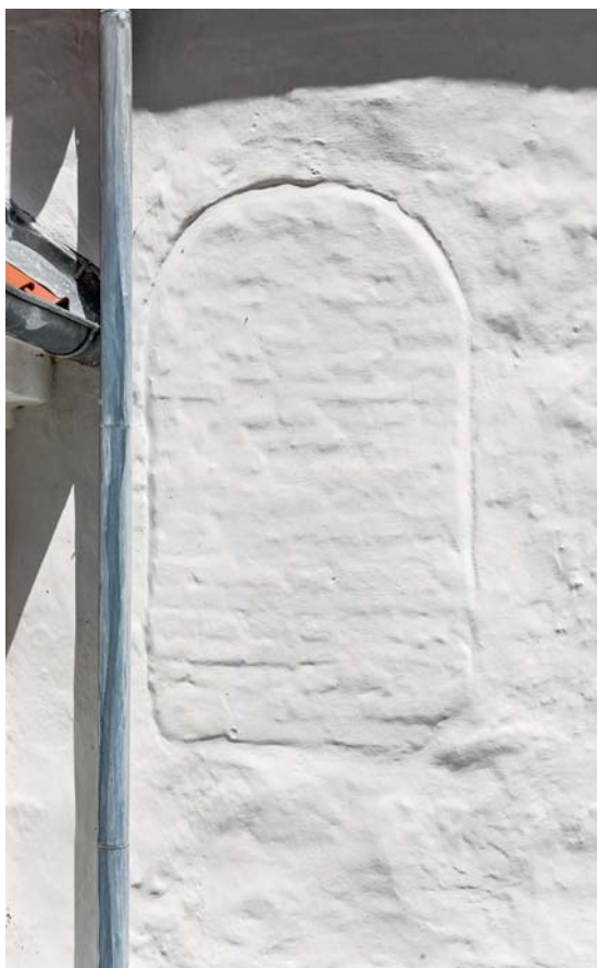
Fig. 64. Tilmuret romansk vindue i skibets sydmur (s. 2010). Foto Arnold Mikkelsen 2018. – Bricked up Romanesque window in south wall of nave.
