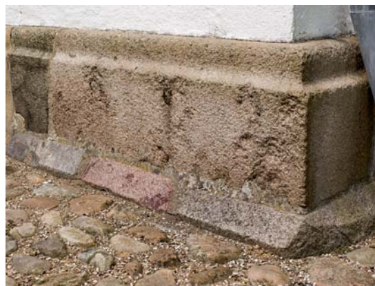
Fig. 9. Den romanske dobbeltsokkel på korets nordøsthjørne (s. 2069). Foto Arnold Mikkelsen 2018. – The Romanesque double footing in the north east corner of the chancel.
