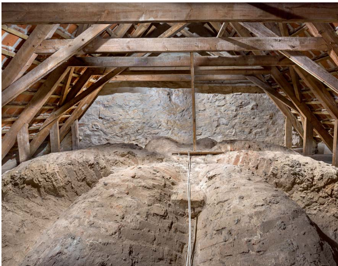
Fig. 25. Korets tagværk og hvælv set mod øst (s. 2079 og 2083). Foto Arnold Mikkelsen 2018. – Roofing and vaulting of the chancel looking east.
