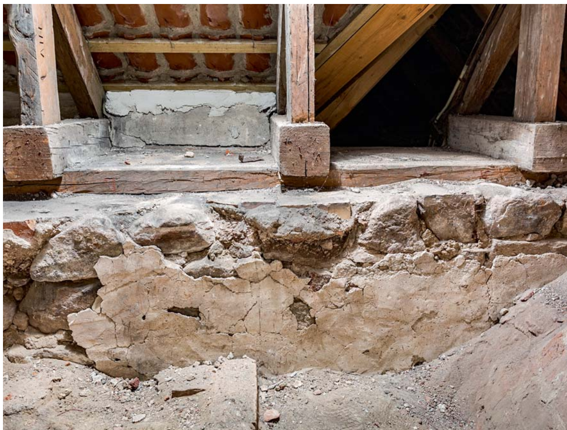
Fig. 20. Romansk kalkning indvendig på skibets murværk set fra loftet (s. 2070). Foto Arnold Mikkelsen 2018. – Romanesque limewashing on inside of nave masonry viewed from the loft.
