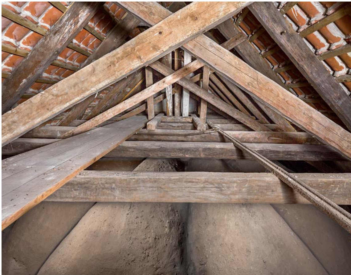
Fig. 24. Skibets tagværk og hvælv set mod vest (s. 2079). Foto Arnold Mikkelsen 2018. – Roofing and vaulting of the nave looking west.
