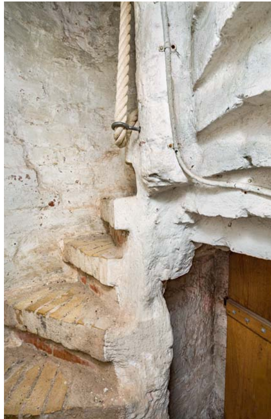
Fig. 22. Trappehusets spindeltrappe, hvor spindlen nederst er borthugget (s. 2074). Foto Arnold Mikkelsen 2018. – Newel staircase in stairwell, with the bottom newel removed.
