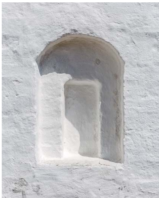
Fig. 15. Tilmuret glug i våbenhusets vestmur (s. 2071). Foto Arnold Mikkelsen 2018. – Bricked-up peephole in west wall of porch.
