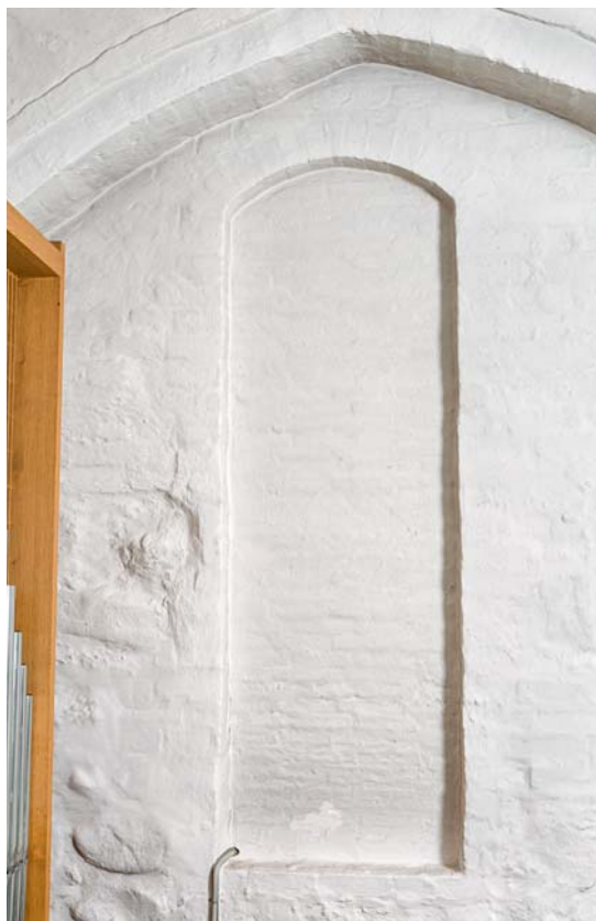
Fig. 21. Tilmuret herskabsindgang i vestforlængelsens nordmur (s. 2130). Foto Arnold Mikkelsen 2018. – Bricked-up family entrance in north wall of western extension.
