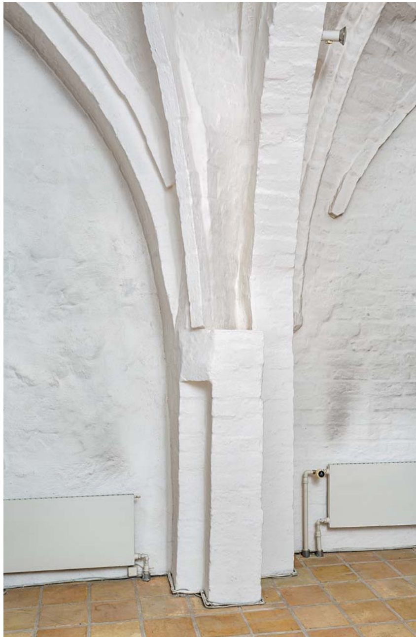
Fig. 13. Hvælvpille og undermuret gjordbue mellem korets to fag (s. 2123). Foto Arnold Mikkelsen 2018. – Vault pillar and reinforcing rib between the two bays of the chancel.
