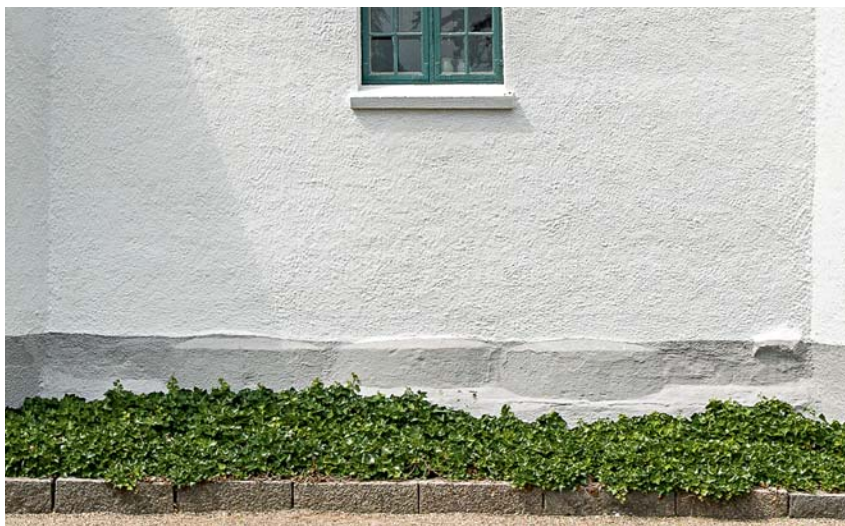
Fig. 79. Genanvendte sokkelkvadre fra tårnapsis i korforlængelsens østgavl (s. 2119). Foto Arnold Mikkelsen 2018. — Reused footing of granite ashlars from tårnapse in the east gable of chancel extension.
