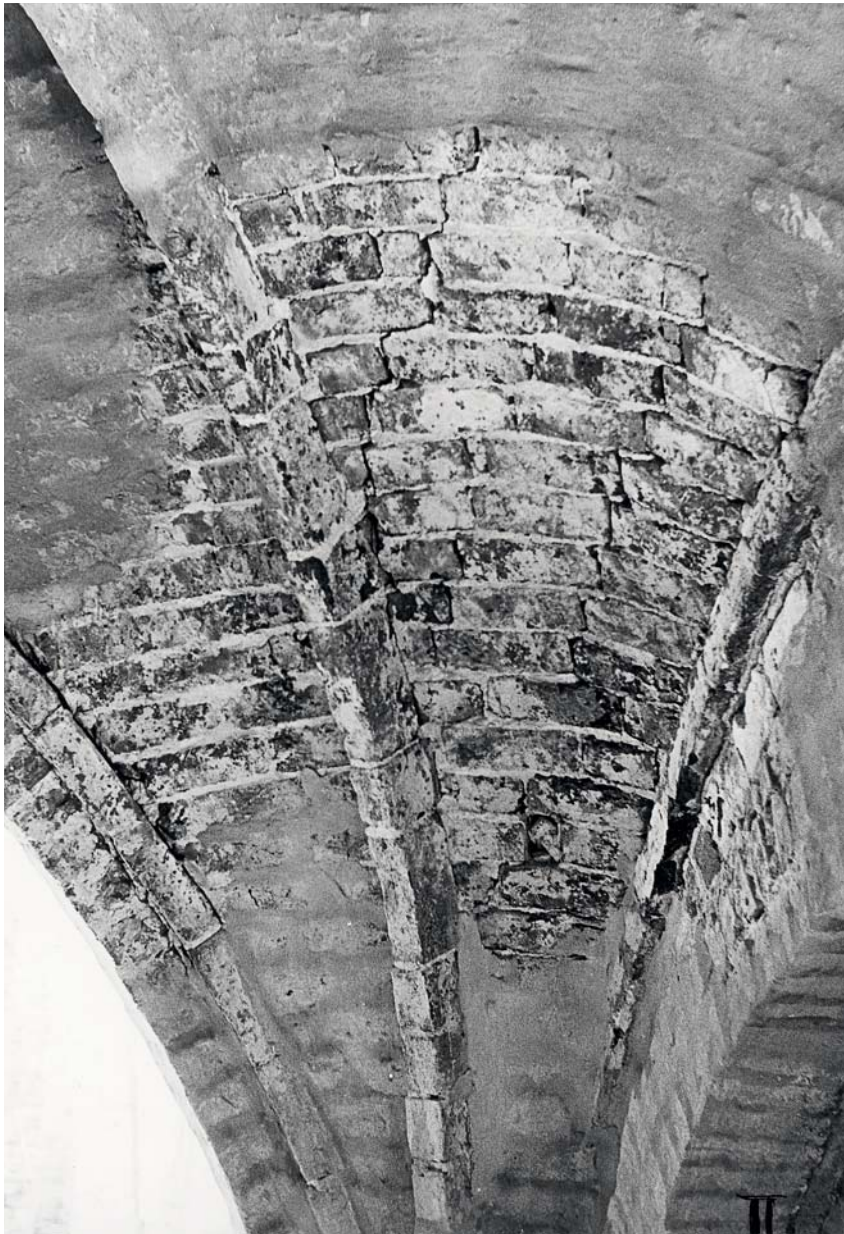
Fig. 26. Istandsættelse af vestforlængelsens hvælv (s. 2134). Foto Finn Bøje 1960. I NM. – Repairs of vaults in western extension.
