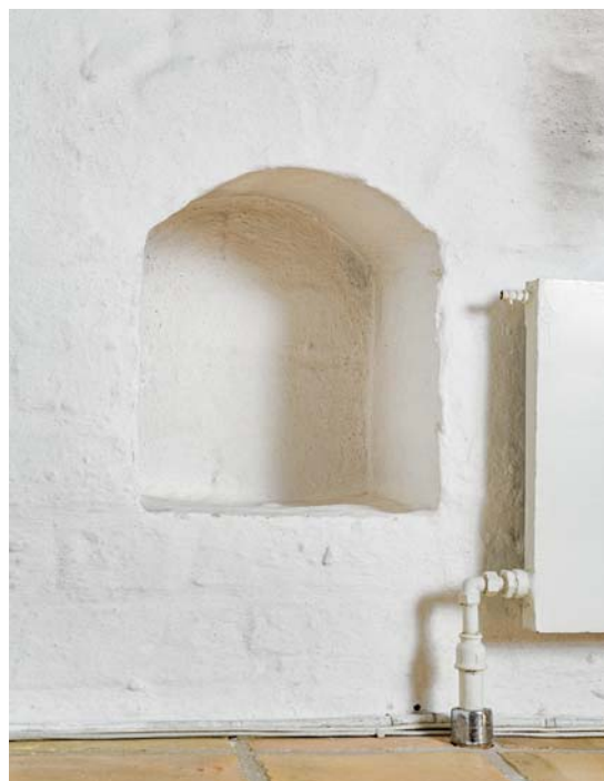
Fig. 82. Niche i korforlængens sydmur (s. 2123). Foto Arnold Mikkelsen 2018. – Niche in south wall of chancel extension.
