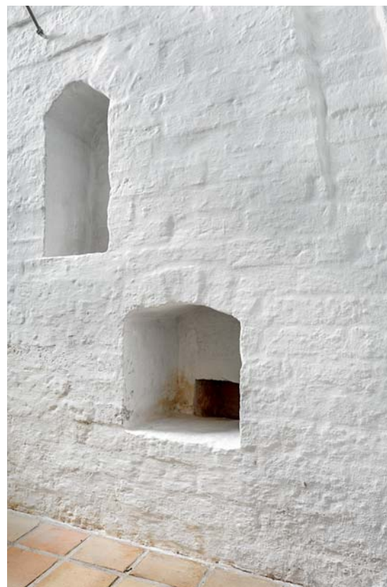
Fig. 16. Niche og piscina i korforlængelsens østgavl (s. 2123). Foto Arnold Mikkelsen 2018. – Niche and piscina in east gable of chancel extension.
