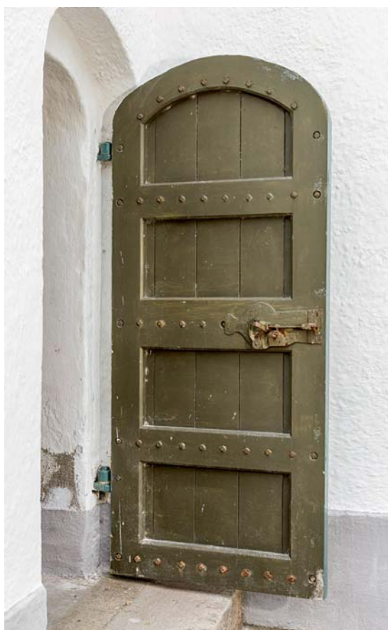
Fig. 59. Udvendig dørfløj nr. 2, antagelig o. 1960, med genanvendt lås og låseblik fra 16-1700-tallet, for opgangen til tårnet (s. 2165). Foto Arnold Mikkelsen 2018. – Outside door wing no. 2, presumably c. 1960, with re-used lock and lock plate from 16-1700s, for stairway to tower.
