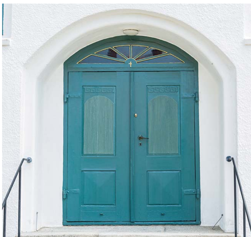
Fig. 60. Udvendige dørfløje nr. 1, 1856/57, i hovedindgangen i tårnets vestmur (s. 2164). Foto Arnold Mikkelsen 2018. – Outside door wings no. 1, 1856/57, in main entrance in west wall of tower.
