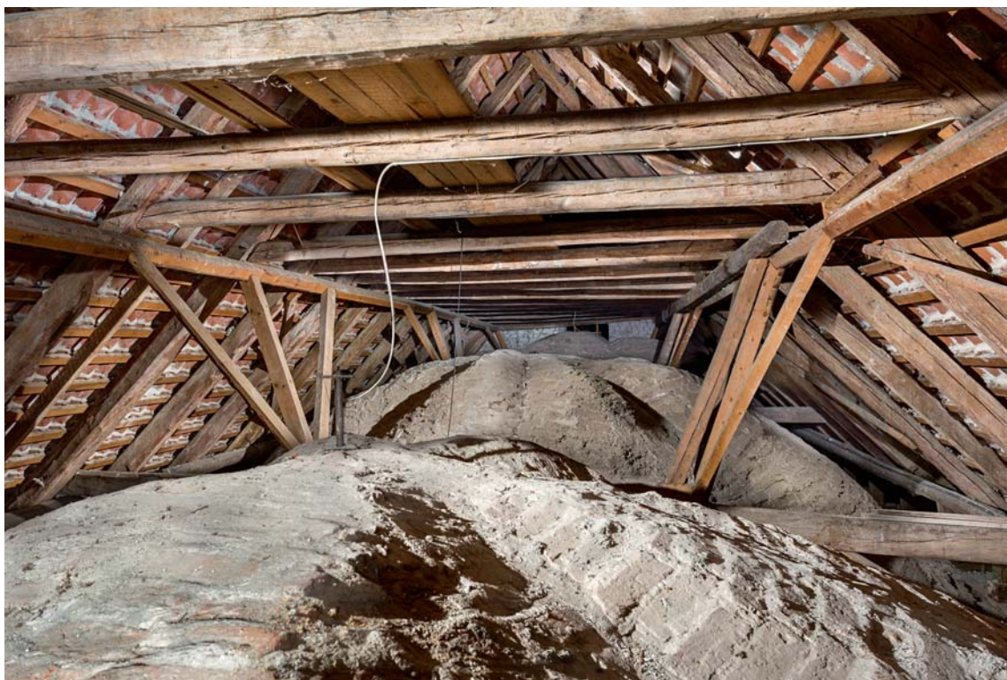
Fig. 24. Skibets tagværk og hvælv set mod vest (s. 2122). Foto Arnold Mikkelsen 2018. – Roofing and vaulting of nave looking west.
