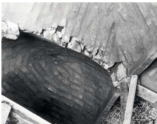
Fig. 25. Istandsættelse af vestforlængelsens hvælv (s. 2134). Foto Finn Bøje 1960. I NM. – Repairs of vaults in western extension.
