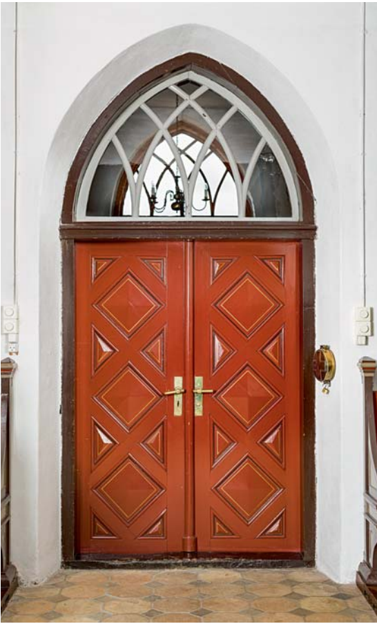
Fig. 16. Dørfloje, 1852, mellem skib og tårnrum (s. 2202). Foto Arnold Mikkelsen 2018. – Door wings, 1852, between nave and tower interior.
