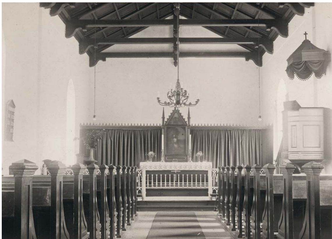
Fig. 9. Indre set mod øst før hovedstandsættelsen 1937. I NM. – Interior looking east before major refurbishing, 1937.
