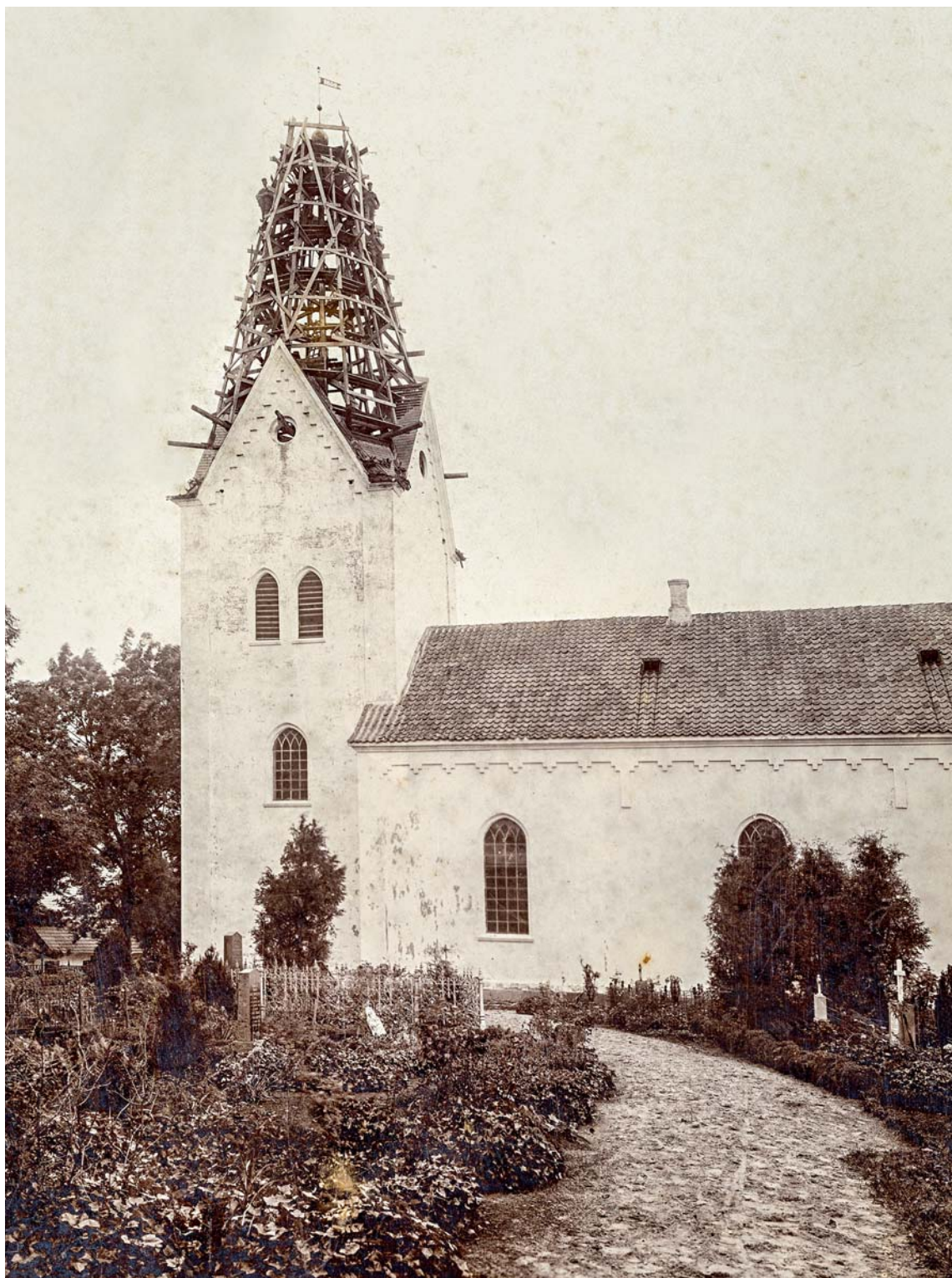
Fig. 24. Istandsættelse af tårnet (s. 2192). Foto Mogens Kjøller 1886. I Egebjerg Lokallhistoriske Arkiv. – Refurbishing of the tower.
