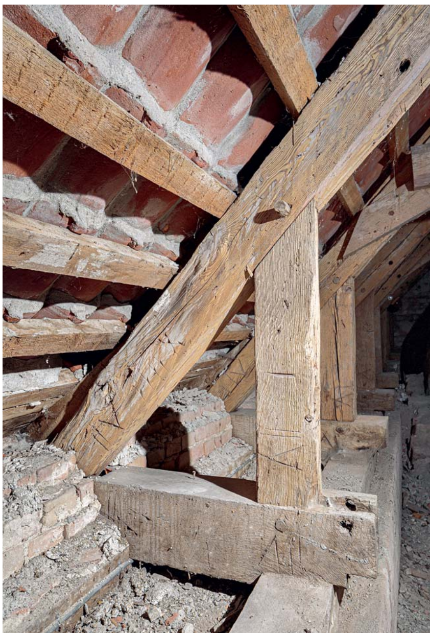
Fig. 39. Forskellige tømmermærker på skibets tagværk (s. 2248). Foto Arnold Mikkelsen 2019. – Various carpenters' marks on the roofing of the nave.
