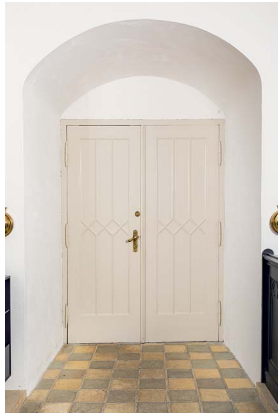
Fig. 18. Den ombyggede, romanske syddør set fra nord (s. 2222). Foto Arnold Mikkelsen 2019. – Rebuilt Romanesque south door, seen from the north.
