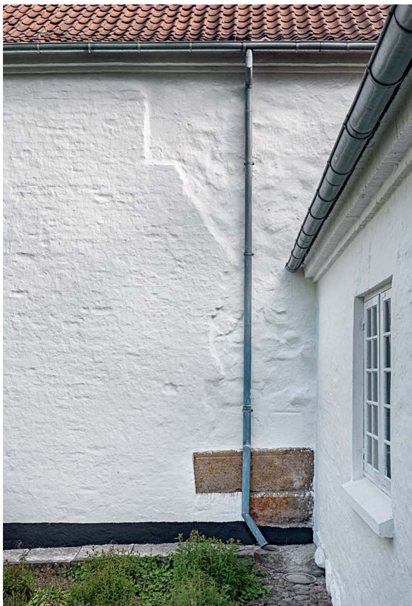
Fig. 162. Sammenstødet mellem det romanske skib og vestforlængelsen (s. 2226), set fra syd. Foto Arnold Mikkelsen 2019. – Junction of the Romanesque nave and the western extension seen from the south.
