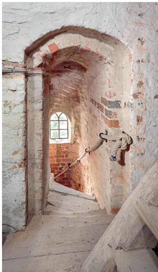
Fig. 25. Tårnets overdør (s. 2228). Foto Arnold Mikkelsen 2019. – Upper door of tower.
