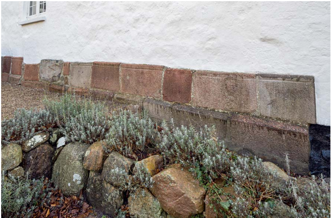
Fig. 14. Skibets romanske dobbeltsokkel (s. 2220) set fra nordvest. Bemærk den tilmurede norddør (s. 2222) længst mod øst. Foto Arnold Mikkelsen 2019. – Romanesque double foundation of the nave seen from the north west. Note the bricked-up north door farthest east.
