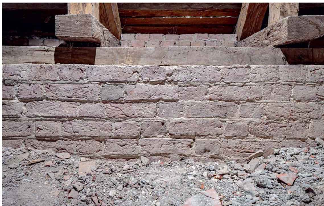
Fig. 163. Vestforlængelsens sydmur med teglsten lagt i polsk skifte, set fra loftet (s. 2226). Foto Arnold Mikkelsen 2019. – South wall of western extension with bricks laid in Flemish bond, seen from the loft.
