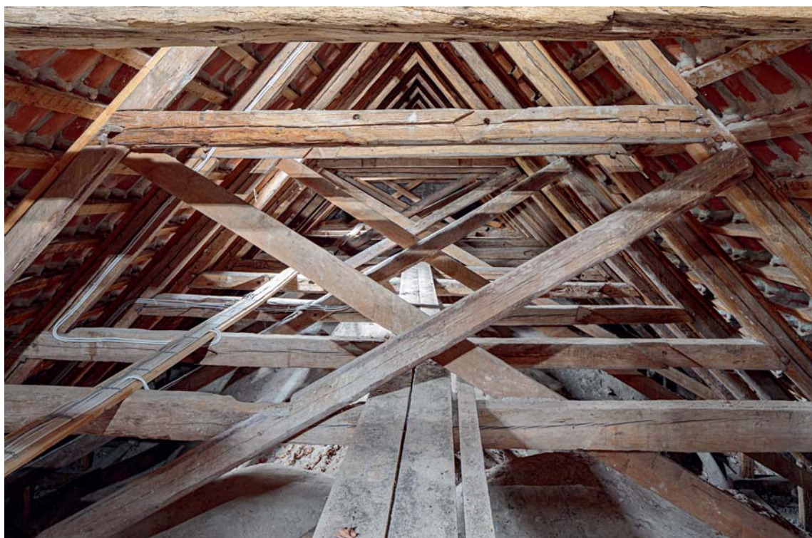
Fig. 40. Skibets tagværk set mod vest (s. 2248). Foto Arnold Mikkelsen 2019. – Roofing of nave, looking west.
