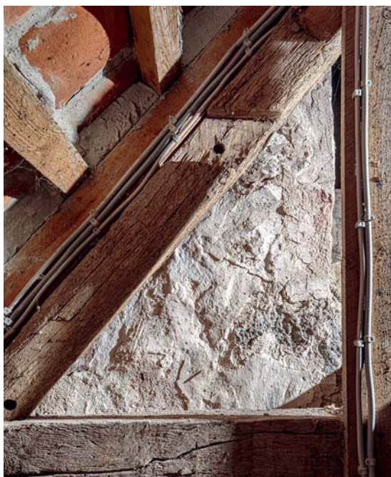
Fig. 161. Romansk puds- og kalklag på skibets søndre langmur (s. 2221), set fra våbenhusets loft. Foto Arnold Mikkelsen 2019. – Romanesque plaster and limewash layer on the southern long wall of the nave, seen from the loft of the porch.
