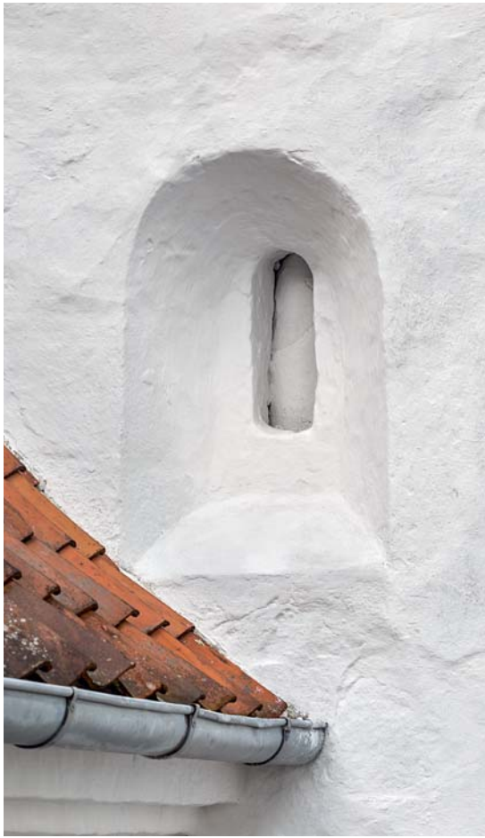
Fig. 17. Romansk vindue på skibets sydside (s. 2223). Foto Arnold Mikkelsen 2019. – Romanesque window on the south side of the nave.
