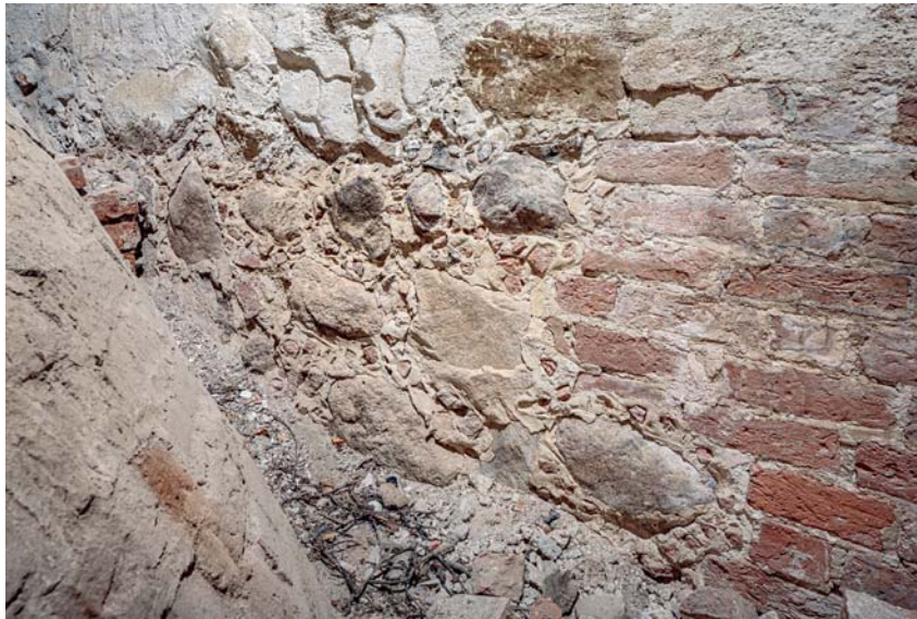
Fig. 41. Det senmiddelalderlige kors østre bagmur med udspækning af tegl i mørtelen (s. 2225). Foto Arnold Mikkelsen 2019. – Eastern back wall of the Late Medieval chancel with pointing of bricks in the mortar.
