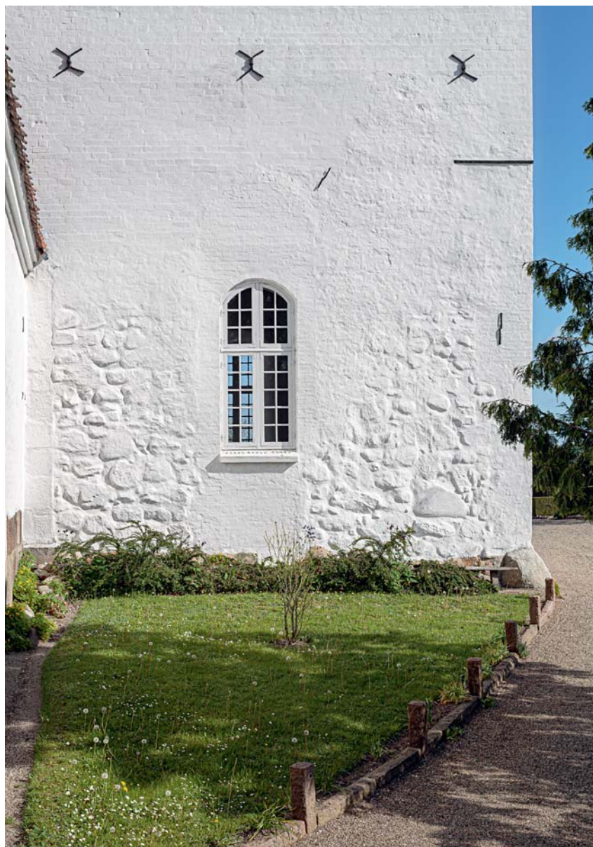
Fig. 42. Tilmuret †præstedør og vindue i højt spejl på tårnets sydside (s. 2227). Foto Arnold Mikkelsen 2019. – Bricked-up †priest's door and window in high recess on south side of tower.
