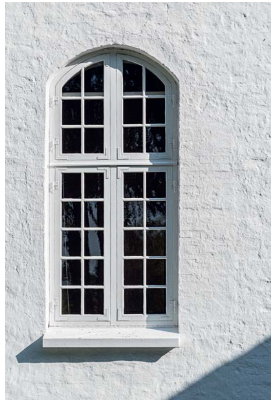
Fig. 20. Tilmuret, flerfalset vindue i vestforlængelsens nordmur (s. 2227). Foto Arnold Mikkelsen 2019. – Bricked-up, multi-bevelled window in the north wall of the western extension.
