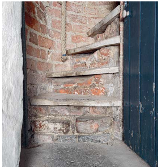
Fig. 24. Trappe i tårnets trappehus; bemærk de slidte oprindelige tegltrin under træbeklædningen (s. 2231). Foto Arnold Mikkelsen 2019. – Stairs in the tower stairwell; note the worn original brick steps beneath the wooden casing.
