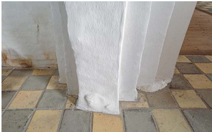
Fig. 43. Den nordre hvælvpille mellem skibets første og andet fag, hvis placering er skæv, da den sandsynligvis erstattede den romanske †triumfmur (s. 2224). Foto Arnold Mikkelsen 2019. – The northern vault pillar between the first and second bay of the nave, the placing of which is off-centre, since it probably replaced the Romanesque †chancel arch wall.
