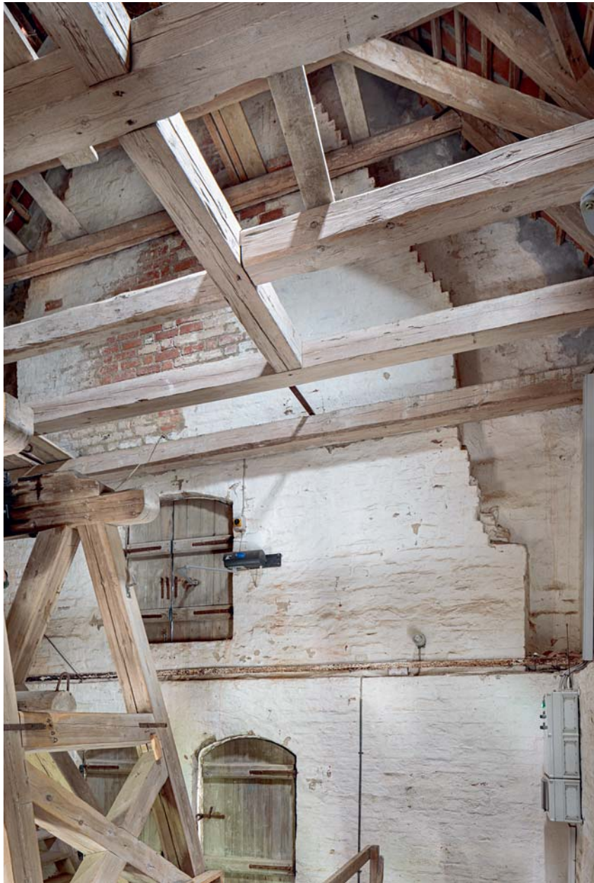
Fig. 26. Tårnets nordre gavltrekanter: Omkring det øverste glamhul ses den fortykkede del af den oprindelige trekant (s. 2228). Der over resten af tårnforhøjelsens gavltrekant (s. 2231). Foto Arnold Mikkelsen 2019. – Northern pediments of the tower. Around the top belfry light one can see the thickened part of the original pediment. Above this, the remains of the pediment of the heightened tower.
