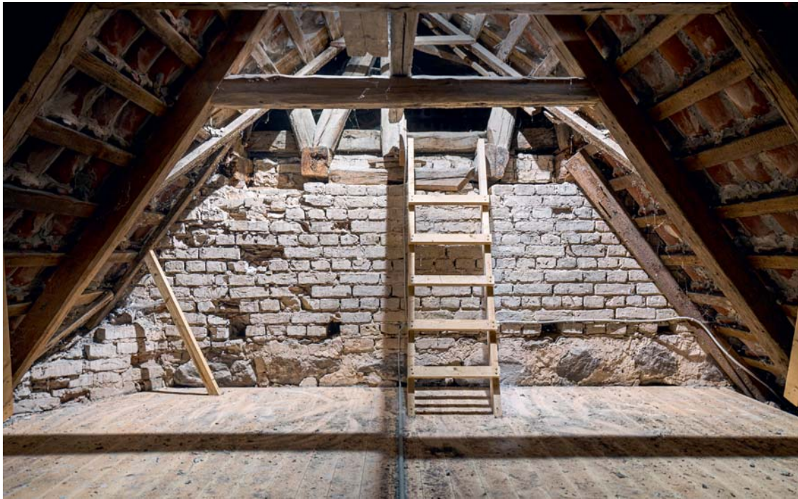
Fig. 109. Langhusets mur set fra våbenhusets loft (s. 2368). Foto Arnold Mikkelsen 2019. – Nave wall seen from porch loft.
