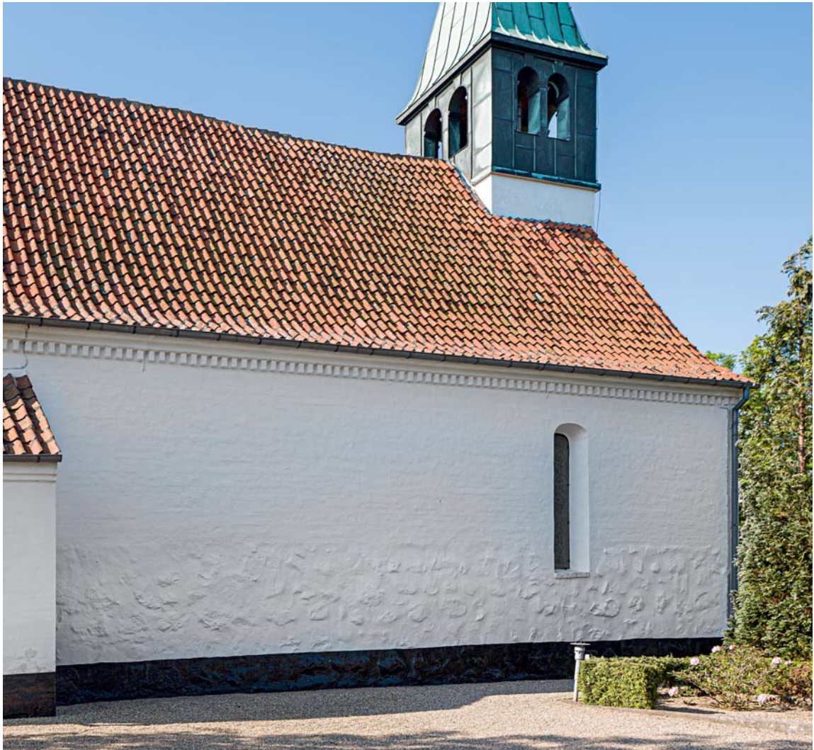
Fig. 107. Skibets nordside (s. 2368). Foto Arnold Mikkelsen 2019. – The north side of the nave.
