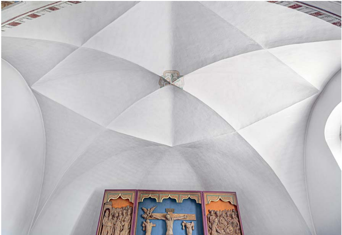
Fig. 16. Korets hvælv set mod øst (s. 2378). Foto Arnold Mikkelsen 2019. – Vault of chancel looking east.
