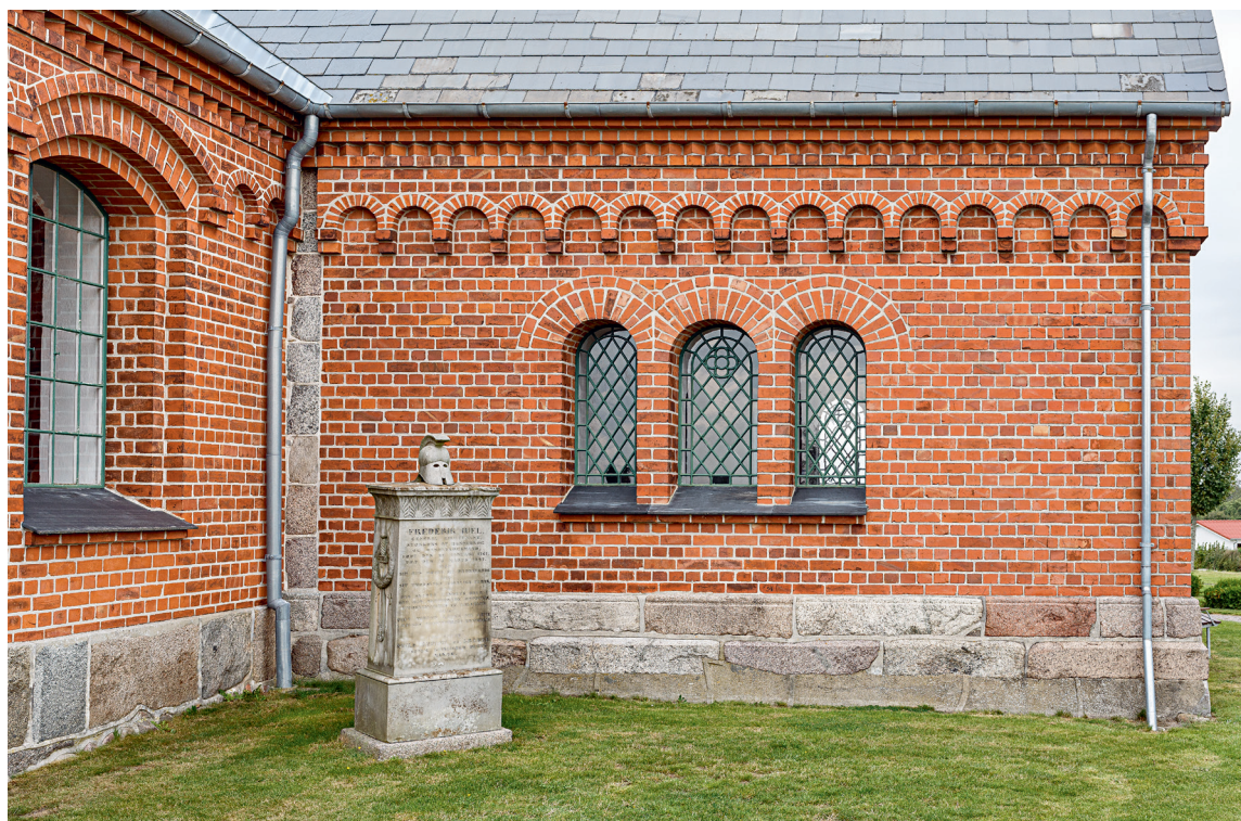
Fig. 25. Koret set fra syd (s. 2474). Bemærk skibets romanske hjørnekæde af kvadre (s. 2461). Foto Arnold Mikelsen 2019. – The chancel seen from the south. Note the Romanesque ashlar corner of the nave wall.
