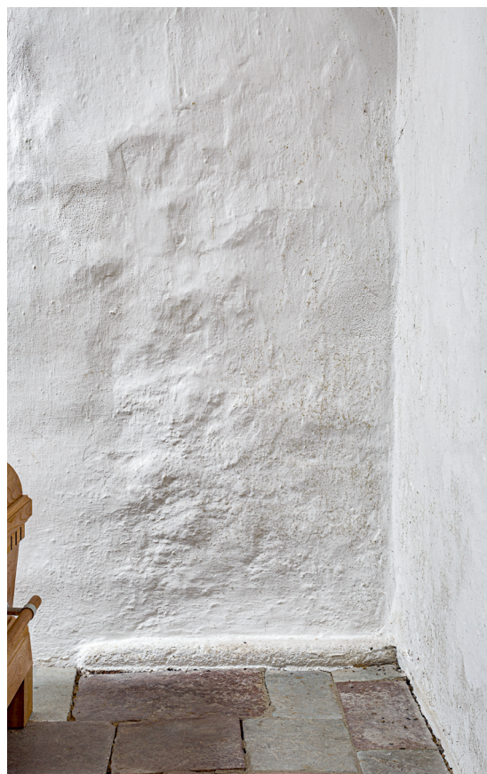
Fig. 11. Skibets oprindelige nordfacade med rundstavs-profileret sokkel (s. 2461). Foto Arnold Mikkelsen 2019. – Original north facade of the nave with astragal-profiled footing.
