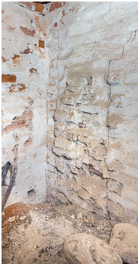
Fig. 12. Rest af nedhugget nordre stræbepille på skibets vestgavl set fra tårnets hvælv (s. 2465). Foto Arnold Mikkelsen 2019. – Remains of demolished northern buttress on west gable of nave seen from tower vault.
