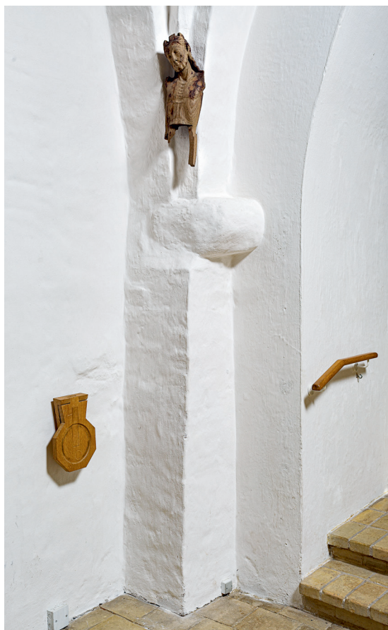
Fig. 105. Hvælvpille med sekundært indhugget kragsten i skibets nordøstlige hjørne (s. 2463). Foto Arnold Mikkelsen 2019. – Vault pillar with carved secondary corbel in the northeastern corner of the nave.
