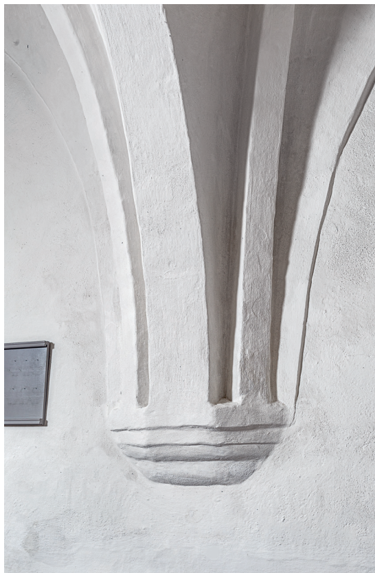
Fig. 106. Hvælvkonsol i sideskibets sydmur (s. 2467). Foto Arnold Mikkelsen 2019. – Vault bracket in south wall of side aisle.
