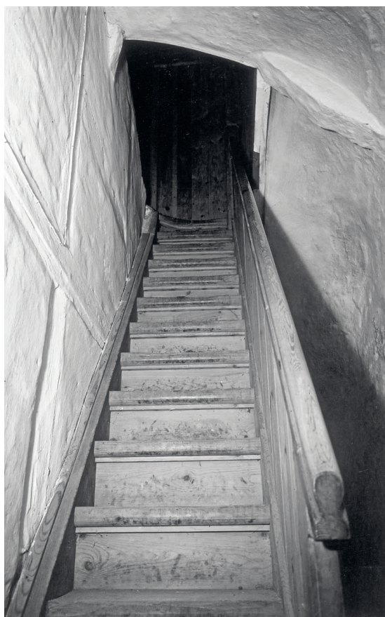
Fig. 29. †Trappe til tårnets mellemstokværk bag †bindingsværkssvæg i tårnrummet (s. 2473) set mod syd. Foto Mogens Larsen 1966. I NM. – †Staircase to middle storey of the tower behind the †half-timbered wall in the tower interior, looking south.
