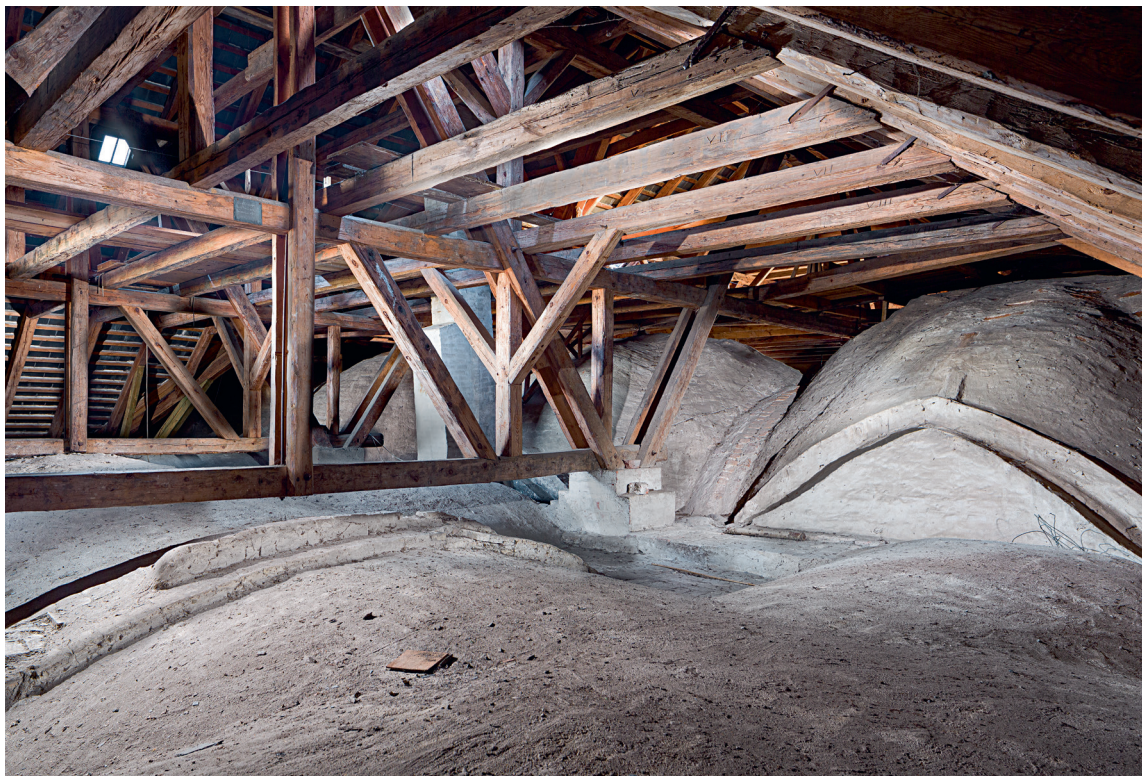
Fig. 28. Kirkens tagkonstruktion med nord-sydgående tagstol (s. 2481) set mod sydøst. I forgrunden ses kapellets flade hvælv (s. 2471) og bagerst skibets hvælv (s. 2463). Foto Arnold Mikkelsen 2019. – Roof construction of the church with north-south-going truss, looking south east. In the foreground, the flat vault of the chapel and farthest back, the vaulting of the nave.
