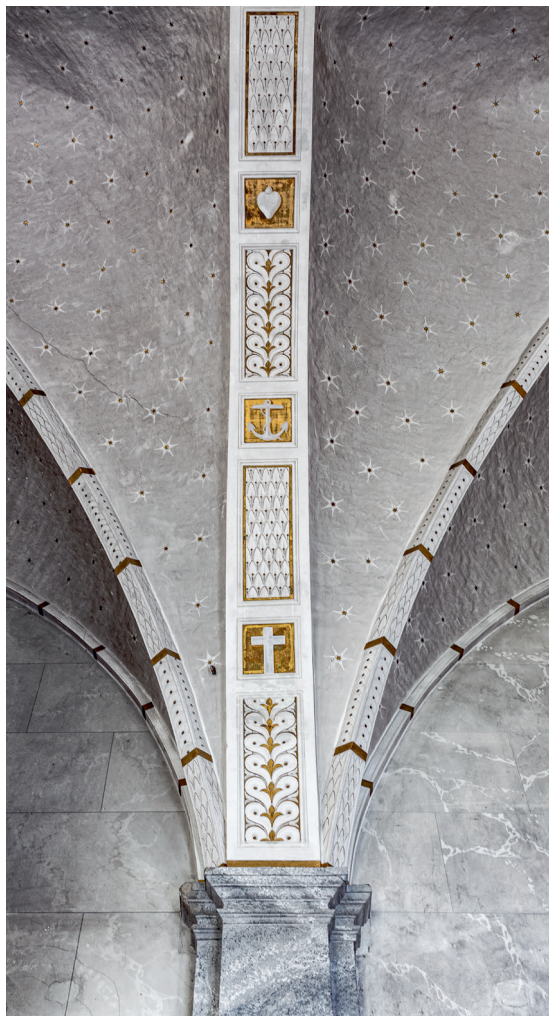
Fig. 14. Gjordbuen mellem kirkens østligste hvælvfag set mod nord (s. 2561 og 2566). Foto Arnold Mikelsen 2019. – Reinforcing rib between the easternmost vault bays looking north.
