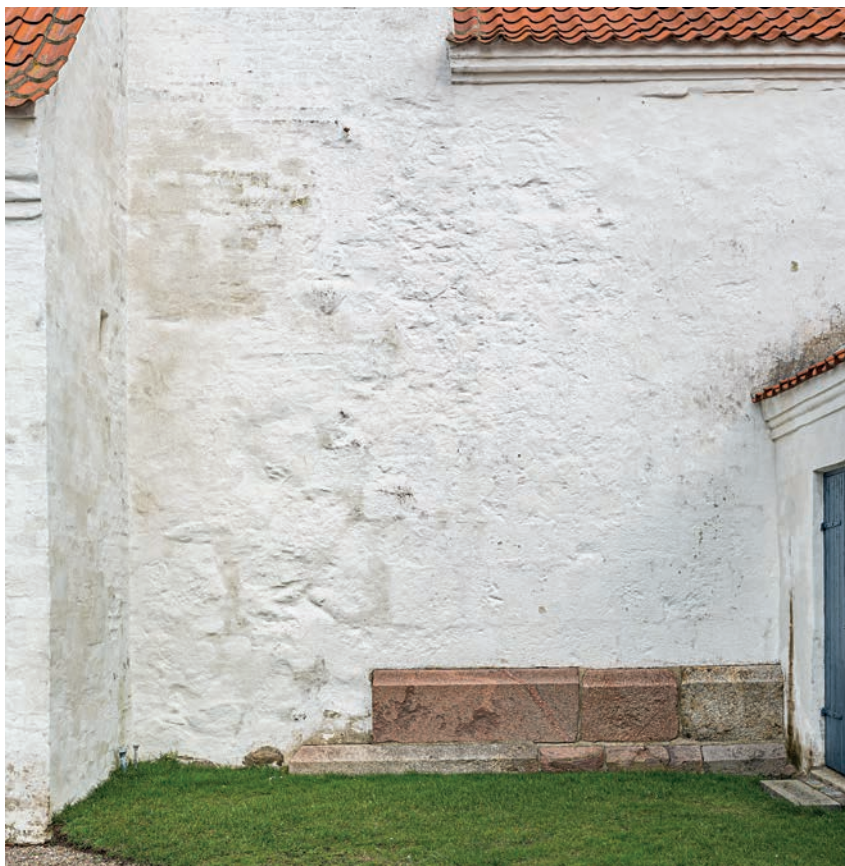
Fig. 104. Overgang i sydfacaden mellem skibet og vestforlængelsen (s. 2631). Foto Arnold Mikkelsen 2020. – Transition in south facade between nave and western extension.
