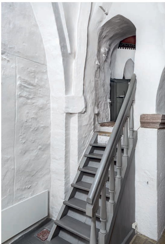
Fig. 74. Opgang til prædikestol og tilmuret romansk præstedør (s. 2664 og 2617). Foto Arnold Mikkelsen 2020. – Ascent to pulpit and bricked-up, Romanesque priest's door.
