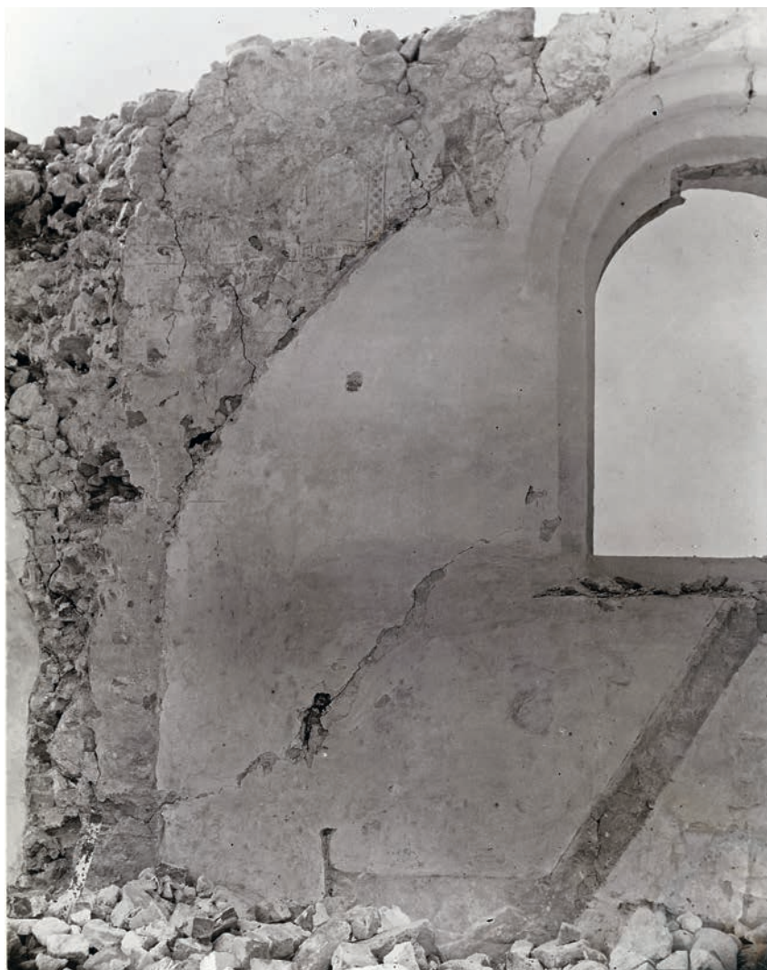
Fig. 127. †Skibets sydvæg med spor af †kalkmalerier fra 1475-1500 efter nedbrydningen af den sydøstre hvælpille (s. 2781). Foto C. M. Smidt 1905. I NM. – South wall of the †nave with traces of †wall paintings, 1475-1500, after demolition of the south-eastern vault pier.
