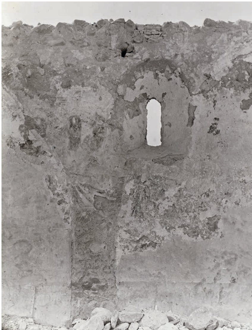
Fig. 130. †Skibets sydvæg med spor af †kalkmalerier fra 1475-1500 efter nedbrydningen af hvælpillen mellem langhusets tredje og fjerde fag (s. 2782). Foto C. M. Smidt 1905. I NM. — South wall of the †nave with traces of †wall paintings, 1475-1500, after demolition of the vault pier between the third and fourth bay of the nave church.
