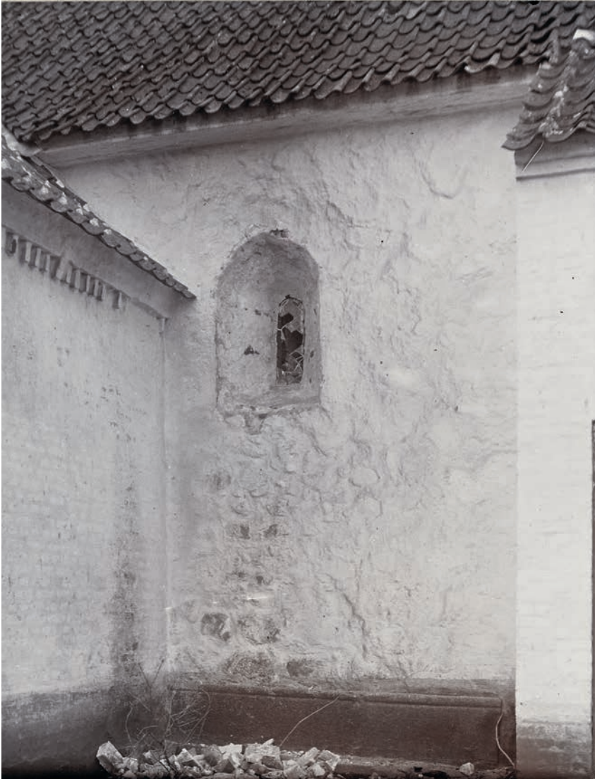
Fig. 82. Romansk vindue i \dagger skibets nordmur (s. 2764). Bemærk \star vinduesrammen med blyndfatning og glas i lysningen (s. 2776). Foto C. M. Smidt 1905. I NM. – Romanesque window in the north wall of the \dagger nave. Note the \star window frame with leading in the opening.
