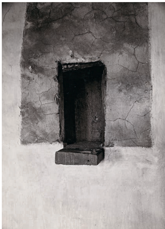
Fig. 87. Niche i nordvæggen i langhuskorets første fag (s. 2770). Foto C. M. Smidt 1905. I NM. – Niche in the north wall of the first bay of the nave-chancel.
