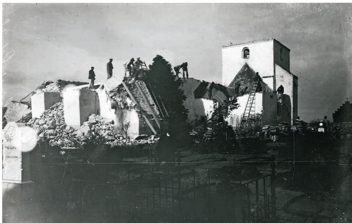
Fig. 90. †Kirken under nedbrydningen set fra nordøst. Foto formentlig Søren Lolk 1905. I NM. – The †church during demolition, seen from the north east, 1905.
