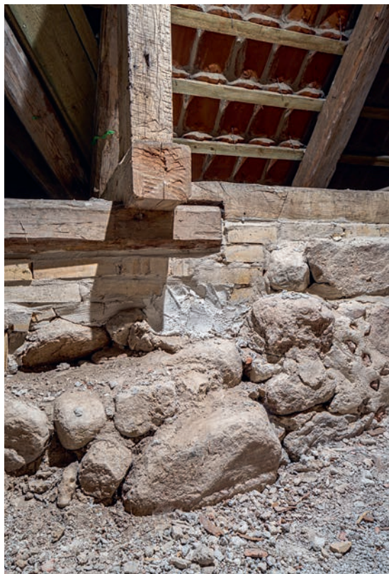
Fig. 67. Rest af skibets nordøsthjørne set mod nordøst (s. 3027). Foto Arnold Mikkelsen 2019. – Remains of north west corner of nave looking north east.
