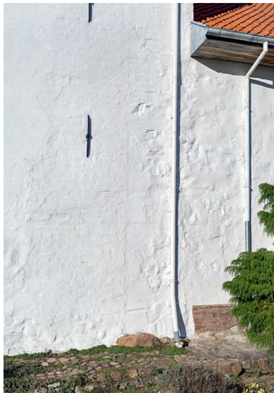
Fig. 66. Skibets sydvestlige hjørnekæde ved sammenstødet med tårnet (s. 3031). Foto Arnold Mikkelsen 2019. – Southwestern corner chain at meeting with the tower.
