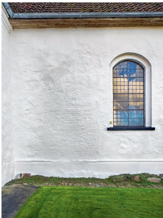
Fig. 11. Udsnit af skibets nordmur med spor af \dagger dør (s. 3028). Foto Arnold Mikkelsen 2019. – Detail of north wall of nave with traces of \dagger door.
