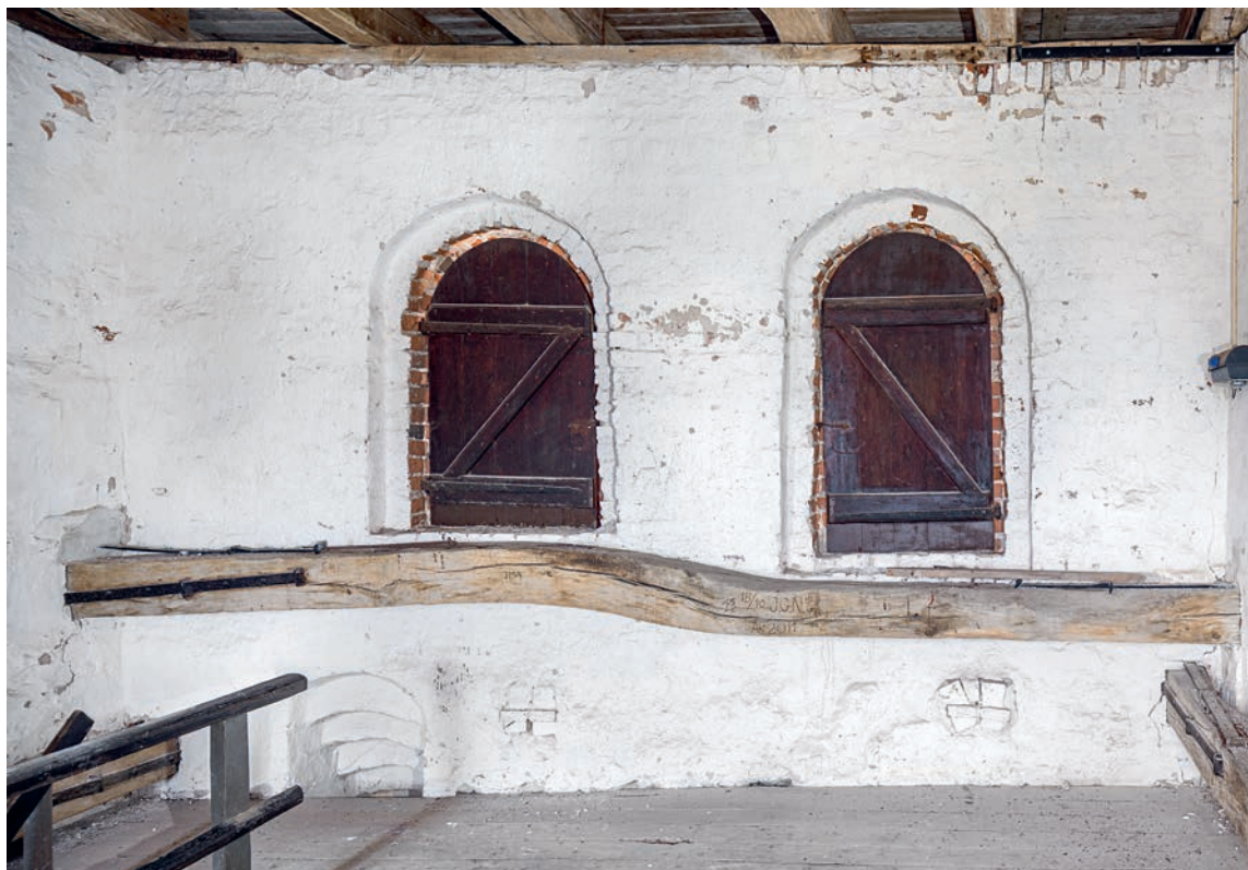
Fig. 21. Tårnets øvre mellemstokværk med ældre glamhuller i tårnets sydmur samt †syddørens stik (s. 3034). Foto Arnold Mikkelsen 2019. – Upper intermediate storey of tower with older belfry lights in the south wall of the tower and the arches of the †south door.
