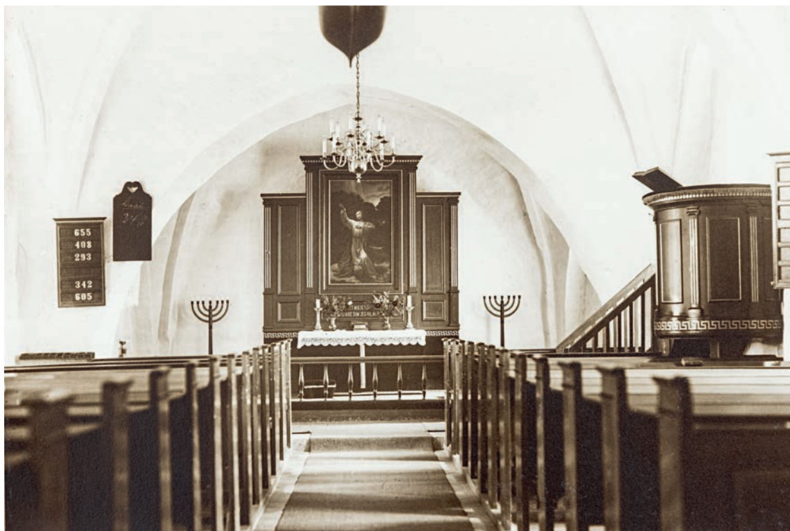
Fig. 32. Indre set mod øst, o. 1940. Foto i Egebjerg Lokalhitoriske Arkiv. – Interior looking east.
