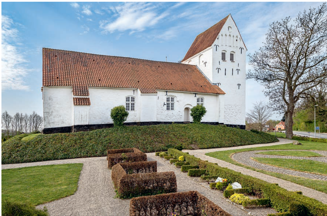
Fig. 24. Ydre set fra nord. Foto Arnold Mikkelsen 2019. – Exterior seen from the north.
