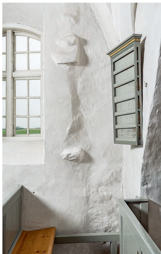
Fig. 31. Rest af romansk †triumfмур i langhusets nordvæg (s. 3151). Foto Arnold Mikkelsen 2019. – Remains of Romanesque †chancel arch wall in north wall of nave.
