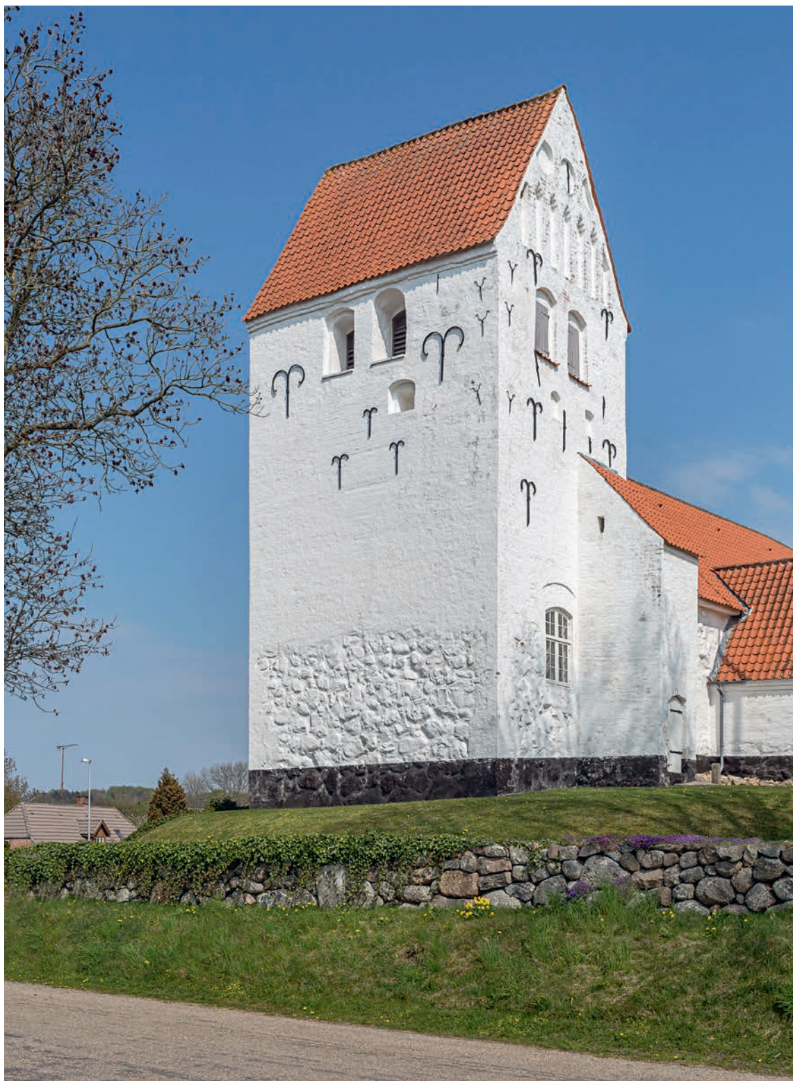
Fig. 21. Tårnet set fra sydvest (s. 3158). Foto Arnold Mikkelsen 2019. – Tower seen from the south west.
