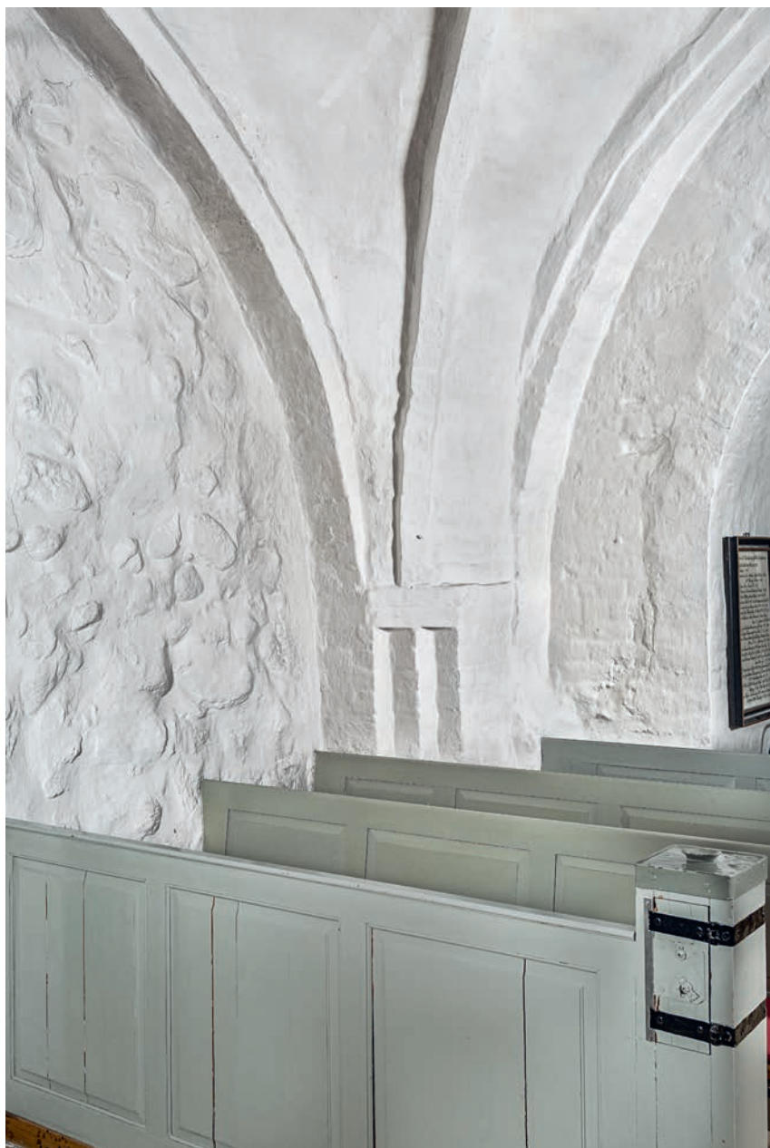
Fig. 20. Hvælpille i langhusets sydvesthjørne (s. 3158). Foto Arnold Mikkelsen 2019. – Vault pier in southwestern corner of nave.
