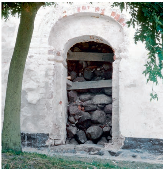
Fig. 16. Senromansk norddør under afdækning (s. 3153). Foto Odense Bys Museer 1989. – Late Romanesque north door being uncovered.
