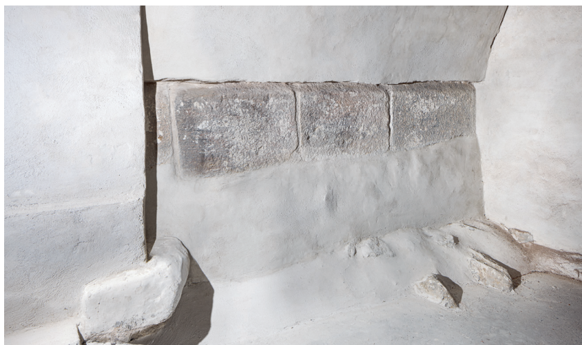
Fig. 171. De søndre korsarmskapellers skråkantede granitsokkel set mod nordøst (s. 3345). Foto Arnold Mikkelsen 2021. – The bevelled granite footing of the southern transept chapels, looking north east.
