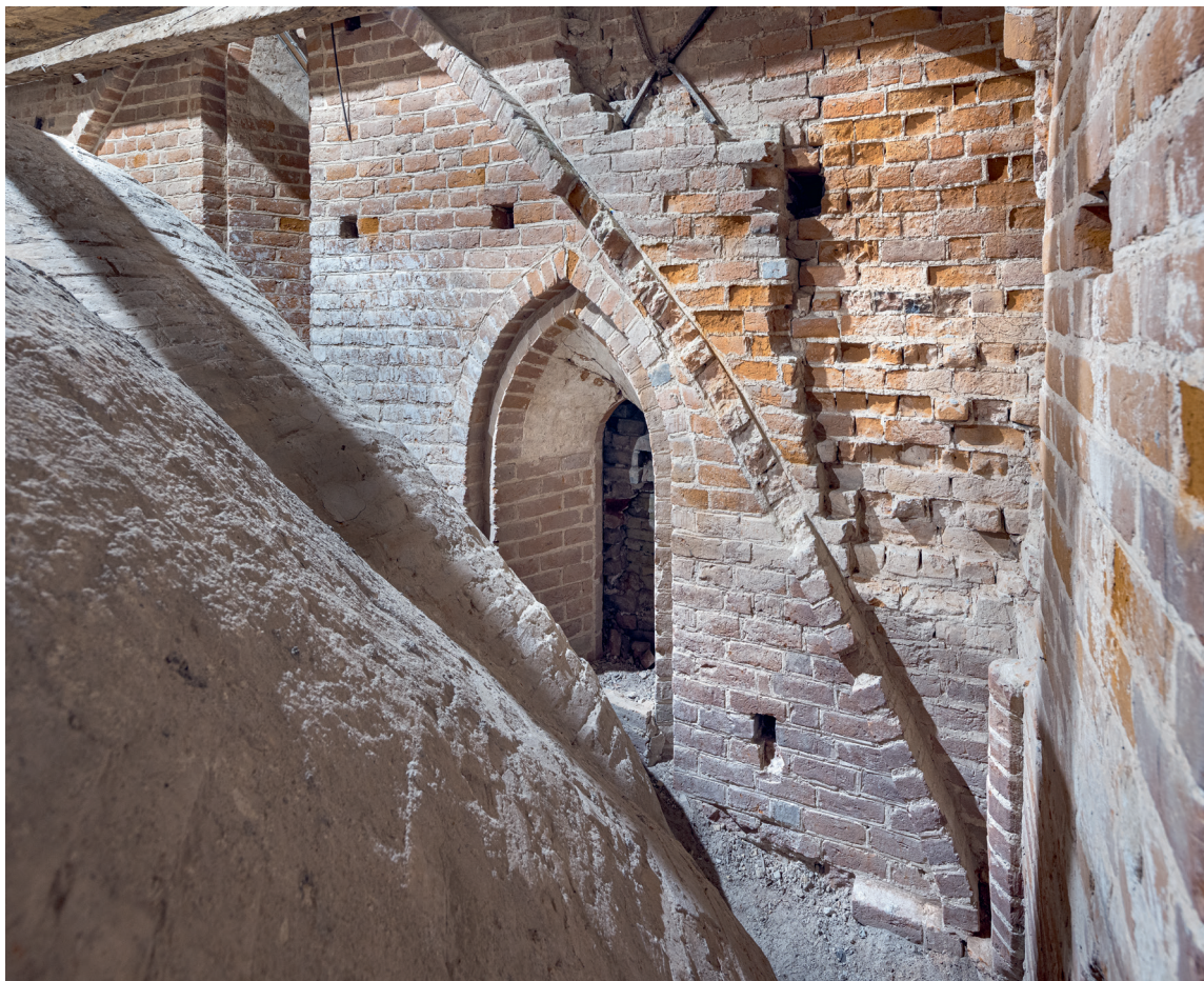
Fig. 55. Det midterste og det nordre vindue samt skjoldbue i kirkens vestgavl set mod vest (s. 3361). Foto Arnold Mikkelsen 2021. – The middle and northern window and the wall rib in the west gable of the church, looking west.
