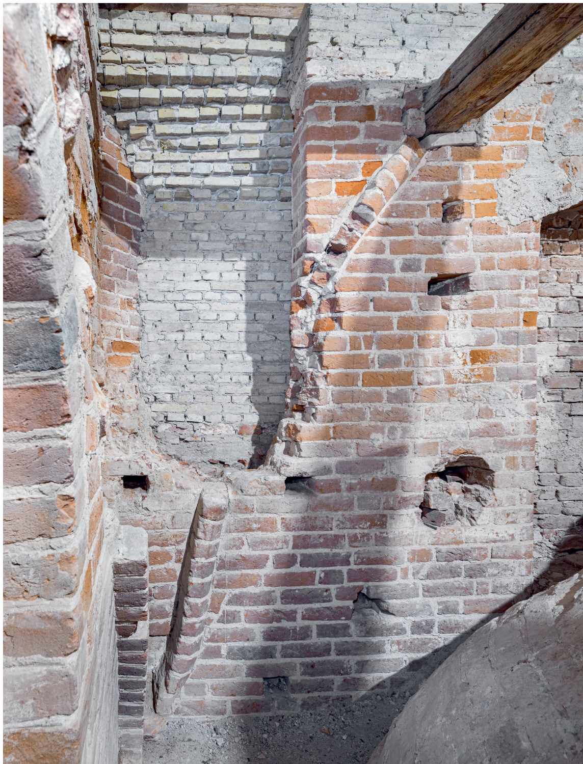
Fig. 65. Overdør til \uparrow trappehus set mod nord (s. 3369). Bemærk dørens oprindelige vanger øverst i åbningen samt opretningen af skjoldbuen under døren (s. 3367). Foto Arnold Mikkelsen 2021. – Lintel to \uparrow stairwell, looking north. Note the door's original side members at the top of the opening and the placing of the wall rib beneath the door.
