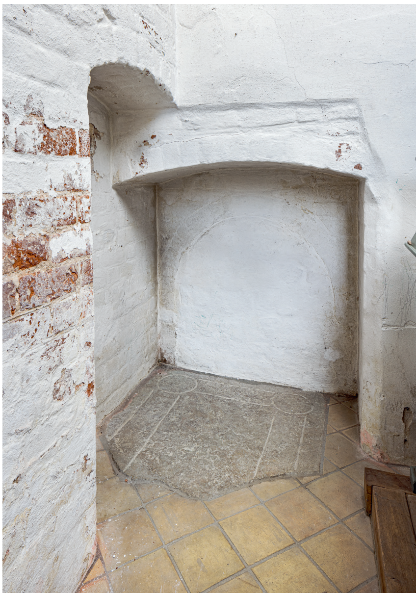
Fig. 43. Dør med opslagsniche til †trappehuset i kirkens nordvesthjørne (s. 3352). I gulvet ligger gravsten nr. 4 (s. 3442). Foto Arnold Mikkelsen 2021. – Door to the †stairwell in the north west corner of the church. In the floor lies tombstone no. 4.
