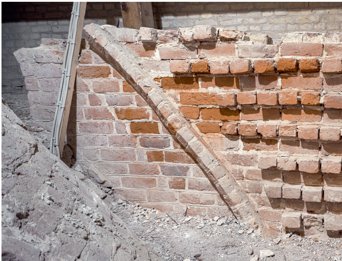
Fig. 38. Korets østgavl over hvælvene set mod øst. Fra venstre ses en rest af stik til et senromansk vindue (s. 3342), hvælvvederlag til senromansk hvælv (s. 3345) samt skjoldbue og hvælvfortanding til tidliggotisk hvælv (s. 3367). Foto Arnold Mikkelsen 2021. – East gable of the chancel above the vaults looking east. From the left, traces of an arch for a Late Romanesque window, ledging for a Late Romanesque vault and a wall rib and tothing for an Early Gothic vault.
