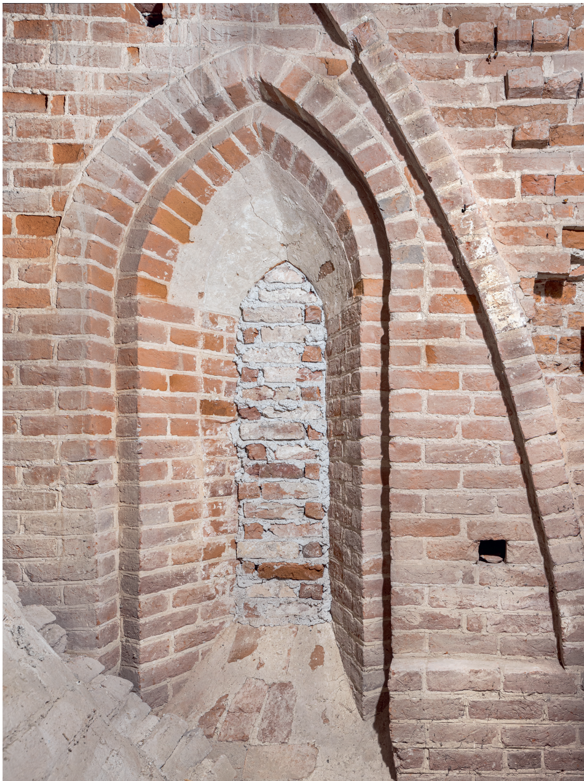
Fig. 52. Tidliggotisk vindue i søndre højkirkemurs 4. fag (s. 3357). Foto Arnold Mikkelsen 2021. – Early Gothic window in the fourth bay of the southern high church wall.
