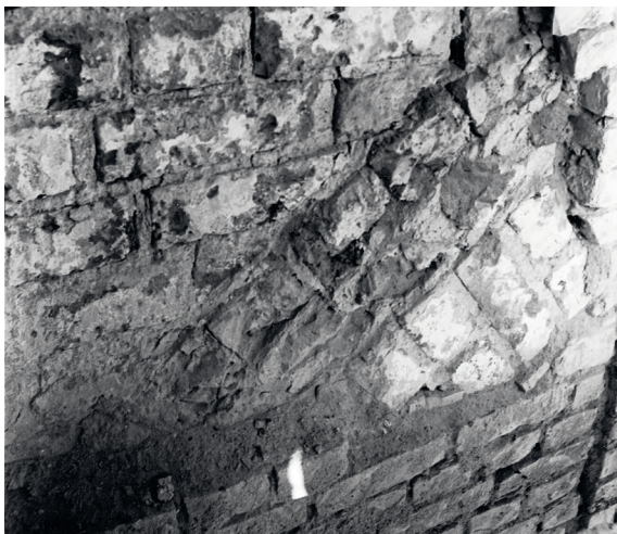
Fig. 183–84. 183. Afhugget bueslag til hvælv i tønders sideskib over arkadestik i sydurens tredje arkade fra øst (s. 3352). 184. Det østlige vindue i søndre højkirke-murs fjerde fag under pudsafbankningen 1997 (s. 3390). Bemærk det kraftigt afhuggede murværk (jf. s. 3385). Foto Jens Chr. Varming 1997. I Varmings Tegnesteue. – 183. Demolished vault arch over the third arch bay from the east in the south wall . 184. The eastern window of the fourth bay of the south high wall during the renovation 1997. Note the heavily demolished brickwork.
