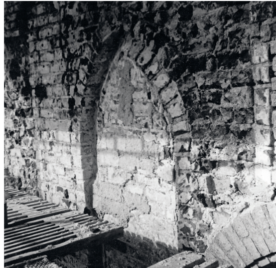
Fig. 87. Det midterste vindue i søndre højkirke-murs 5. fag under pudsafbankningen 1997 (s. 3390). Foto Jens Chr. Varming 1997. I Varmings Tegnesteue. – The middle window of the fifth bay of the south high wall during the renovation 1997.
