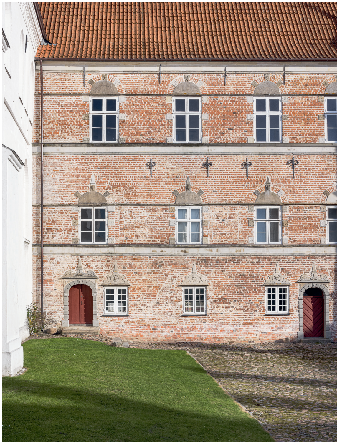
Fig. 45. Østfløjens vestfacade set fra vest (s. 3323). Bemærk lodfugen syd for mellemstokværkets nordligste vindue (jf. fig. 44 og s. 3352). Foto Arnold Mikkelsen 2021. – West facade of the east wing seen from the west. Note the joint south of the northernmost window of the intermediate floor.
