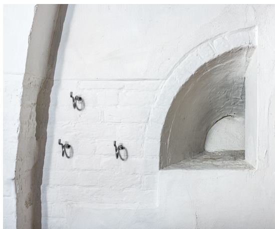
Fig. 167. Rundbuet, senromansk vinduesstik til østgavlens nordre vindue i nederste vinduesstokværk (s. 3342). Foto Arnold Mikkelsen 2021. – Round, Late Romanesque window arch for the northern window of the east gable in the lowest window floor.
