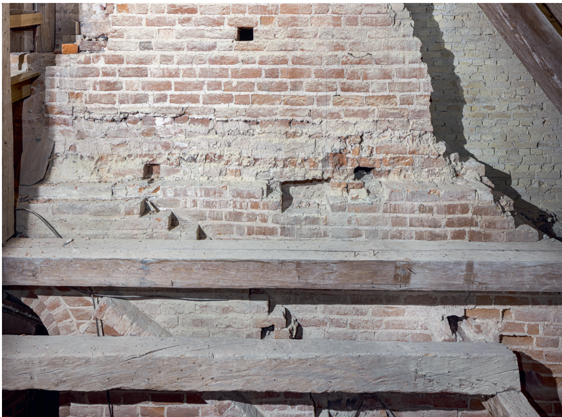
Fig. 67. Kirkens vestgavl set mod vest (s. 3369). Bemærk aftryk af den vestligste bindbjælke i det oprindelige tagværk (s. 3392) samt bjælkehul fra støtte til en \dagger tagrytter (s. 3379). Foto Arnold Mikkelsen 2022. – Western gable of the church, looking west. Note imprint of the westernmost tie-beam in the original roof construction and beam hole from a \dagger ridge turret.
