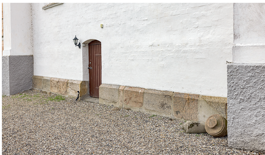
Fig. 168. Senromansk, skråkantet granitsokkel på korets østgavl (s. 3342). Foto Arnold Mikkelsen 2021. – Late Romanesque, bevelled granite footing on the east gable of the chancel.
