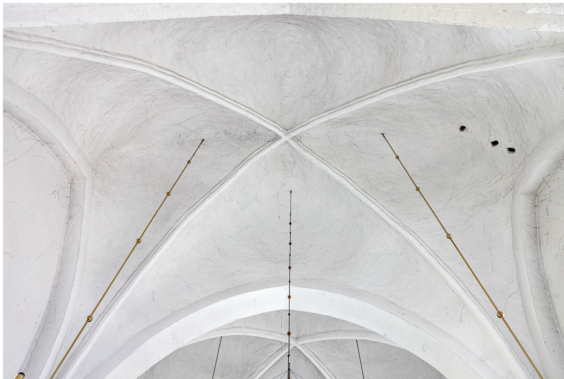
Fig. 76. Kirkens vestligste hvælv med klokkerebshuller set mod øst (s. 3377). Foto Arnold Mikkelsen 2021. – The westernmost vault in the church, with bell rope holes, looking east.
