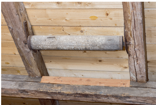
Fig. 182. Hejseværk i nordsiden af tagværkets østende (s. 3392). Foto Arnold Mikkelsen 2021. – Hoist on the north side of the east end of the roofing.
