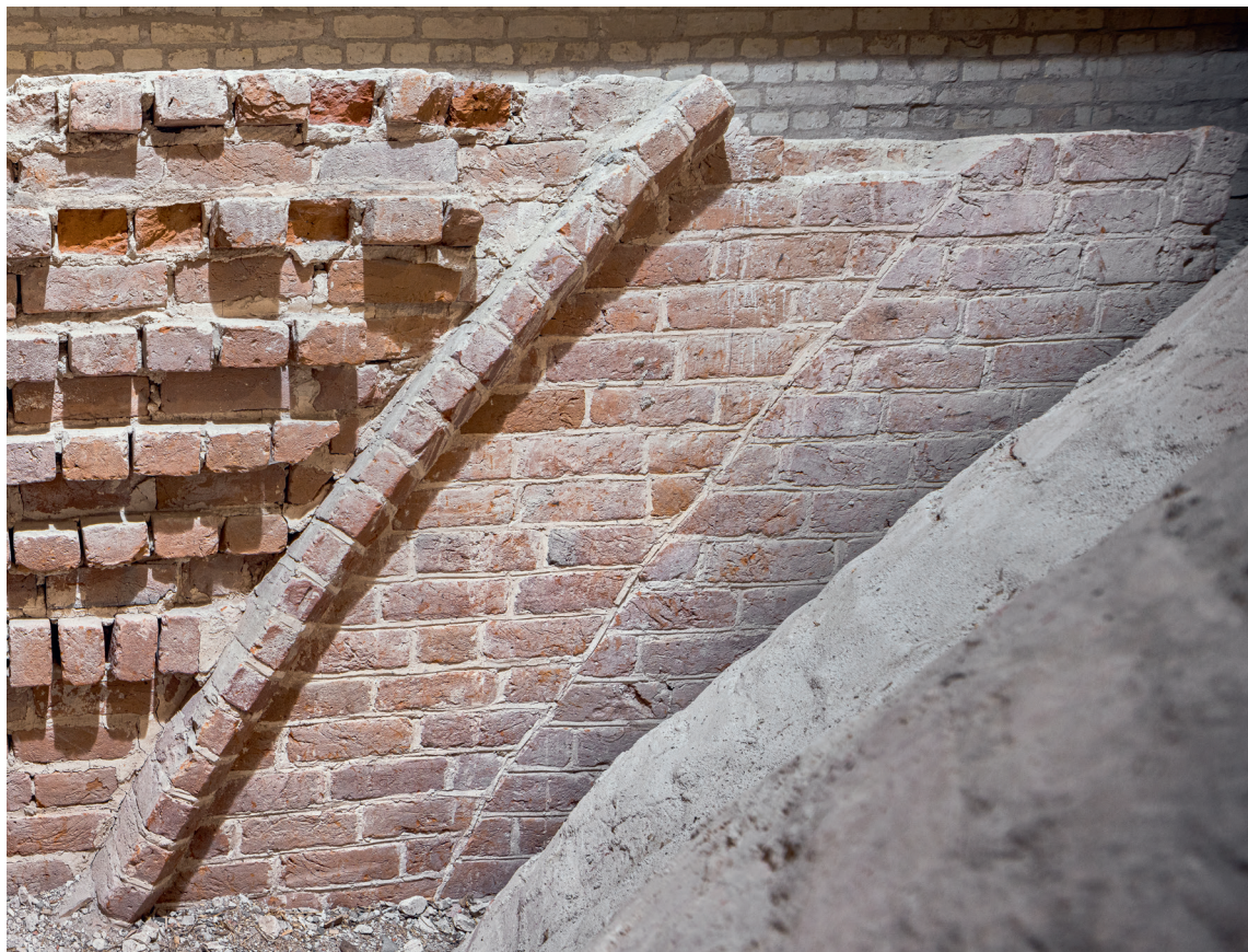
Fig. 37. Korets østgavl over hvælvene set mod øst. Fra højre ses en rest af stik til et senromansk vindue (s. 3342), hvælvvederlag til senromansk hvælv (s. 3345) samt skjoldbue og hvælvfortanding til tidliggotisk hvælv (s. 3367). Foto Arnold Mikkelsen 2021. – East gable of the chancel above the vaults looking east. From the right, traces of an arches for a Late Romanesque window, ledging for a Late Romanesque vault and a wall rib and tothing for an Early Gothic vault.
