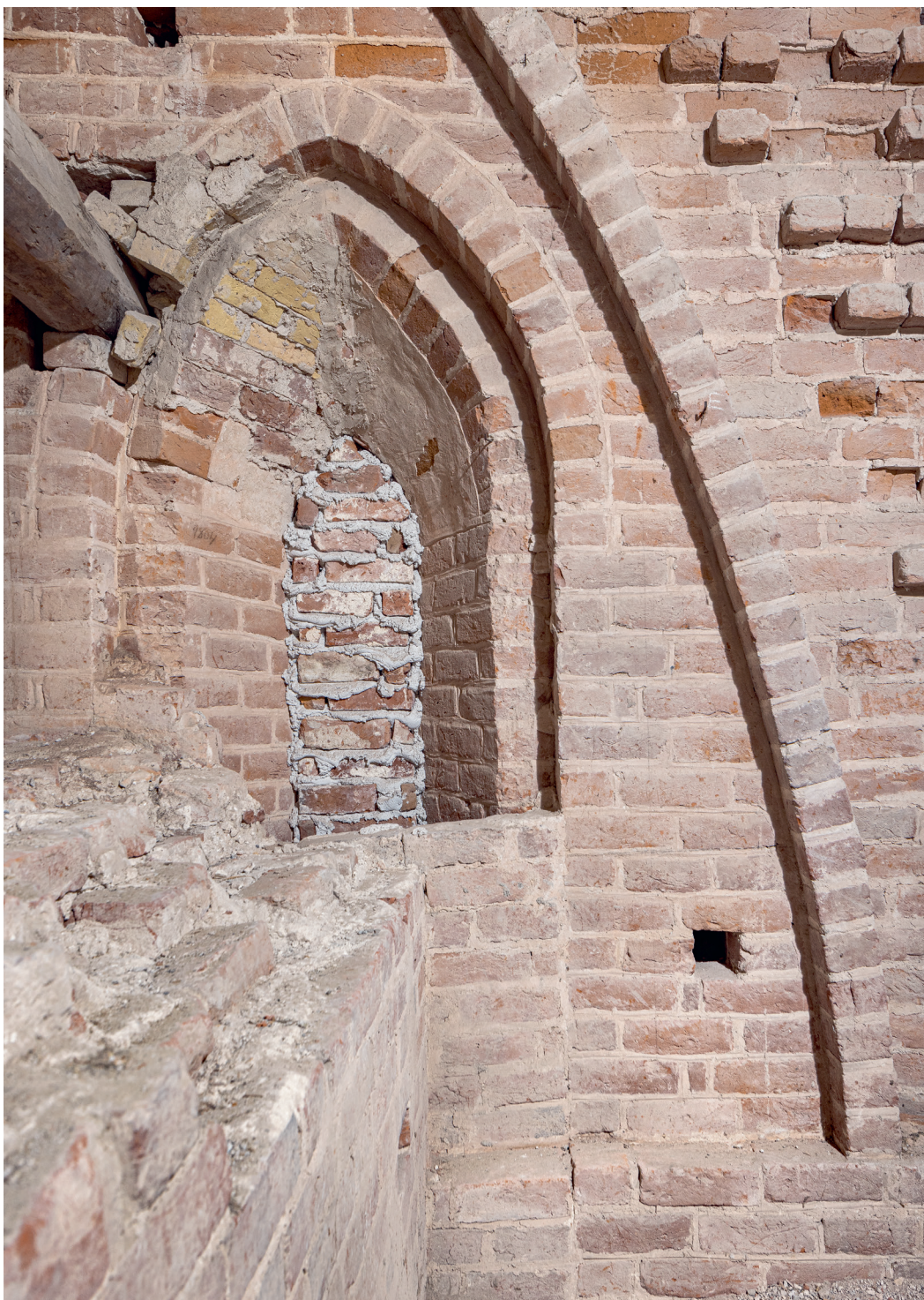
Fig. 51. Tidliggotisk vindue i søndre højkirke-murs 3. fag (s. 3357). Bemærk de afhuggede indre false og den delvise tilmuring, som er samtidig med opførelsen af triumfinuren (s. 3374). Foto Arnold Mikkelsen 2021. – Early Gothic window in the third bay of the southern high church wall. Note the chopped-off interior bevelling and the partial bricking-up, which is contemporary with the building of the chancel arch wall.
