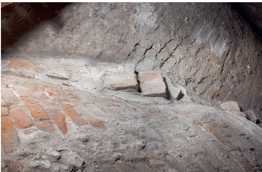
Fig. 73. Rester af trappetrin på andet hvælvfags nordøstre ribbe (s. 3377). Foto Arnold Mikkelsen 2021 – Remains of steps on the northeastern rib of the second vault bay.
