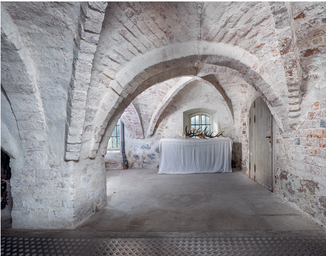
Fig. 15. Hvælvet kælder under klostrets sydføj set mod syd (s. 3324). Foto Arnold Mikkelsen 2021. — Vaulted cellar under the south wing of the abbey, looking south.
