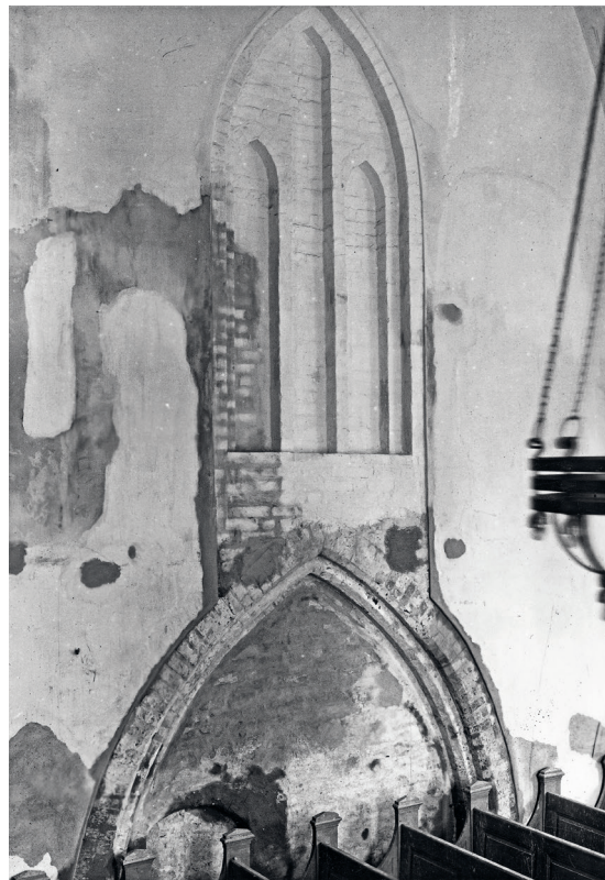
Fig. 169. Arkade og triforieblænding i skibets sydmur efter murundersøgelser 1934–35 (s. 3328). Bemærk reparationerne af cementpuds, hvor der også har været lavet undersøgelser. Foto Vilh. Lorenzen 1935. I NM. – Arcade and triforium recess in the south wall of the nave after investigations of the wall in 1934–35. Note the repairs to the cement plastering, where there have also been investigations.
