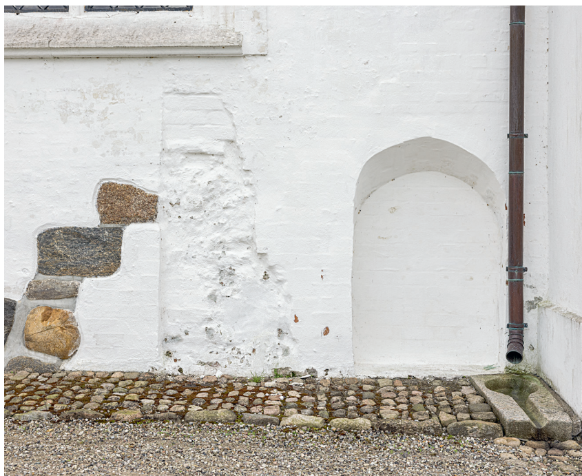
Fig. 42. Spor efter † trappehus i den vestlige ende af kirkens nordfacade (s. 3352). Foto Arnold Mikkelsen 2021. – Traces of a †stairwell at the western end of the north facade of the church.
