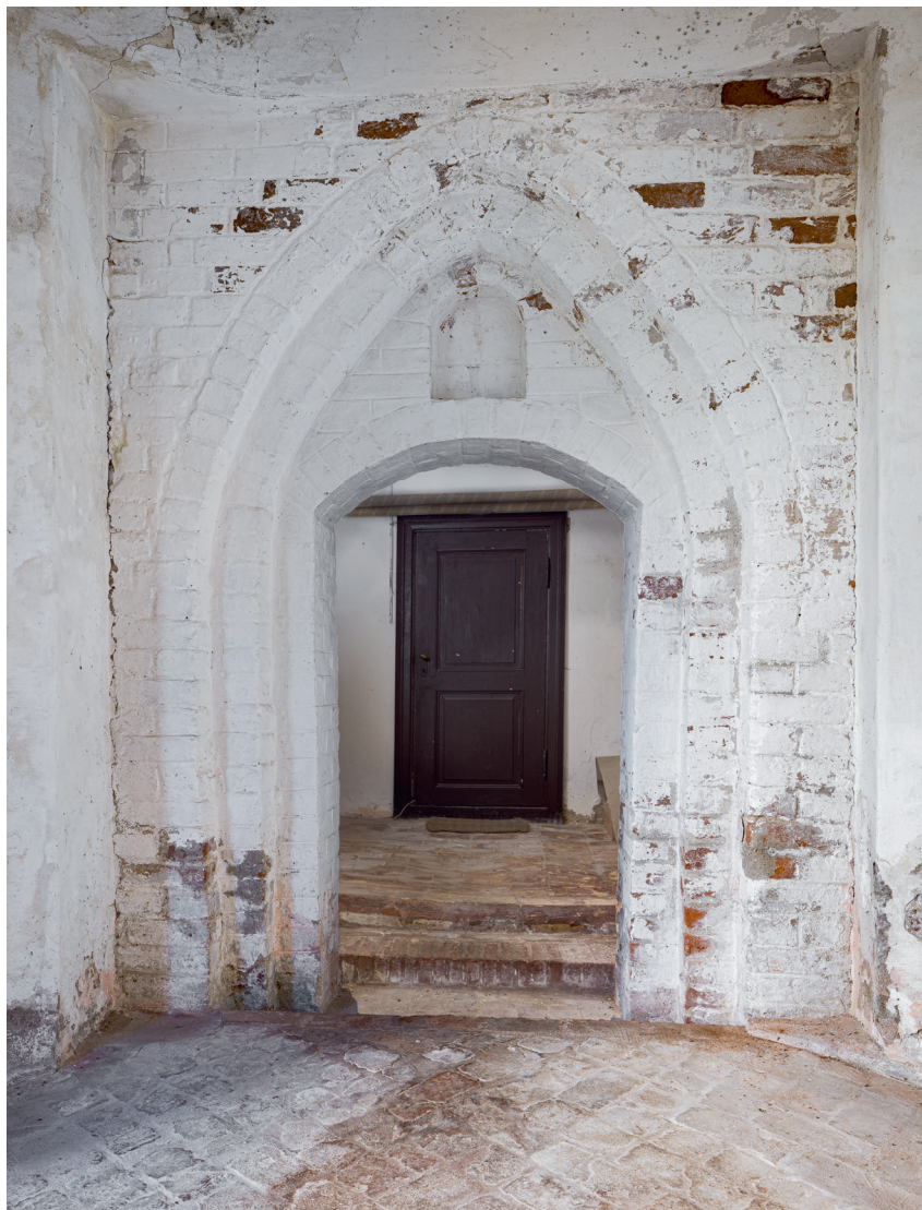
Fig. 14. Senmiddelalderlig dør til klostrets østfløj set mod øst (s. 3324). Foto Arnold Mikkelsen 2021. – Late Medieval door in the east wing of the abbey, looking east.
