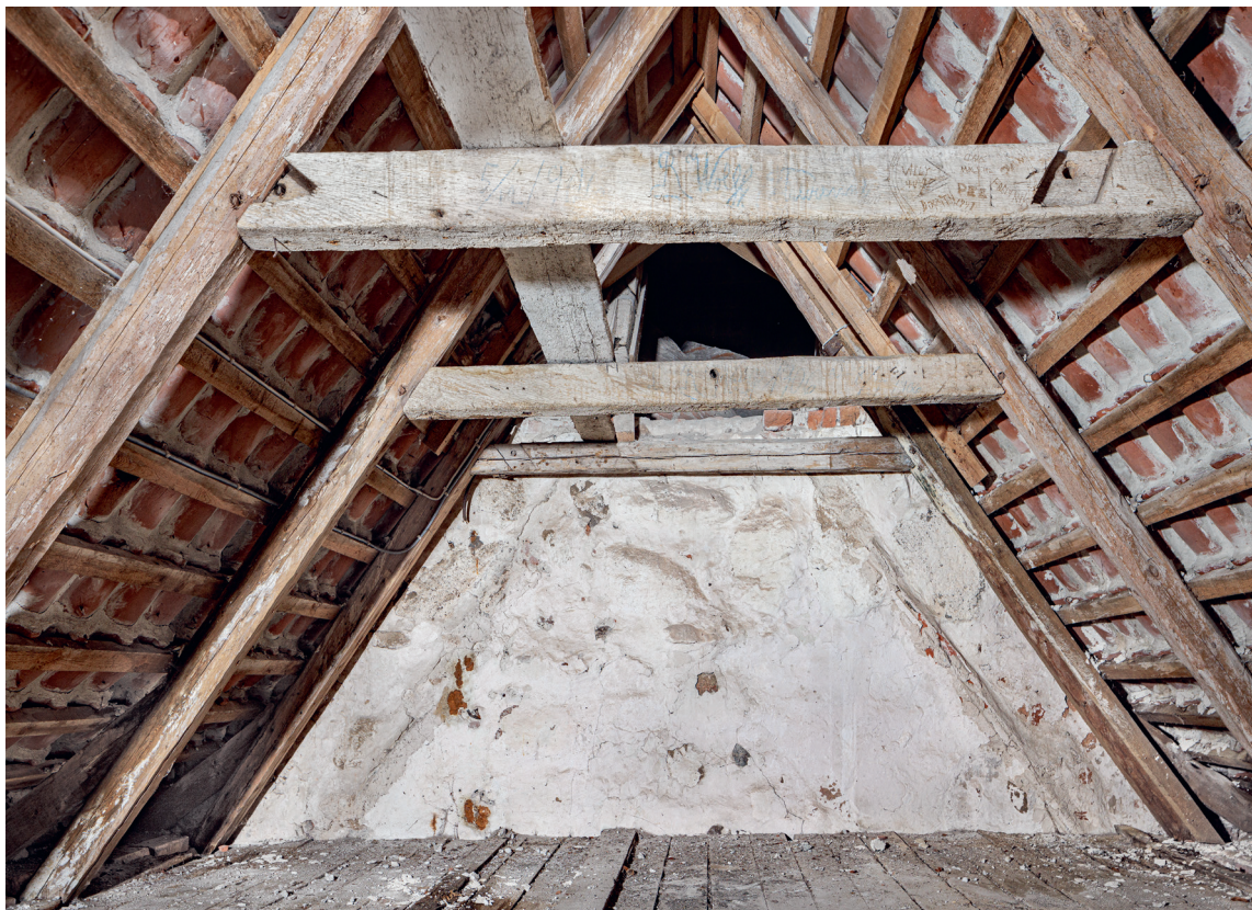
Fig. 28. Aftryk af (†)våbenhusets tag på skibets murforhøjelse set mod nord (s. 3700). Foto Arnold Mikkelsen 2022. – Imprint of roofing of the (†)porch on the wall heightening in the nave looking north.
