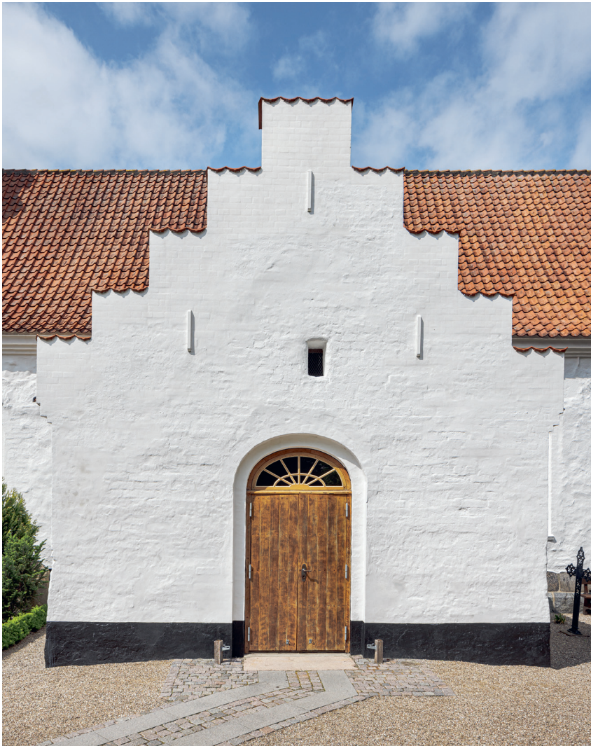
Fig. 26. Våbenhuset set fra syd (s. 3700-01). Foto Arnold Mikkelsen 2022. – Porch seen from the south.
