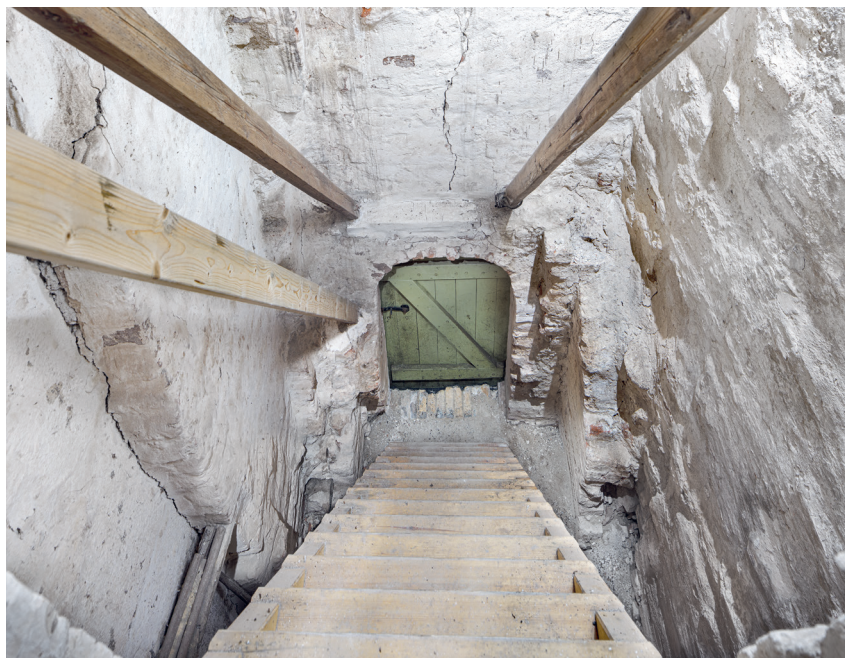
Fig. 23. Trappehusets indre set mod syd (s. 3701). Foto Arnold Mikkelsen 2022. – Interior of stairwell looking south.
