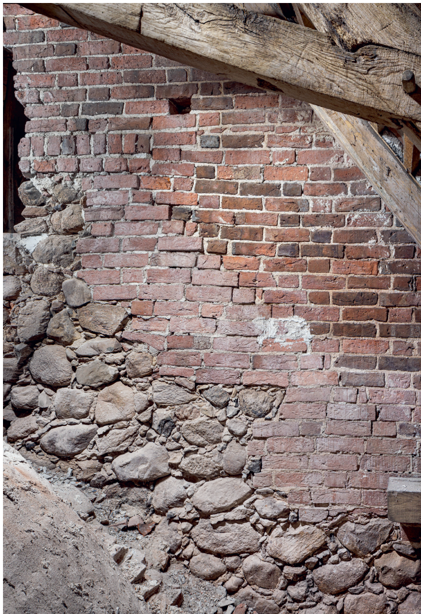
Fig. 15. Vestforlængelsens gavltrekant og tårnets østmur set fra øst (s. 3693). Foto Arnold Mikkelsen 2022. – Pediment of western extension and east wall of tower seen from the east.
