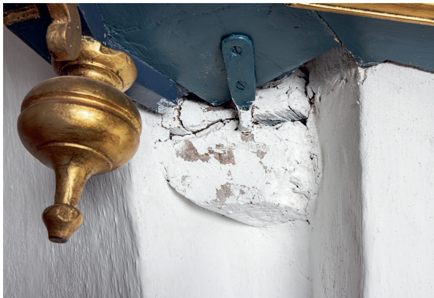
Fig. 73. Bjælkeende i muren under prædikestolens himmel, muligvis en rest af en tlektorieprædikestol, omtalt 1589 (s. 3724). Foto Arnold Mikkelsen 2022. – Beam end in the wall beneath the canopy of the pulpit, possibly remains of a tlectorium pulpit mentioned in 1589.
