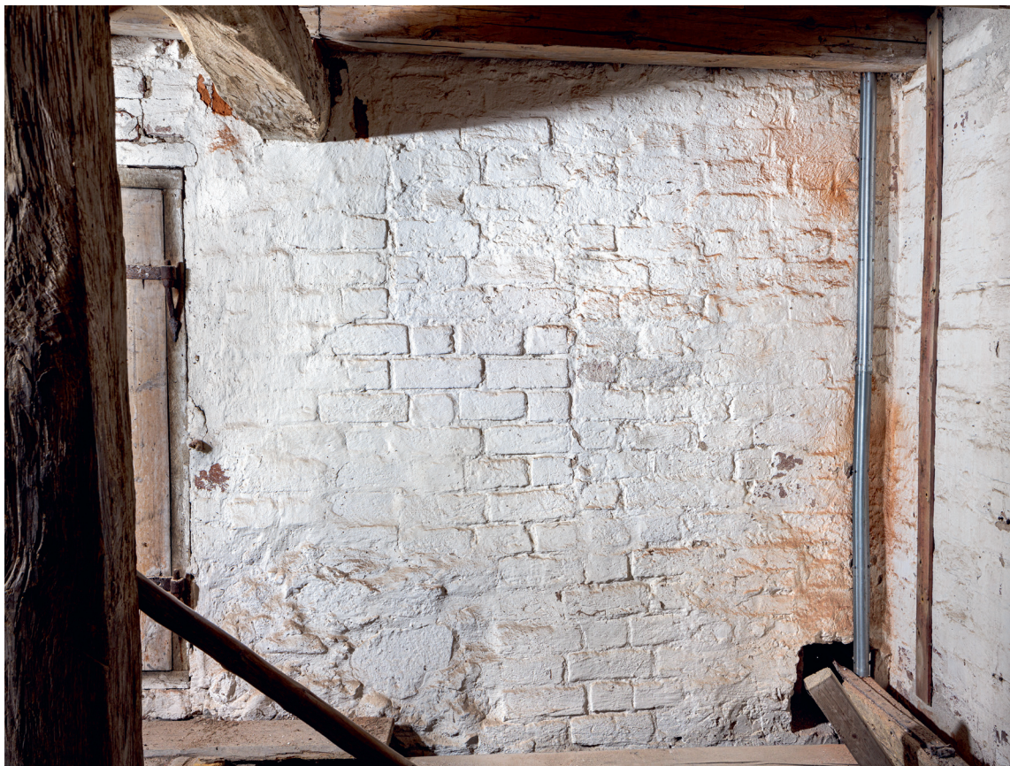
Fig. 16. Vestforlængelsens kamtakker indlejret i tårnets østmur set mod øst (s. 3693). Foto Arnold Mikkelsen 2022. – Crenellations of western extension embedded in the east wall of the tower looking east.
