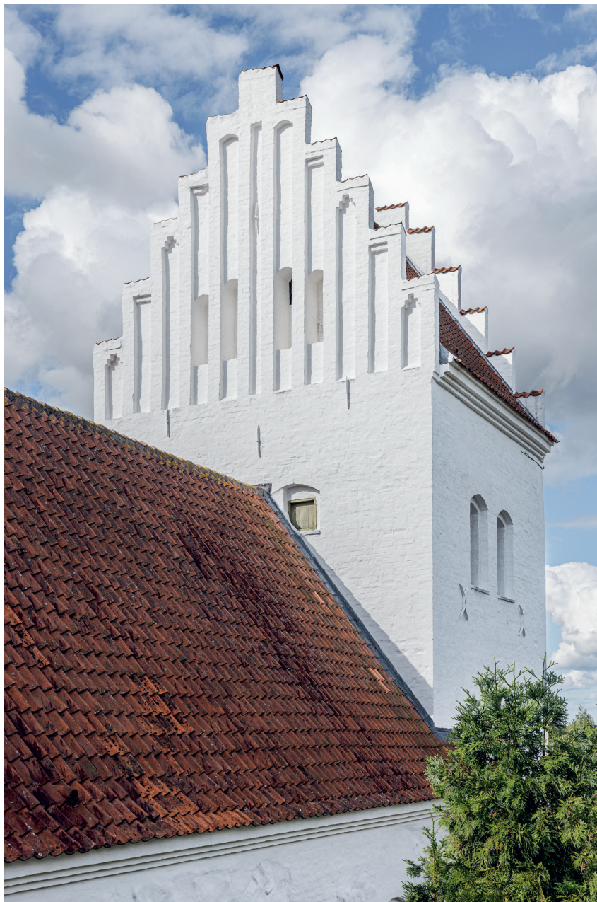
Fig. 19. Tårnets østlige gavltrekant set fra nordøst (s. 3693). Foto Arnold Mikkelsen 2022. – The eastern pediment of the tower seen from the north east.
