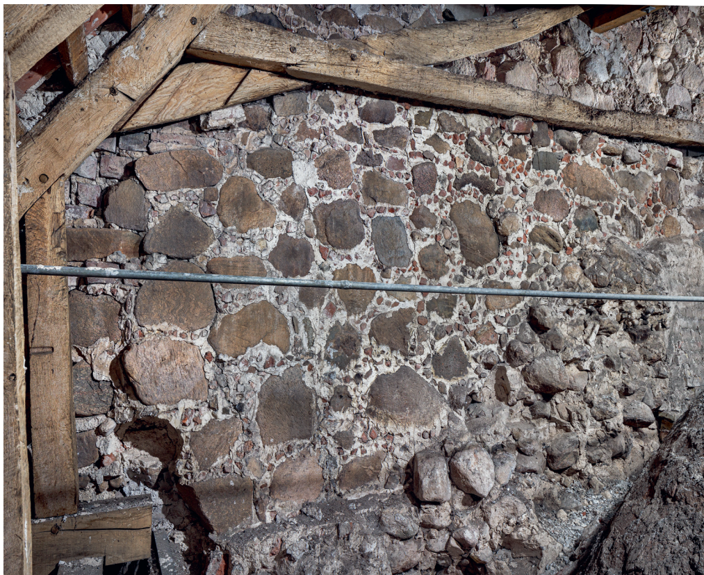
Fig. 32. Østforlængelsens gavltrekan set mod øst (s. 3698). Foto Arnold Mikkelsen 2022. – Pediment of the eastern extension looking east.
