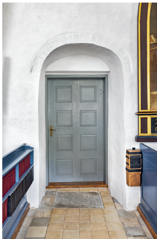
Fig. 53. Dørfloj, 1855/56, (s. 3727) i den romanske syddør (s. 3689). Foto Arnold Mikkelsen 2022. – Door wing, 1855/56, in the Romanesque south door.
