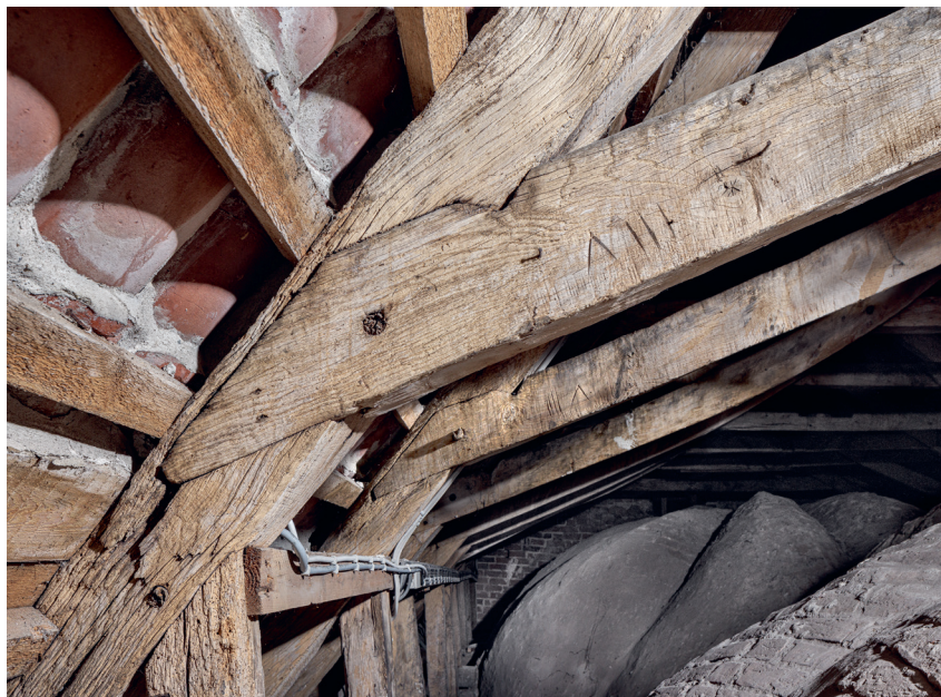
Fig. 71. Tømmersamlinger og -mærker i sydsiden af skibets tagværk (s. 3704). Foto Arnold Mikkelsen 2022. – Timber jointing and marking in the south side of the nave roofing.
