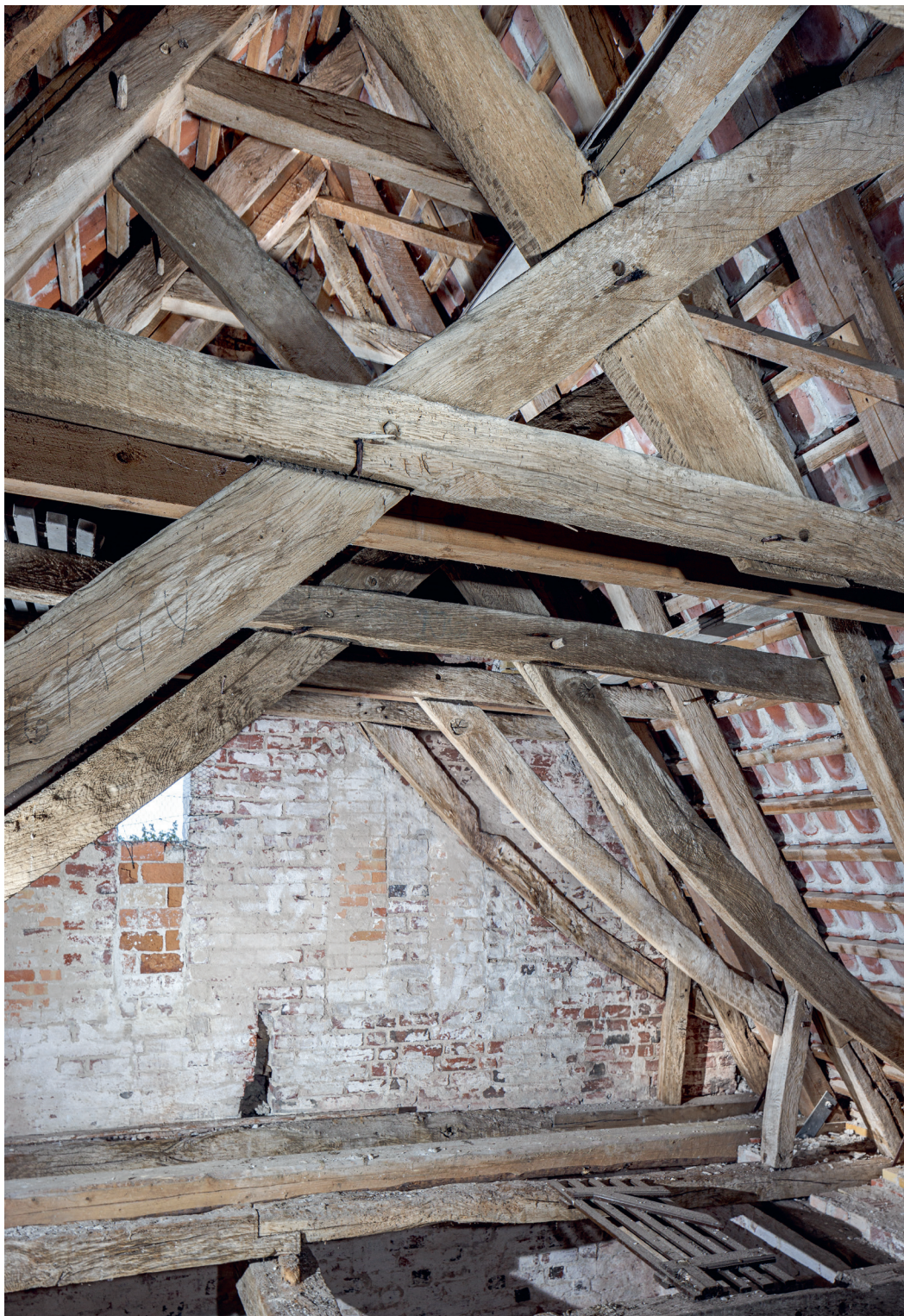
Fig. 29. Tårnets tagværk set mod sydøst (s. 3705). Foto Arnold Mikkelsen 2022. – Tower roofing looking south east.
