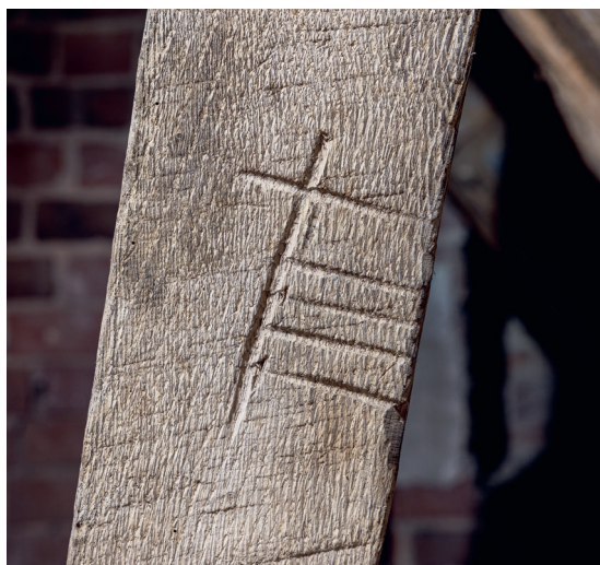
Fig. 33. Tømmermærke, XIII, i nordsiden af skibets tagværk (s. 3704). Foto Arnold Mikkelsen 2022. – Timber marking, XIII, in the north side of the nave roofing.
