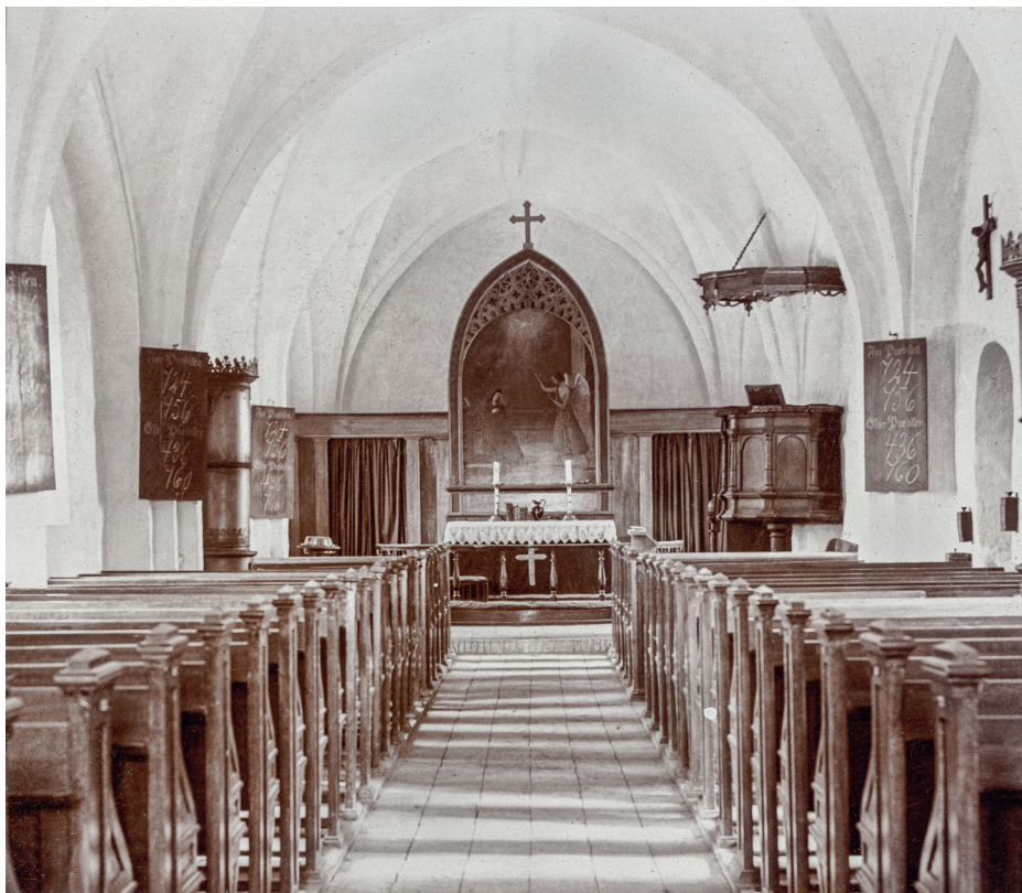
Fig. 35. Indre set mod øst. Foto R. Hansen, Ringe, slutningen af 1800-tallet. I Ringe Lokalhistoriske Arkiv. – Interior looking east, end of 1800s.
