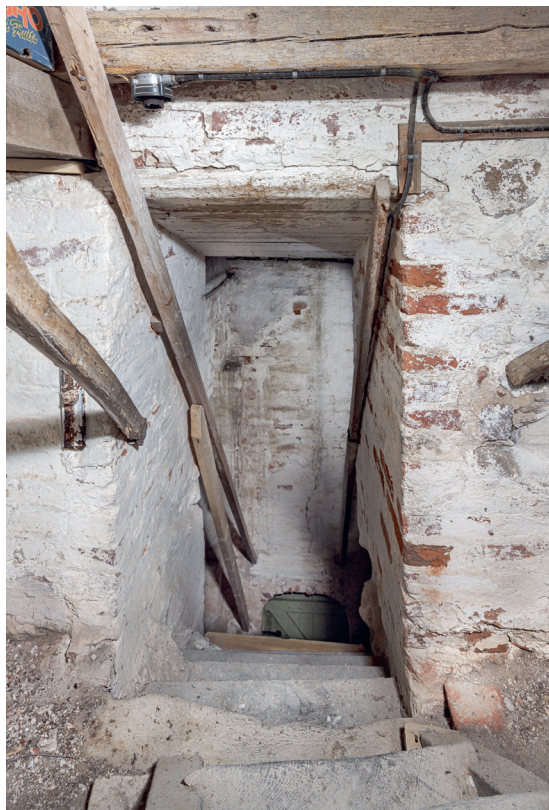
Fig. 22. Overdør til trappehuset set mod syd (s. 3701). Foto Arnold Mikkelsen 2022. – Inside of overdoor to stairwell looking south.
