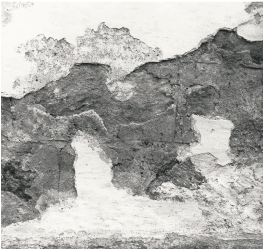
Fig. 31. Kvaderindridsning på skibets nordfacade øst for vestvinduet (s. 4134). Foto Robert Smalley 1988. I NM. – Ashlar carving on the north facade of the nave, east of the western window.
