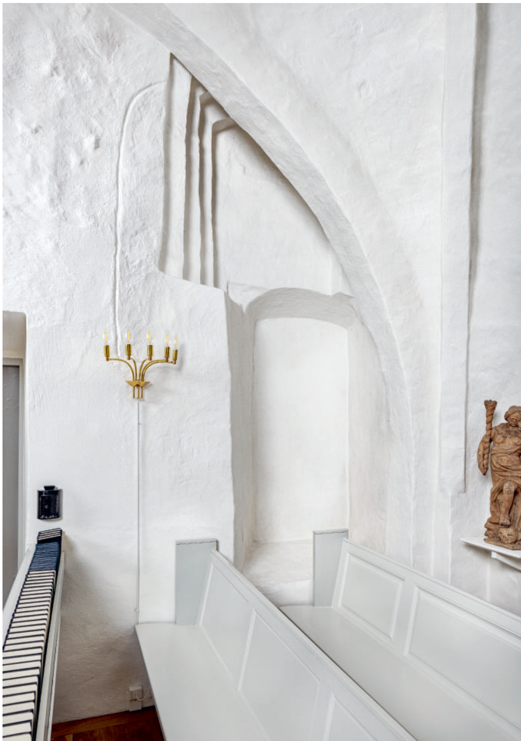
Fig. 15. Tilmurede åbninger i skibets sydøsthjørne, set fra nord. Tv. indridset spor af romansk \dagger vindue (s. 4115). Th. senmiddelalderligt \dagger vindue og \dagger dør til \dagger herskabspulpitur, o. 1736 (s. 4117 og 4126). Foto Arnold Mikkelsen 2023. – Bricked-up openings in the south east corner of the nave, seen from the north. Left: incised trace of a Romanesque \dagger window. Right: Late Medieval \dagger window and \dagger door to the \dagger family gallery, c. 1736.
