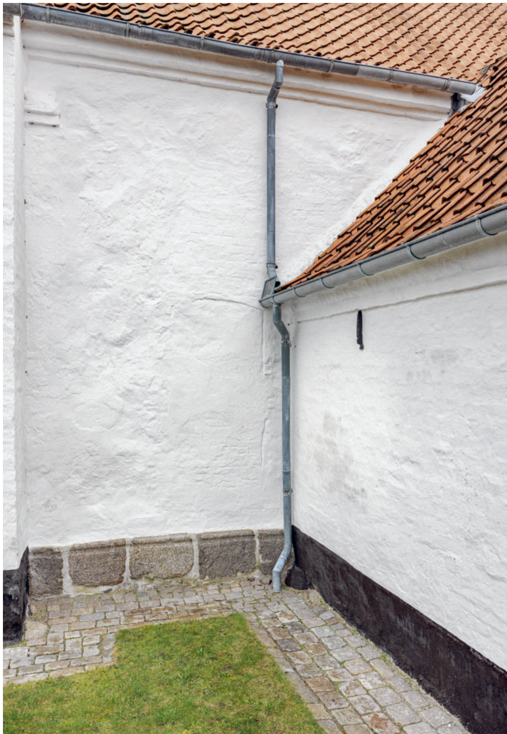
Fig. 16. Tilmuret, senmiddelalderligt \dagger vindue og \dagger dør til \dagger therskabspulpitur, o. 1736, i skibets sydmur, set fra syd (s. 4117 og 4126). Foto Arnold Mikkelsen 2024. – Bricked-up Late Medieval \dagger window and \dagger door to the \dagger family gallery, c. 1736, in the nave's south wall, seen from the south.
