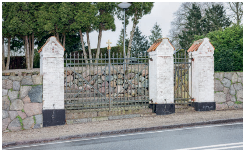
Fig. 5. Kirkegårdens tidligere hovedindgang, opført 1931 og ombygget 1942-43, set fra sydvest (s. 4112). Foto Arnold Mikkelsen 2024. – The churchyard's former main entrance, built in 1931 and rebuild in 1942-43, seen from the south west.
