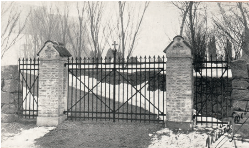
Fig. 92. Kirkegårdens tidligere hovedindgang, opført 1931 og før ombygningen 1942/43, set fra syd (s. 4113). Foto i NM. – The churchyard's former main entrance, built in 1931, before the rebuilding in 1942/43, seen from the south.
