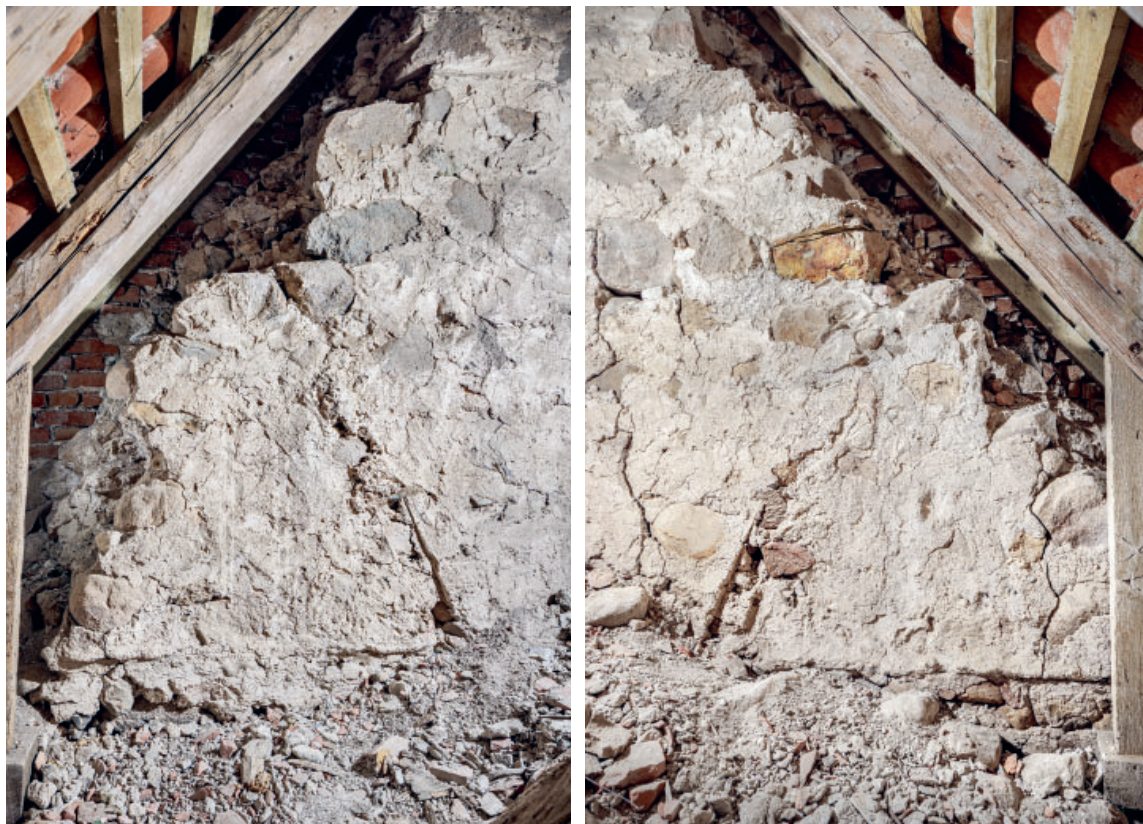
Fig. 25–26. Skibets østgavl med aftryk af romansk tagværk, set mod øst (s. 4133). 25. Nordre del. 26. Søndre del. Foto Arnold Mikkelsen 2024. – The nave's eastern gable with impressions of Romanesque roofing, looking east. 25. Northern part. 26. Southern part.
