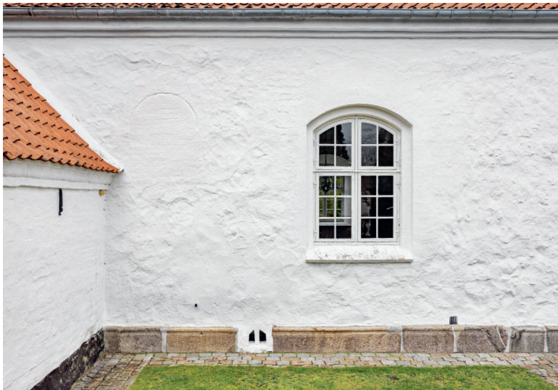
Fig. 12. Vinduer på skibets sydside. Tv. tilmuret romansk \dagger vindue (s. 4115). Th. vindue fra o. 1930 hvorover stik fra senmiddelalderligt \dagger vindue (s. 4117 og 4132). Foto Arnold Mikkelsen 2024. – Windows on the south side of the nave. Left: a bricked-up Romanesque \dagger window. Right: a window from c. 1930 with the arch of a Late Medieval \dagger window above it.
