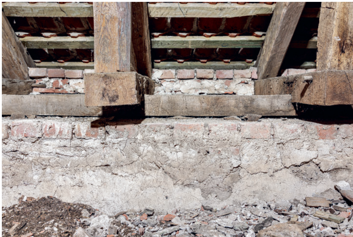
Fig. 30. Romanske pudslag på skibets nordvæg over hvælvene (s. 4115). Foto Arnold Mikkelsen 2024. – Romanesque layers of plaster on the nave's north wall above the vaults.
