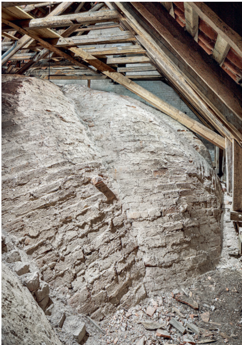
Fig. 27. Skibets vestlige hvælv set mod vest (s. 4118). Foto Arnold Mikkelsen 2024. – The nave's western vault looking west.
