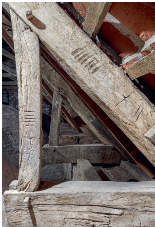
Fig. 26. Tømmernumre på langhusets tagværk i nordsiden set mod vest (s. 4216). Foto Arnold Mikkelsen 2024. – Carpenter's marks on the nave's roofing in the northern side looking west.
