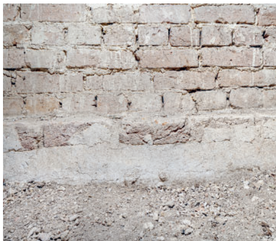
Fig. 101. Romanske pudslag på skibets nordvæg over hvælvet (s. 4199). Foto Arnold Mikkelsen 2024. — Romanesque plastering on the nave's north wall above the vault.
