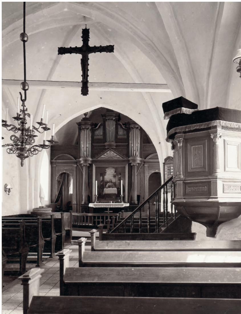
Fig. 32. Indre set mod øst. Foto Kristian Hude 1905. I NM. – Interior looking east.
