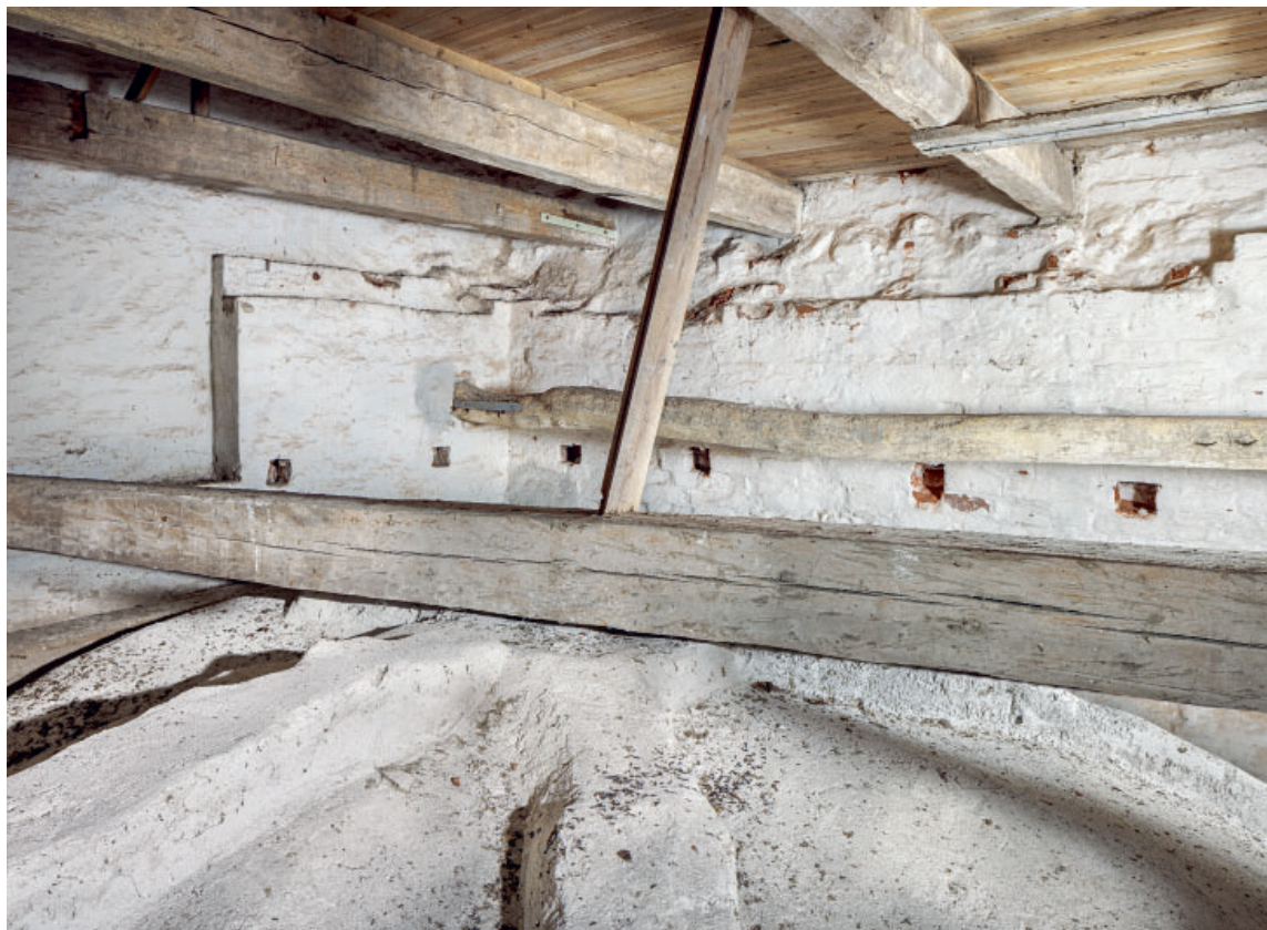
Fig. 16. Tårnets hvælv og murværk i andet stokværk set mod nordvest (s. 4204). Foto Arnold Mikkelsen 2024. – Tower vault and masonry in the lower intermediate floor looking north west.
