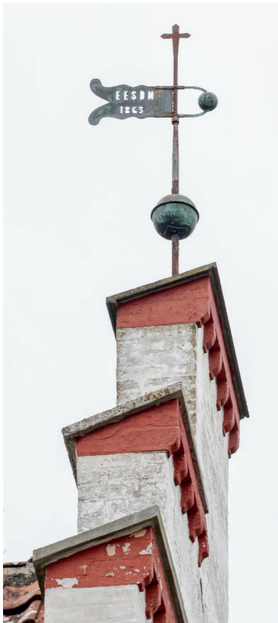
Fig. 28. Vindfløj, 1863, på korets østgavl (s. 4218). Foto Arnold Mikkelsen 2024. – Weather vane, 1863, atop the chancel's east gable.
