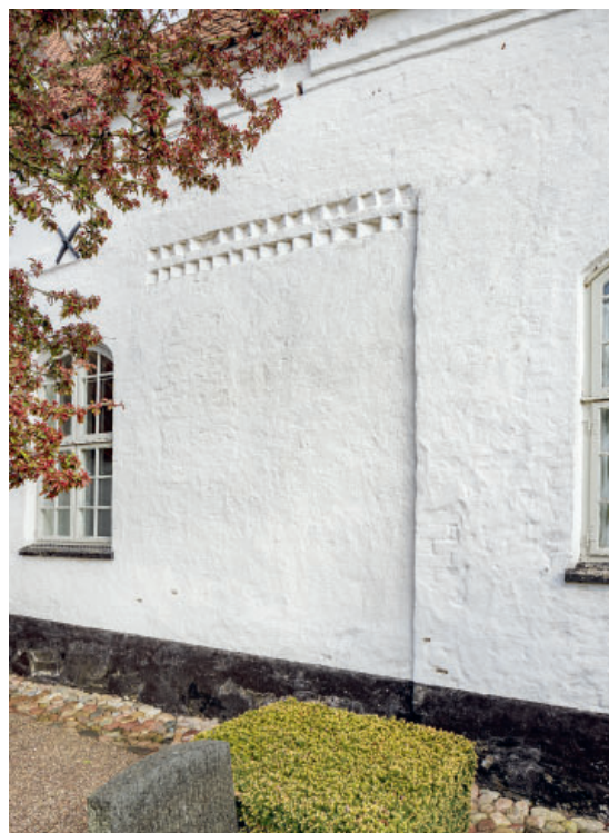
Fig. 13. Skibets romanske sydfacade med tilmuret \uparrow vindue, lisen og savskifte (s. 4199). Foto Arnold Mikkelsen 2024. – The nave's Romanesque south facade with bricked-up \uparrow window, lesene, and sawtooth course.
