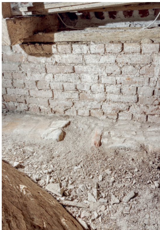
Fig. 102. Hul til loftsbjælke i langhuskorets murkrone og murforhøjelse set mod syd (s. 4201 og 4205). Foto Arnold Mikkelsen 2024. — Hole for a ceiling beam in the nave-chancel's upper wall and wall heightening looking south.
