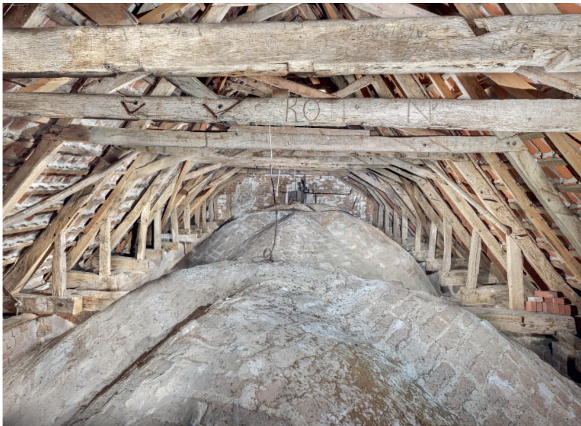
Fig. 27. Langhusets hvalv og tagværk set mod vest (s. 4205 og 4215). Foto Arnold Mikkelsen 2024. – Vault and roofing of the nave looking west.
