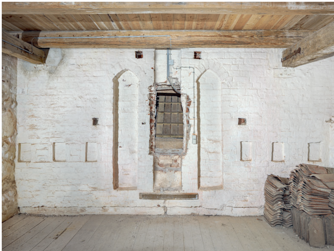
Fig. 16. Vestforlængelsens gavltrekan set mod øst fra tårnets mellemstokværk (s. 4289). Foto Arnold Mikkelsen 2024. – The western extension's gable looking east from the intermediate floor of the tower.
