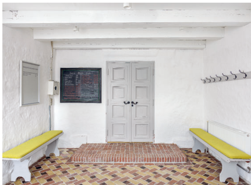
Fig. 18. Våbenhusets indre set mod nord (s. 4291). Foto Arnold Mikkelsen 2024. – Porch interior looking north.
