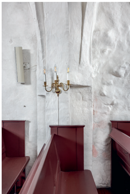
Fig. 96. Hvælpille mellem langhusets andet og tredje fag (s. 4289 og 4291). Foto Arnold Mikkelsen 2024. – Vault pier between the second and third bays of the nave-chancel.
