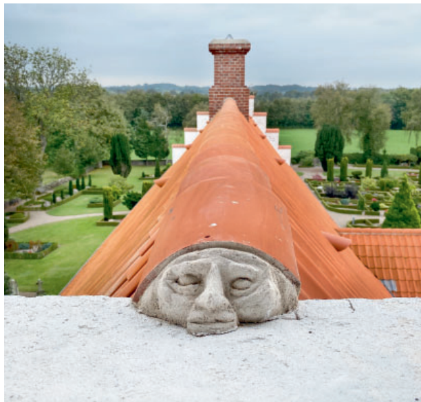
Fig. 106. Mørtelhoved, 2021, ved langhusets tagryg set mod øst (s. 4299). Foto Pia K. Lindholt 2024. — Mortar head, 2021, at the ridge of the nave-chancel's roof.
