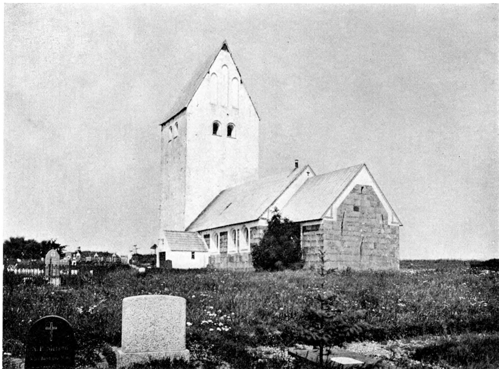
Fig. 1. Hjäremaal. Ydre, set fra Sydøst.
