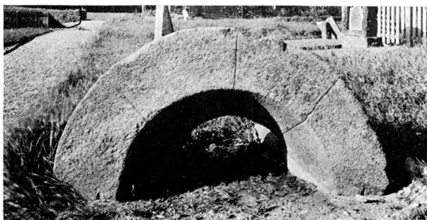
Fig. 4. Snedsted. Romansk Vinduesoverligger med falske Fuger (S. 472).
