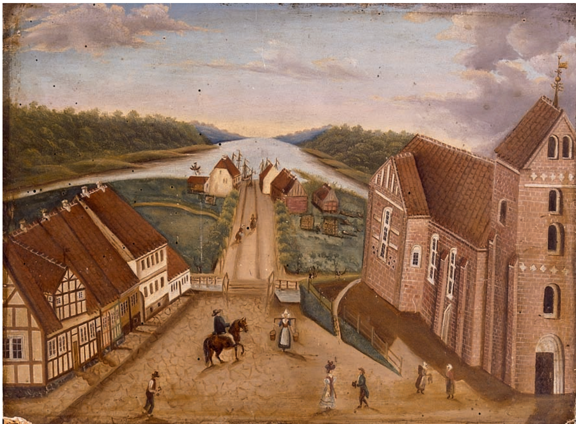
Fig. 3. Kirkegade og broen til den nyanlagte havn set fra vest i 1830'erne. Tv. husrækken mellem Grønnegade og Mølleåen. Teglstenskirken står med hvidkalkede blændinger og hvide vinduesrammer af træ. Det senmiddelalderlige \dagger tårn (s. 99) fremtræder i sin gamle skikkelse før Thielemanns ændringer i 1850'erne. Den tidligere kirkegård er omdannet til en plads (s. 81). Maleri i Vejle Museum. – The street Kirkegade and the bridge to the newly established harbour viewed from the west in the 1830s. Left: The row of houses between Grønnegade and Mølleåen. The brick church stands with whitewashed recesses and white window frames of wood. The Late Medieval \dagger tower appears in its old form before Thielemann's alterations in the 1850s. The former churchyard has been converted into a square.
