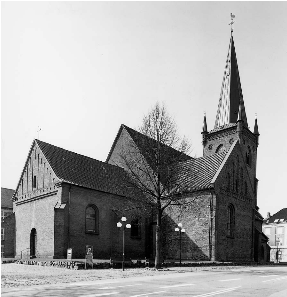
Fig. 6. Kirken set fra nordøst. Foto HW 2004. – The church viewed from the north east.
