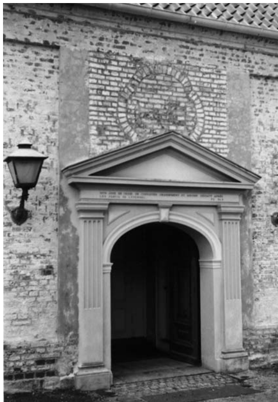
Fig. 12. Nordportal 1851-52 med spor efter oprindeligt firpasformet \dagger vindue ovenover, jf. fig. 8c (s. 507). Foto Erik Einar Holm 1981 i Lokalhistorisk Arkiv. – North door 1851-52 with traces of original quatrefoil \dagger window above, cf. fig. 8c.
