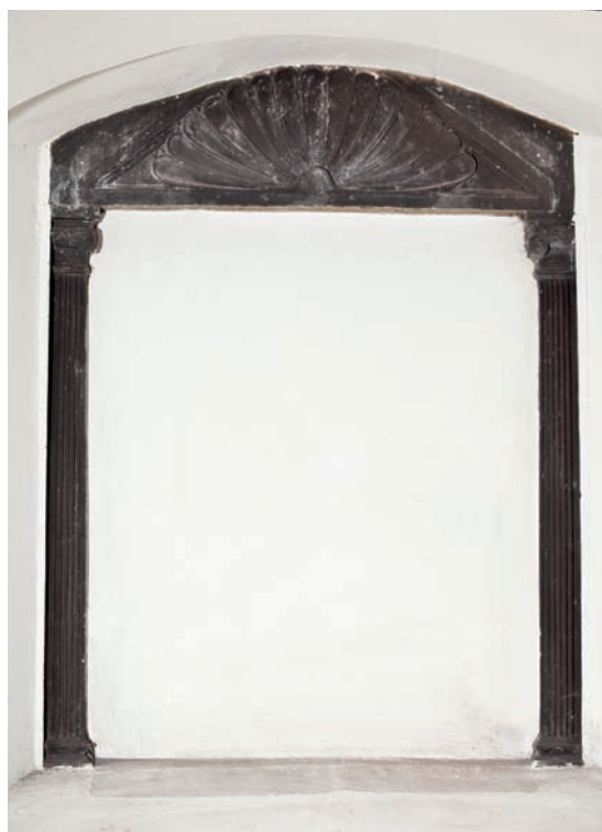
Fig. 11. Tilmuret vindue med indfatning af sort kalksten i væggen bag nichegraven (s. 1035). Foto AM 2009. – Walled-up window with frame of black limestone in the wall behind the tomb-recess.
