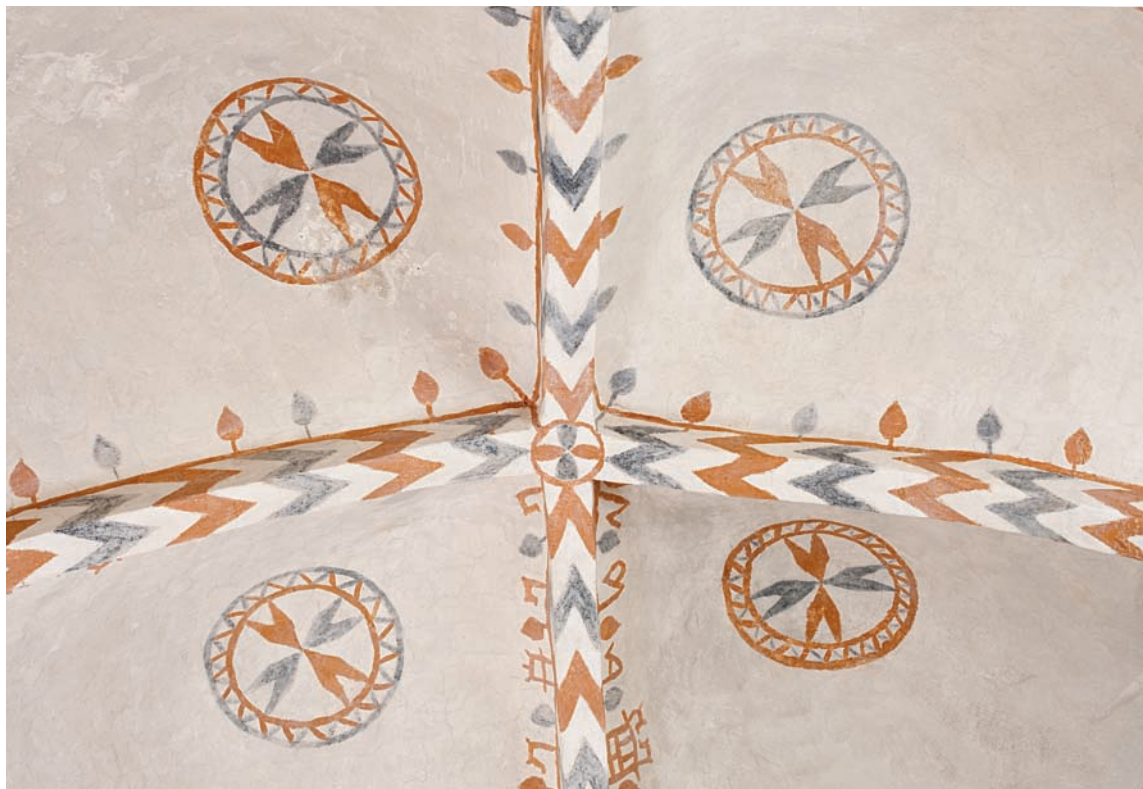
Fig. 11. Kalkmalet dekoration på korets hvælv, o. 1520, set mod nordøst (s. 1166). Foto AM 2009. – Mural decoration on the chancel vault, c. 1520, looking northeast.
