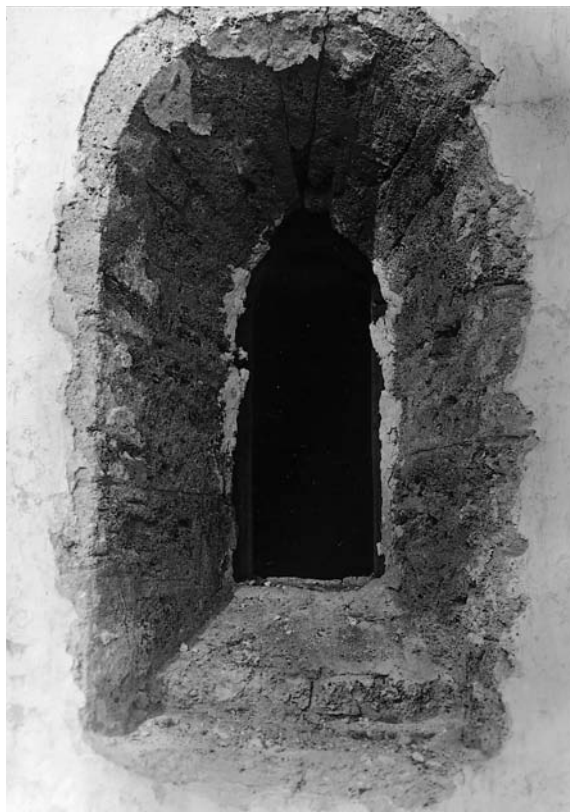
Fig. 7-8. 7. Romansk vindue i korets østgavl set udefra ved genåbningen 1939 (s. 1186). Den senere udtagne \dagger vinduesramme var endnu på plads. 8. \dagger Vinduesrammen efter udtagningen 1939. Trærammens yderside med glasfals (s. 1187). Foto Ejnar V. Jensen 1939. – 7. Romanesque window in the east gable of the chancel, seen from outside at the reopening in 1939. 8. The \dagger window frame after it was removed in 1939. The outer side with recess for glass.
