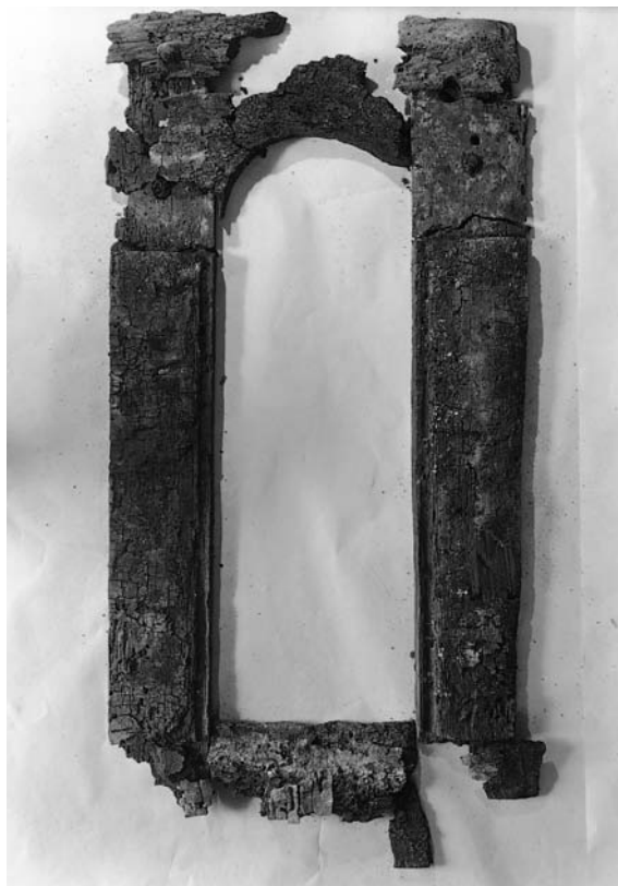
Fig. 7-8. 7. Romansk vindue i korets østgavl set udefra ved genåbningen 1939 (s. 1186). Den senere udtagne \dagger vinduesramme var endnu på plads. 8. \dagger Vinduesrammen efter udtagningen 1939. Trærammens yderside med glasfals (s. 1187). Foto Ejnar V. Jensen 1939. – 7. Romanesque window in the east gable of the chancel, seen from outside at the reopening in 1939. 8. The \dagger window frame after it was removed in 1939. The outer side with recess for glass.
