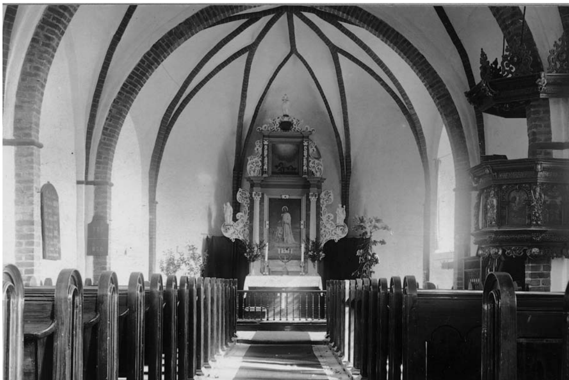
Fig. 16. Indre set mod øst efter hovedstandsættelsen 1875-76. De forstærkede gjordbuer står i blank mur, og hvælvrubberne har en †murstensdekoration (s. 1225). Foto 1925. – Interior looking east after the major restoration in 1875-76. The reinforced transverse ribs have plain surfaces, and the vault ribs have †brick decoration.
