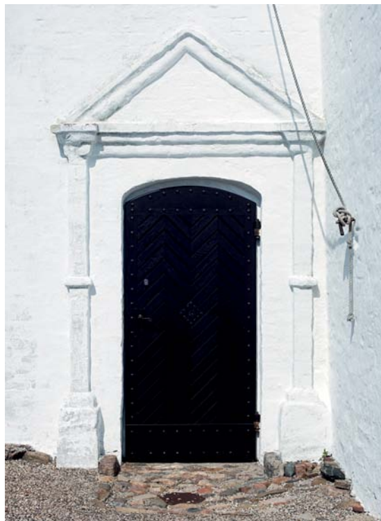
Fig. 14. Dør, o. 1800, i klassicistisk indramning i tårnets sydмур (s. 1353). Foto EN 2010. – Door in the south side of the tower, c. 1800.
