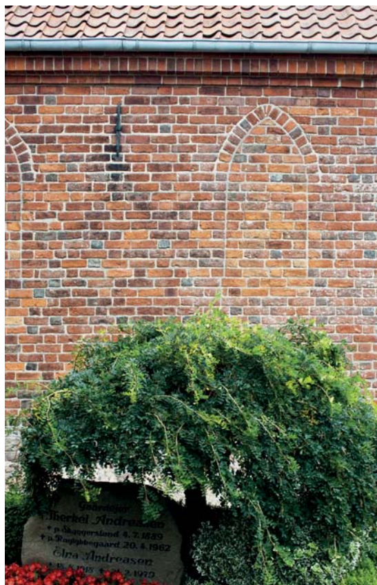
Fig. 8. Udsnit af skibets sydvmur (s. 1380). Foto Mogens Vedsø 2011. – South side of nave, section.
