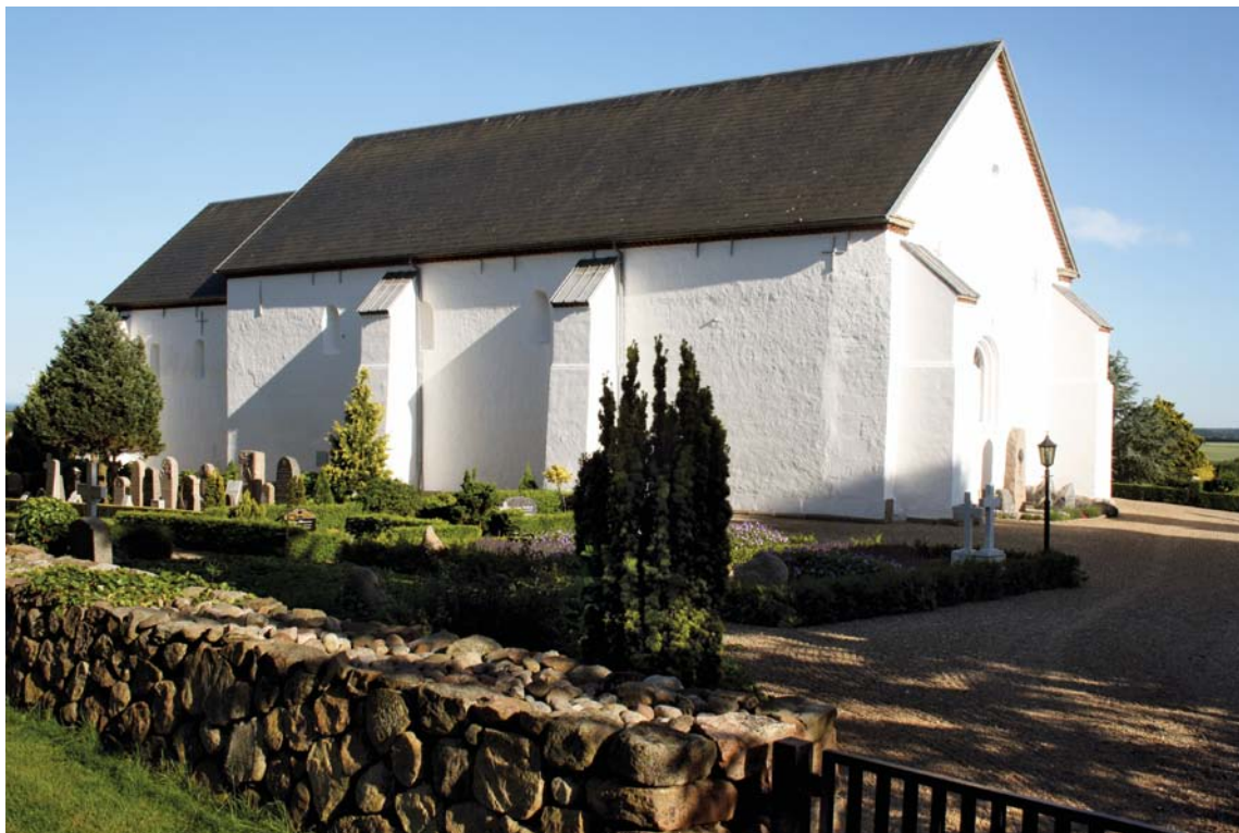
Fig. 10. Kirken set fra nordvest. Foto EN 2011. – The church seen from the north west.
