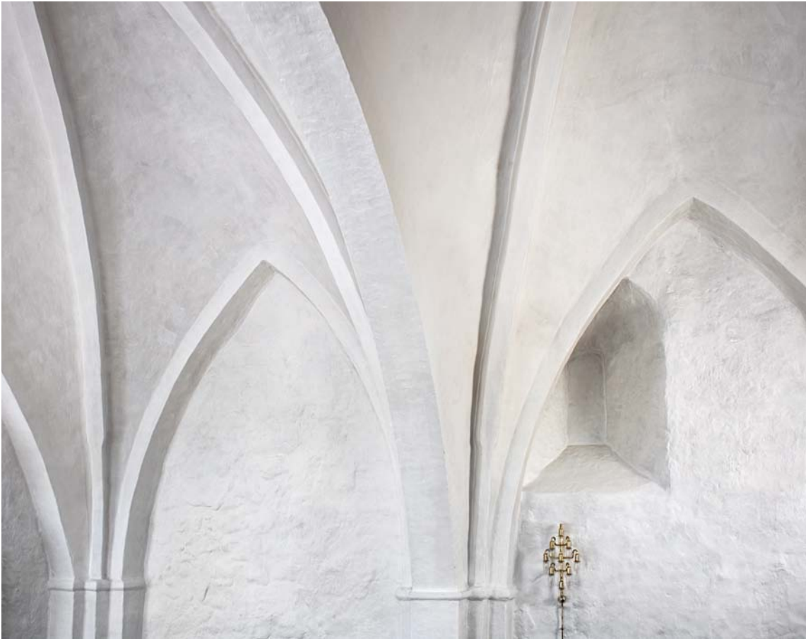
Fig. 11. Udsnit af korets nordvæg med indbyggede hvælv (s. 1491) og tilmuret romansk vindue (s. 1490). Foto AM 2010. – Detail of north wall of chancel with built-in vaults and bricked-up Romanesque window.
