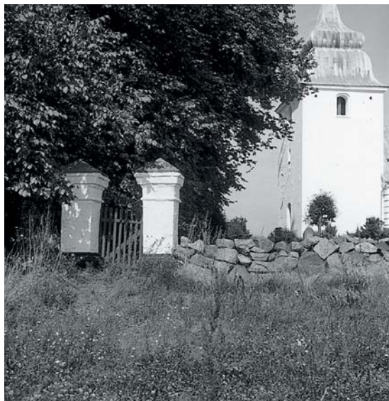
Fig. 42. †Fodgængerlåde, o. 1786(?), i det søndre kirkegårdsdige, nedtaget 1980 (s. 1549). Foto Morten Aaman Sørensen 1972. – †Pedestrian gate, c. 1786(?), in the southern churchyard wall, removed in 1980.
