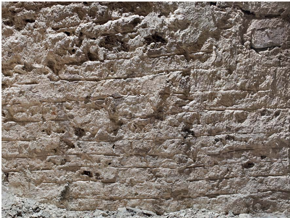
Fig. 6. Udsnit af frådstensmurværk med kvaderridsning. Skibets sydvæg over hvælv (s. 1601). Foto AM 2012. – Detail of tuff masonry with ashlar dressing. South wall of nave above the vaulting.
