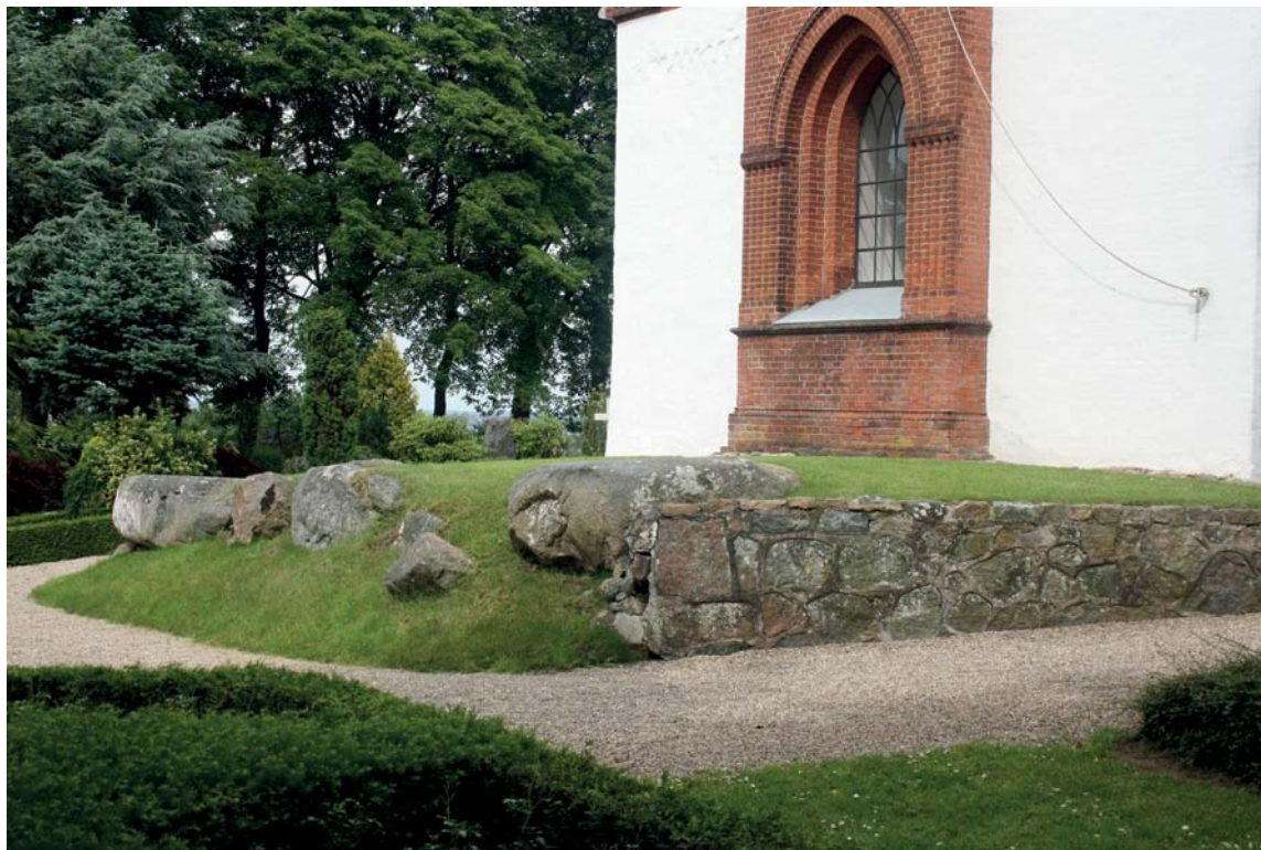
Fig. 32. Stensyld til nedbrudt \dagger tårn set fra sydvest (s. 1604) med nyere støttemur af kløvsten mod syd. I skibets vestmur ses den murede underbygning til klokkekammen fra 1871 (s. 1604) og nord herfor øverst en rest af en romansk rundbuefrise (s. 1601). Foto EN 2012. – Stone foundation for demolished \dagger tower seen from the south west with a more recent supporting wall of split stone towards the south. In the west wall of the nave, the brick support of the bell cot from 1871 and north of this at the top remains of a Romanesque rounded-arch frieze.
