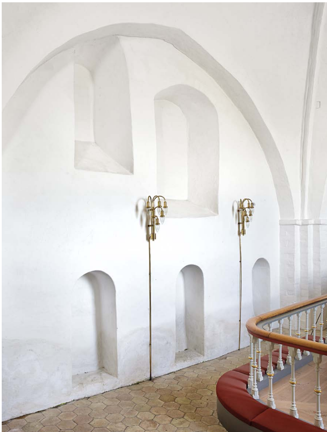
Fig. 10. Korets nordvæg med rundbuede nicher (s. 1693) og det vestre af to romanske vinduer samt et yngre vindue, der er kommet til i forbindelse med hvælvslagningen (s. 1691). Foto AM 2012. – North wall of the chancel with round-arched niches, and the westernmost of two Romanesque windows.
