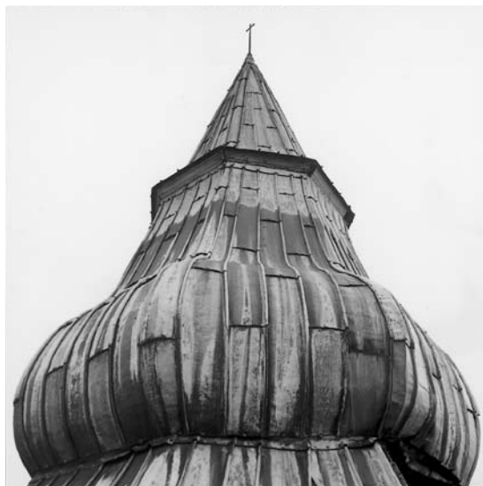
Fig. 10. Tårnets løgspir med ældre blybeklædning set fra stillads (s. 1784). Foto Morten Aaman Sørensen 1978. – Spire of tower with older leading seen from scaffolding.
