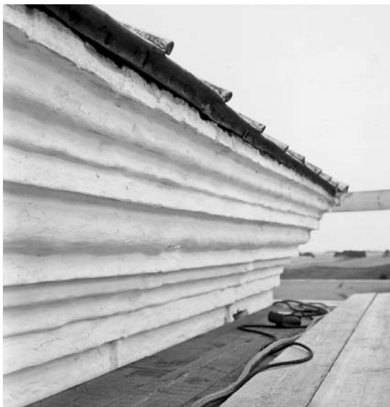
Fig. 9. Kronesims på tårnet set fra stillads (s. 1784). Foto Morten Aaman Sørensen 1978. – Cornice on tower seen from scaffolding.
