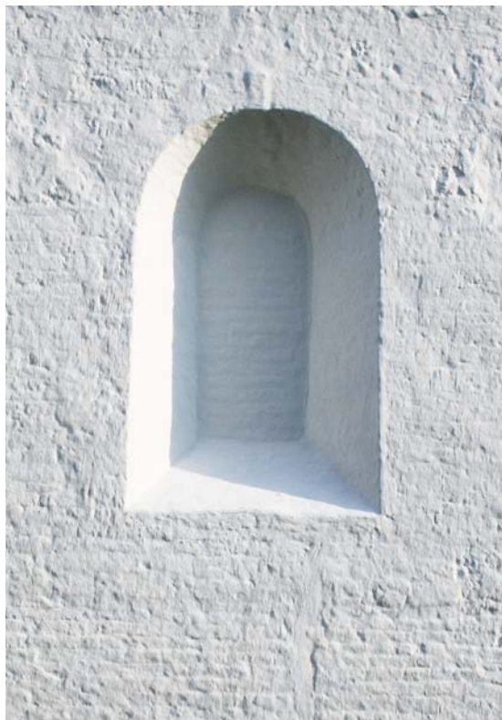
Fig. 44. Skibets nordside med det vestre romanske vindue og frådstensmurværk i tynde skifter (s. 1779). Foto EN 2012. – North side of nave with western window and tuff masonry in thin courses.
