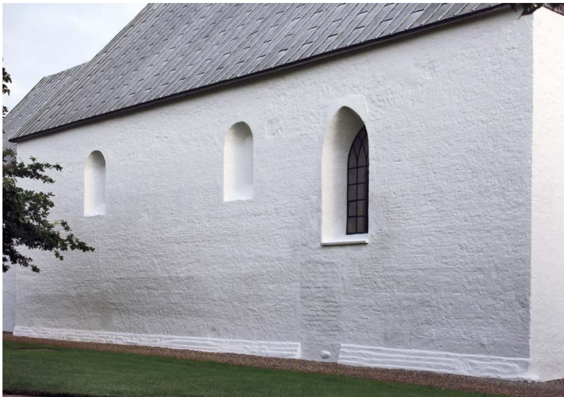
Fig. 43. Skibets nordside set fra nordvest med aftrappet sokkel og frådstensmurværk i tynde skifter (s. 1778 f.). Foto EN 2012. – North side of nave seen from the north west with stepped base and tuff masonry in thin courses.
