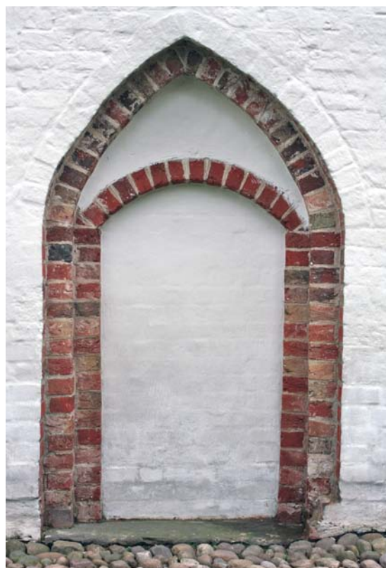
Fig. 58. Tilmuret (†)dør i tårnets nordside (s. 1942) med romansk gravsten (nr. 1) som tærskel (s. 1978). Foto Ebbe Nyborg 2013. – Bricked-up door in north side of tower with Romanesque tombstone as threshold.
