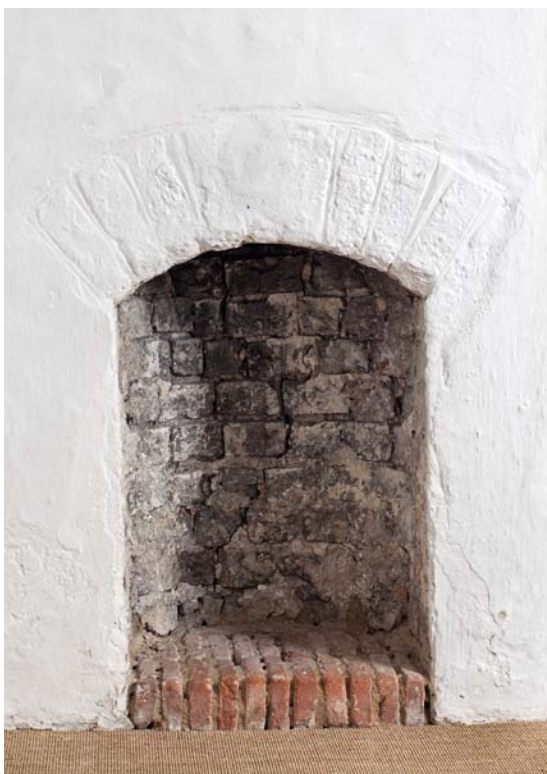
Fig. 8. (†)Kamin i våbenhusets vestmur (s. 1943). Foto Arnold Mikkelsen 2013. – Chimneypiece in west wall of porch.
