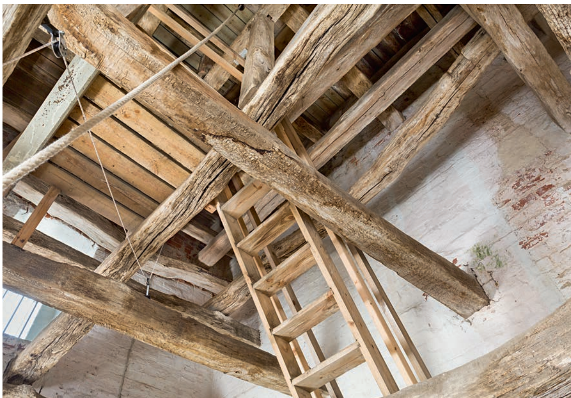
Fig. 17. Bjælkelag i forskellige højder i tårnets indre med en funktion som murankre (s. 2353). Foto Arnold Mikkelsen 2015. – Tiers of beams used as anchors.
