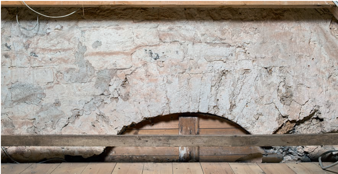
Fig. 7. Rundbuestikket over skibets syddør set fra våbenhusets loft (s. 2392). Foto Arnold Mikkelsen 2016. – Rounded arch above south door of nave seen from porch ceiling.
