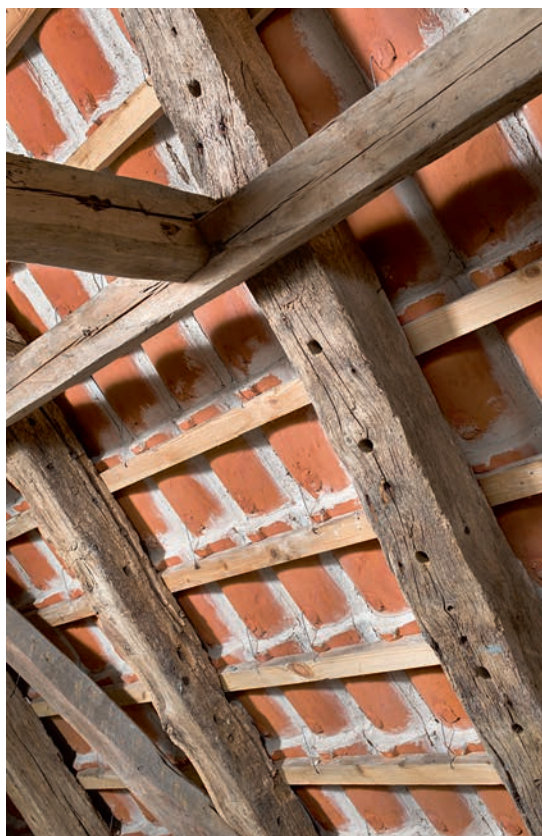
Fig. 12. Spær o. 1475-85 i skibets nordside (s. 2396). Foto Arnold Mikkelsen 2016. – Rafter in north side of nave.
